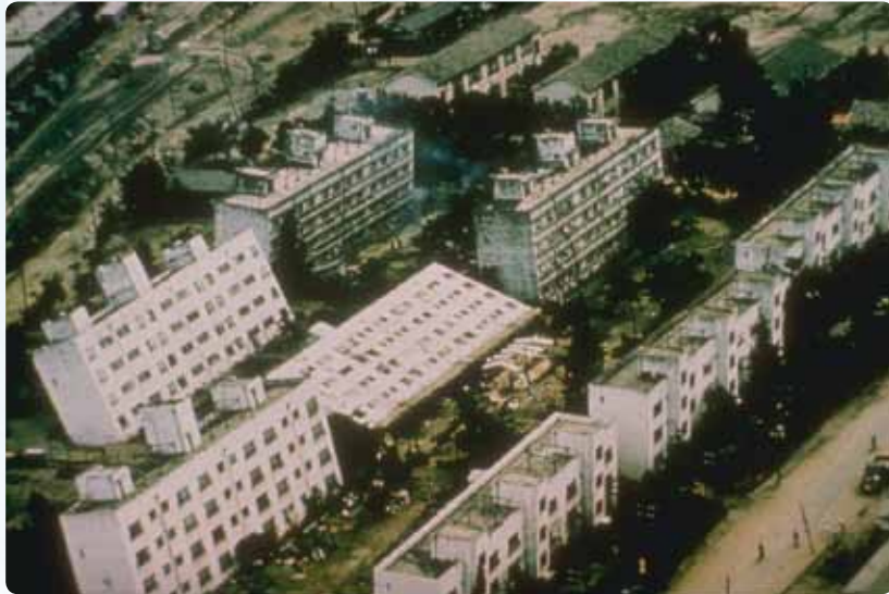
Abbildung 3: Folgen eines Erdbebens in Niigata, Japan, am 16. Juni 1964. Durch die Erdstöße kam es zu einem Bodenfließen, so dass zahlreiche Häuser als Ganzes umkippten.
