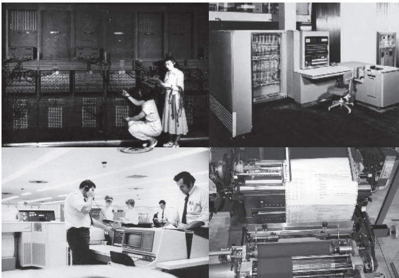
Abbildung 3: Computer der 1. bis 3. Generation: ENIAC, 1945 (links oben); IBM-701, 1952 (rechts oben); UNIVAC-494 des Grazer Rechenzentrums, 1973 (links unten) und Walzendrucker, 1973 (rechts unten)
