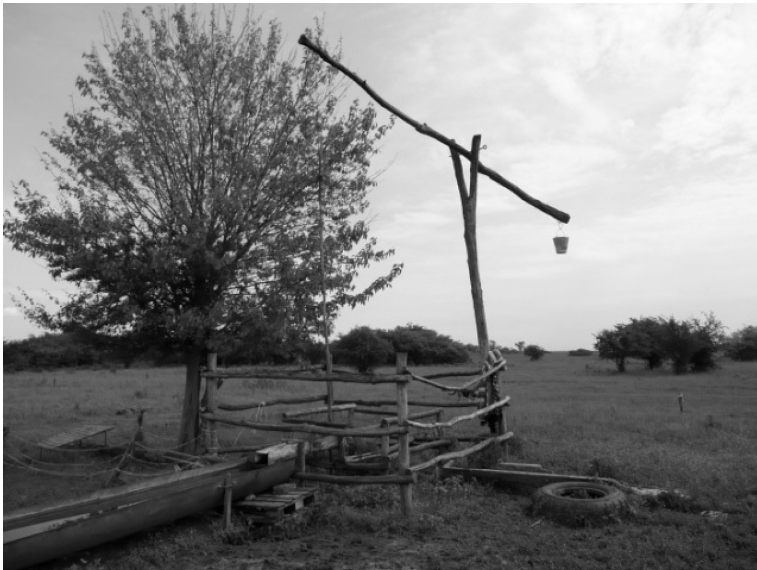
1. ábra Működőképés jó állapotú gémeskút (Fotó: Rákóczi) Figure 1. Operational sweep-pole well with a good state (Photo: Rákóczi)
