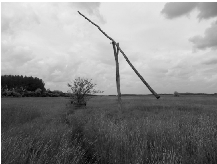
2. ábra. Már károsodott gémeskút (Fotó: Rákóczi) Figure 2. Damaged sweep-pole well (Photo: Rákóczi)
