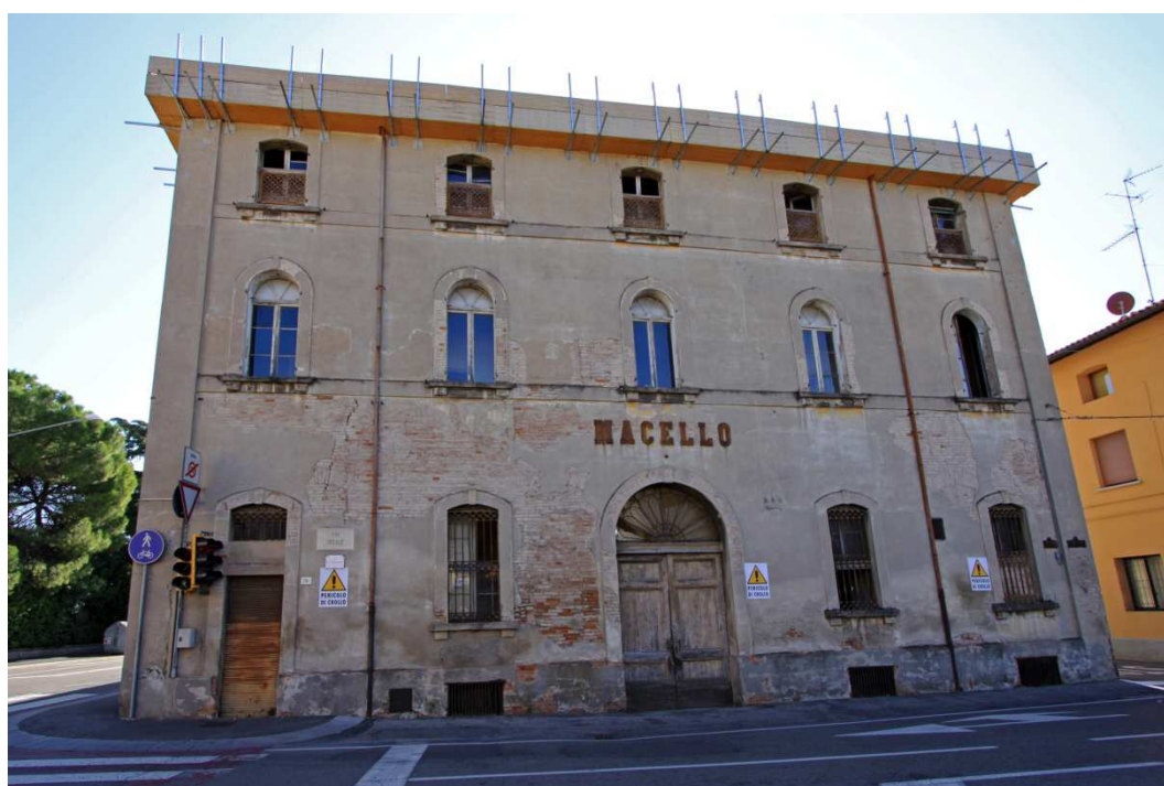
Foto del prospetto principale
