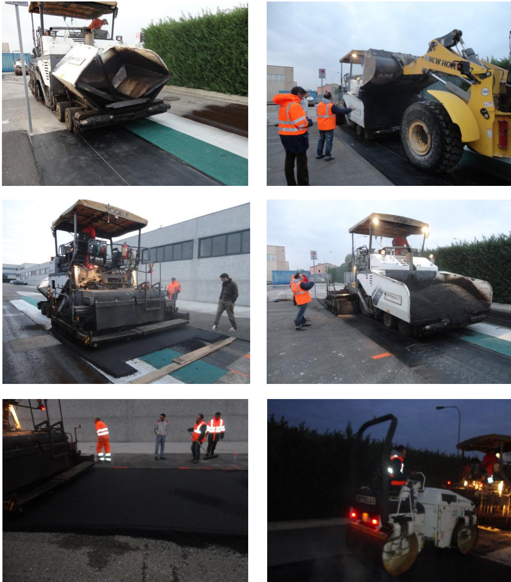
Figura 5.5: fasi di stesa del conglomerato bituminoso.
