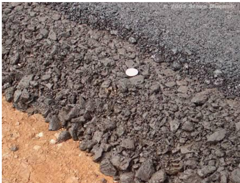
Figura 1.2: Margine di una pavimentazione in costruzione.
