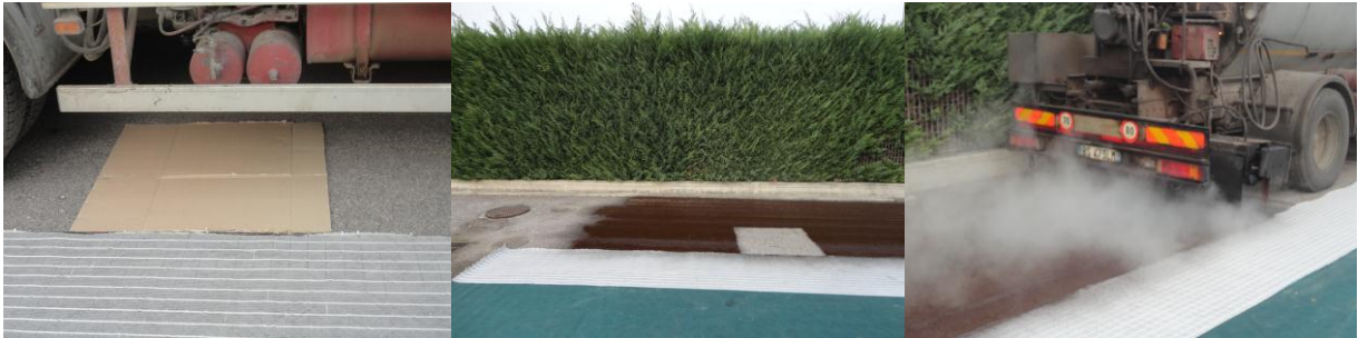
Figura 5.2: fasi di stesa dell'emulsione bituminosa
