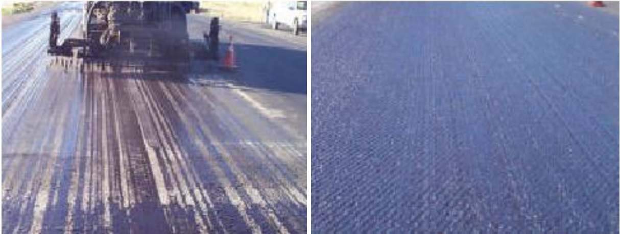
Figura 1.14: Esempi di applicazione dell'emulsione bituminosa: scorretto e corretto.
