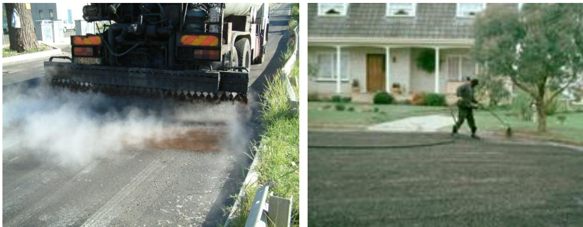
Figura 1.13: Modalità di applicazione dell'emulsione bituminosa.
