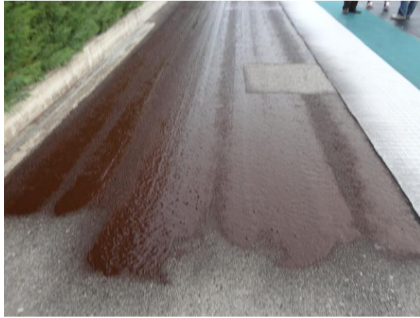
Figura 5.9: dettaglio della stesa di emulsione.
