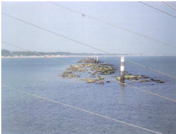
Figura 2.2: Barriere artificiali rigide a Cesenatico.
