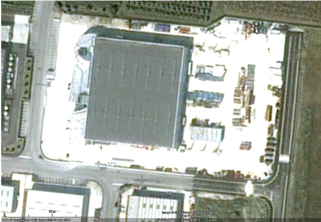
Immagine 7: Vista dal satellite della sede della Lorenzon
