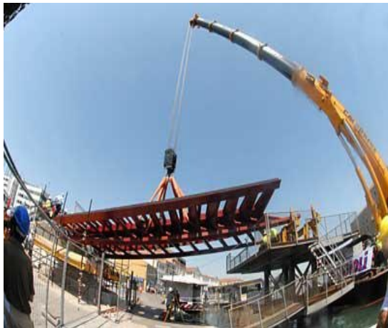
Immagine 24: Posa in opera concio laterale
