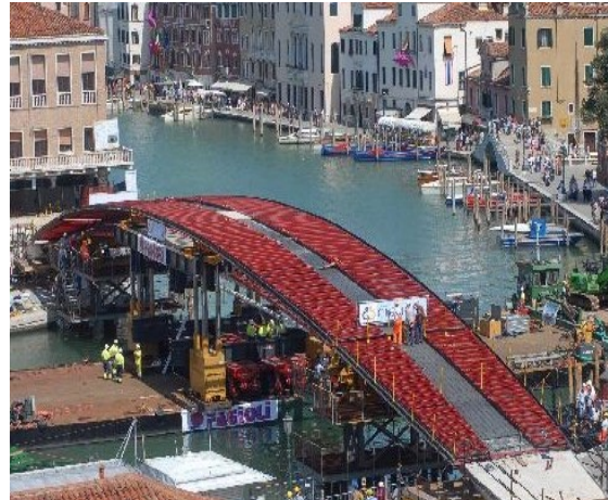
Immagine 23: Posa in opera concio centrale
