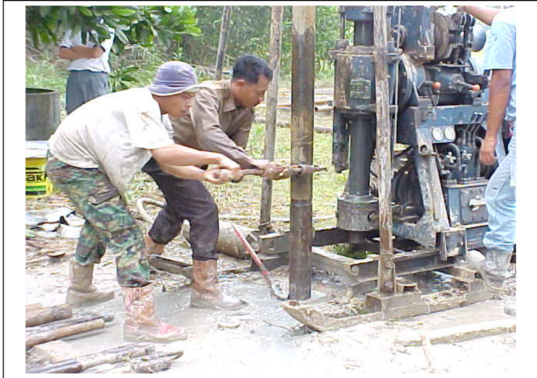
Rajah 4.7 : Kerja-kerja penggerudian dengan menggunakan kaedah Putar Basuh ( Wash Boring )
