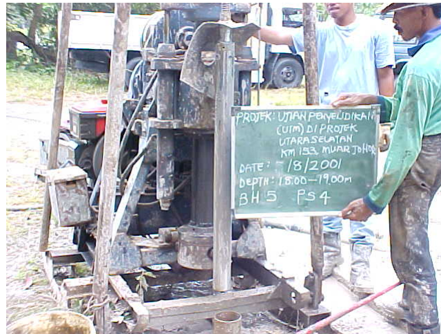
Rajah 3.12: Tiub sampel tanah tak terganggu dikeluarkan dengan menggunakan mesin gerudi
