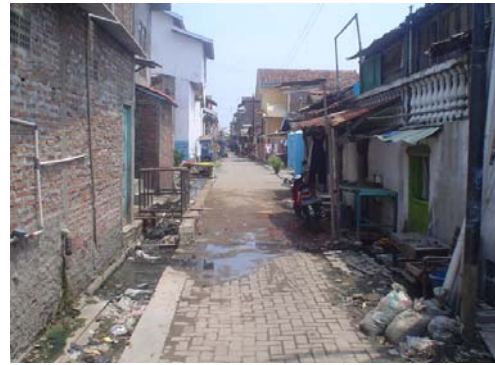
Gambar 4.18 Saluran pembuang di jalan Bader Raya
