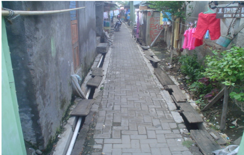
Gambar 4.33 Saluran pembuang di jalan Tikung Baru V
