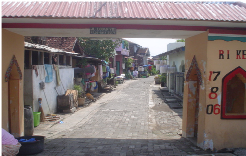
Gambar 4.49 Saluran pembuang di jalan Lodan VIII
