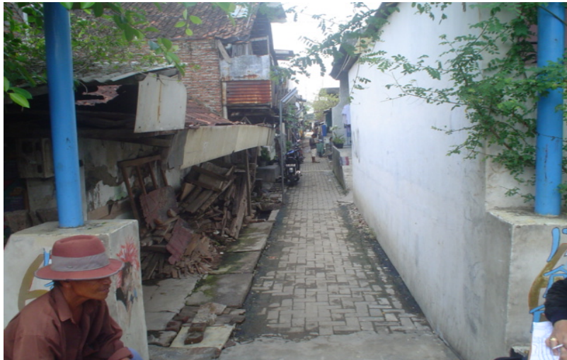
Gambar 4.42 Saluran pembuang di jalan Tengiri V
