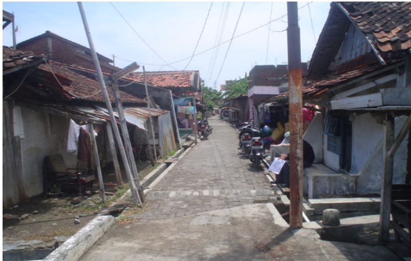
Gambar 4.27 Saluran pembuang di jalan Hasanudin Kecil
