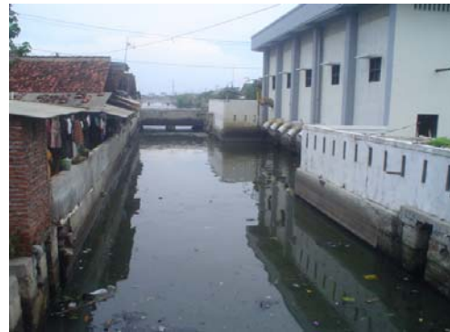
Gambar 4.12 Rumah Pompa untuk Polder Tawang yang masuk ke Kali Baru
