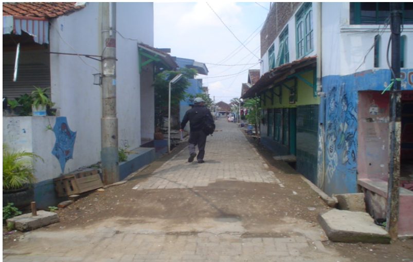
Gambar 4.41 Saluran pembuang di jalan Tengiri IV
