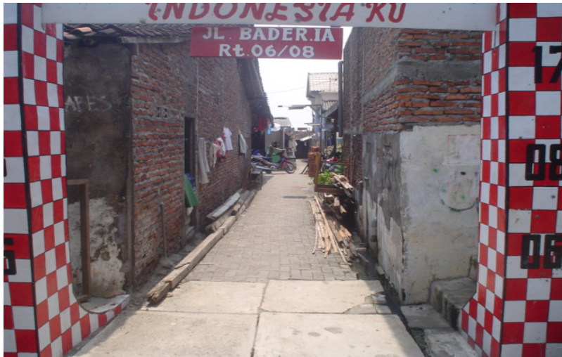
Gambar 4.62 Saluran pembuang di jalan Bader I A
