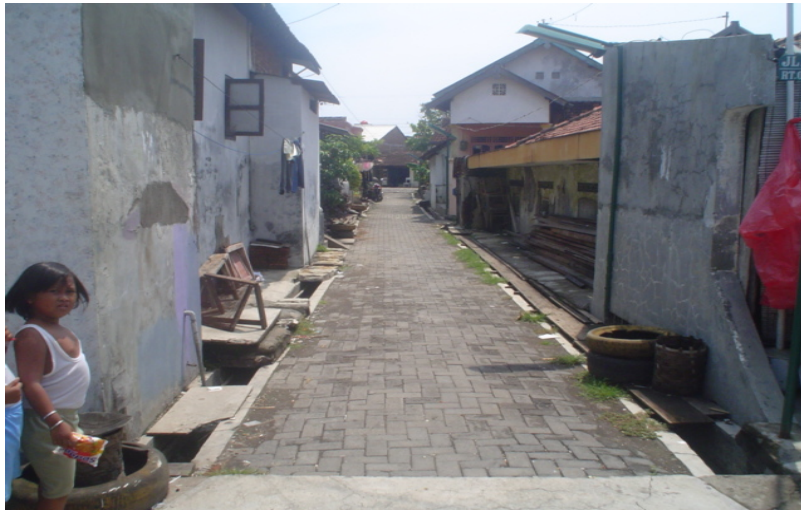
Gambar 4.52 Saluran pembuang di jalan Lodan XI
