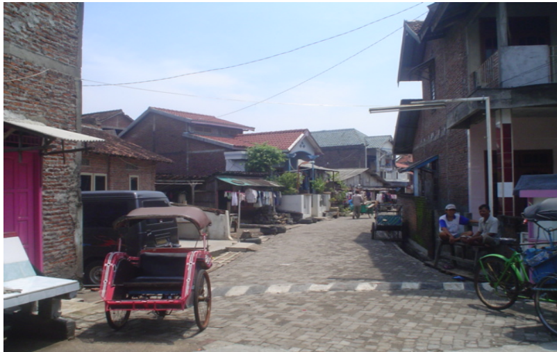
Gambar 4.46 Saluran Pembuang di jalan Lodan V
