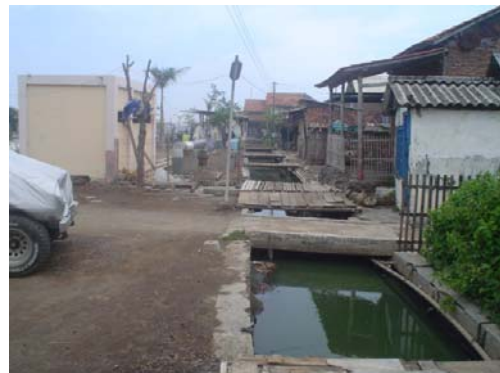
Gambar 4.14 Saluran pembuang di jalan Lodan Raya di sebelah hulu pompa 1
