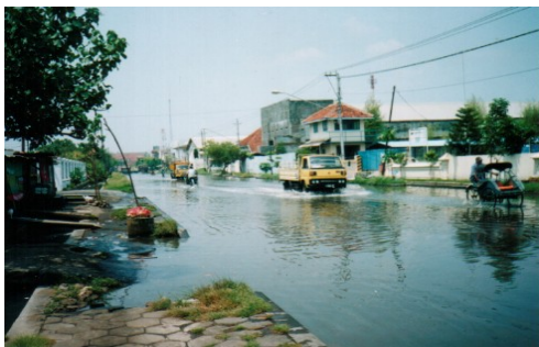
Gambar 4.5 Genangan di jalan Empu Tantular
