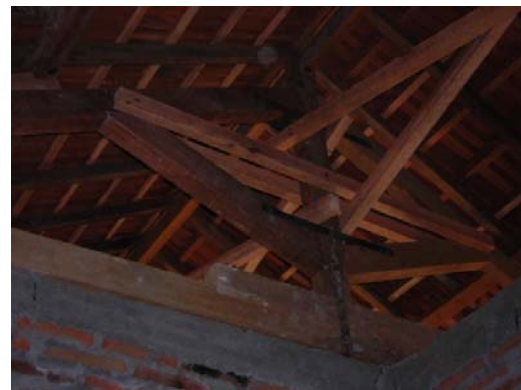
Gbr. Foto Kuda-kuda rumah Percontohan tahan gempa P2KP tipe 24 (Sumber: foto pribadi Bp. Sukawi)
