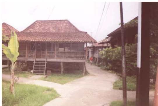
Gambar 2 : Kondisi Jalan Lingkungan (Sumber Dokumentasi Pribadi)
