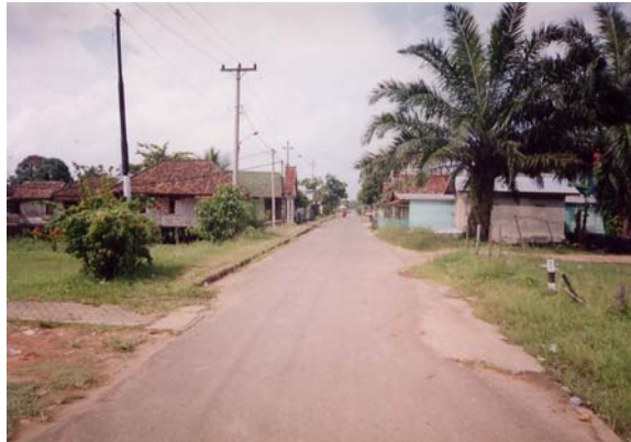
(Gambar 10, Kondisi Jalan Aspal)
