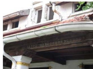
Sedangkan pada tiap-tiap lantai di bagian selasar diberikan aliran-aliran dari beton untuk menampung air hujan yang kemudian dibuang ke bawah tanah melalui selokan terbuka dari beton dengan ukuran lebar 40 cm.
