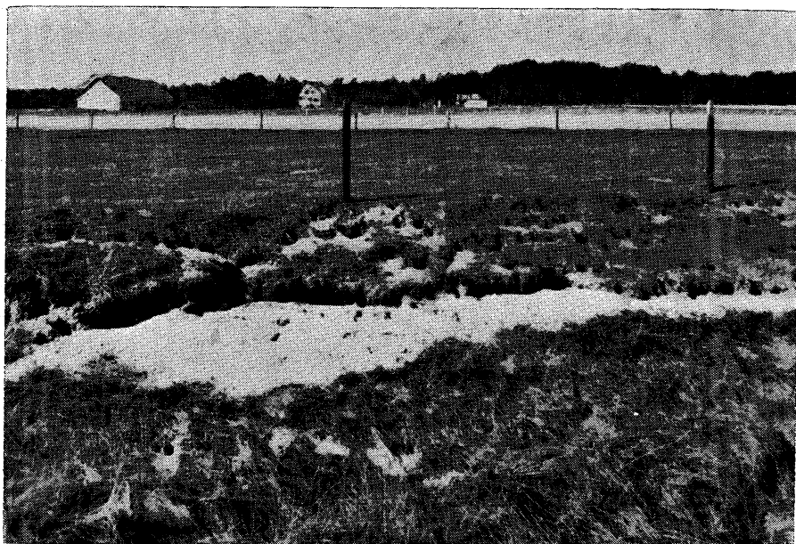
Fig. 31. Genomgrävd kanalvall i Rone myr. Burrows in a canal-wall.
