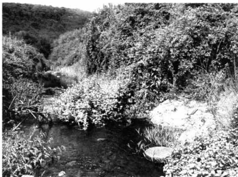
Fig. 12 - Resti del ponte sulla riva destra del rio «Su Pische».
