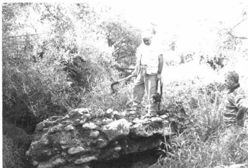
Fig. 10 - Ponte nell'alveo del rio Mannu nei pressi della cartiera.
