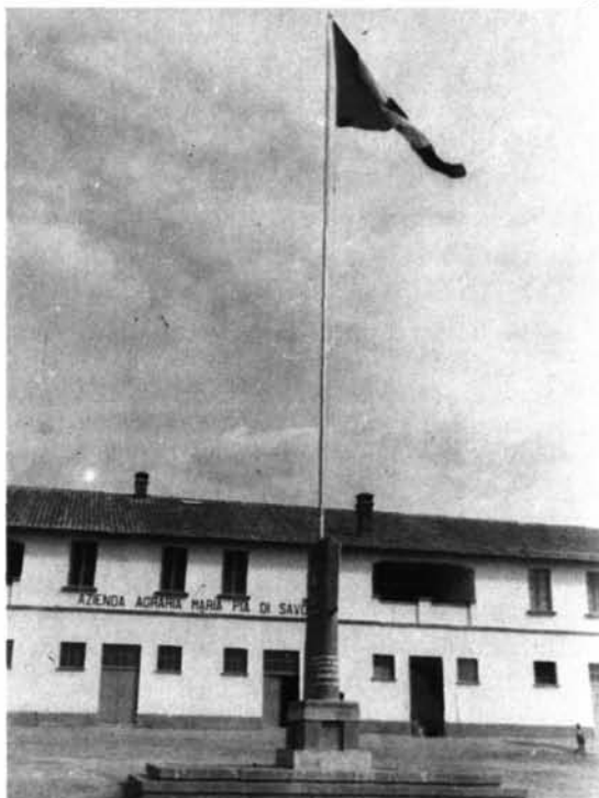
103-104. La "bonifica integrale" della Nurra. L'intervento di bonifica nella vasta regione della Nurra fu una delle grandi iniziative del fascismo in Sardegna. La prima fase dei lavori fu compiuta con la costruzione dell'azienda Maria Pia, ai bordi del golfo di Alghero inaugurata il 13 ottobre 1934 dal principe ereditario Umberto di Savoia. L'8 marzo del 1936 veniva posta la prima pietra della "Casa del fascio" nel nuovo centro di Fertilia (fig. 104: la pergamena "seppellita" insieme con la prima pietra disegnata dal pittore Filippo Figari).
