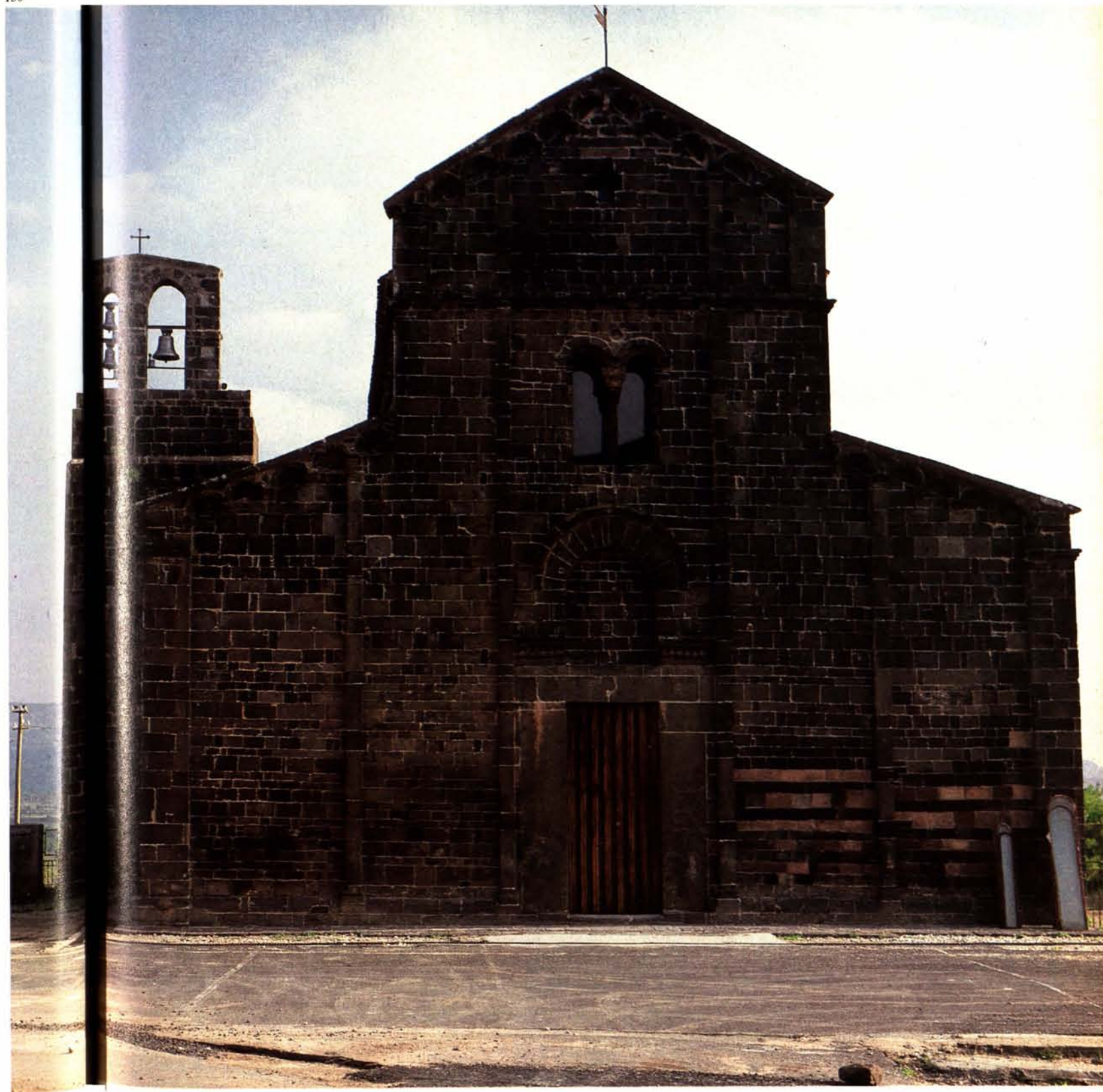
129. La chiesa di S. Maria di Bubalis, tra Ardara e Siligo (XI secolo). Intorno alla metà del Millecento i Benedettini del vicino Monte Santo ricavarono una chiesa dedicata alla Madonna da un edificio termale romano, costruito a strati alternati di trachite nera e di mattoni cotti.
