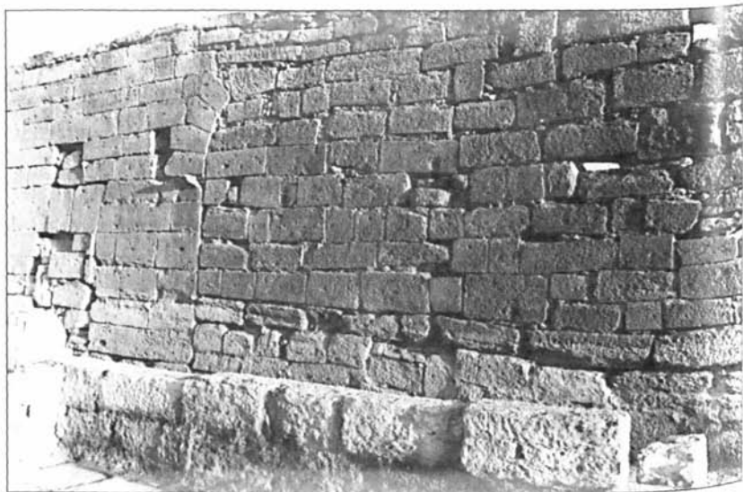
b - Les ouvertures bouchées de l'enceinte sud (on remarque clairement les vestiges de l'arc).
