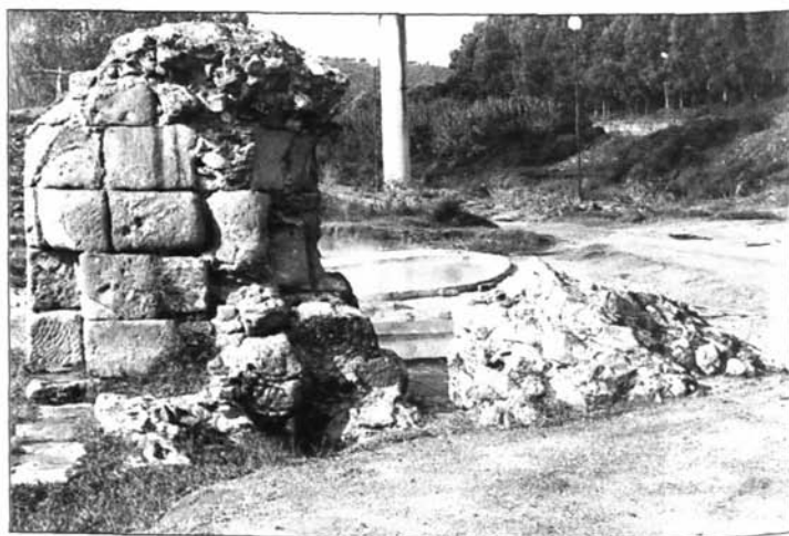
Forum Traiani: Terme I. Il muro E e la contigua vasca F, da Sud (1); dettaglio del medesimo muro, da Est (2).
