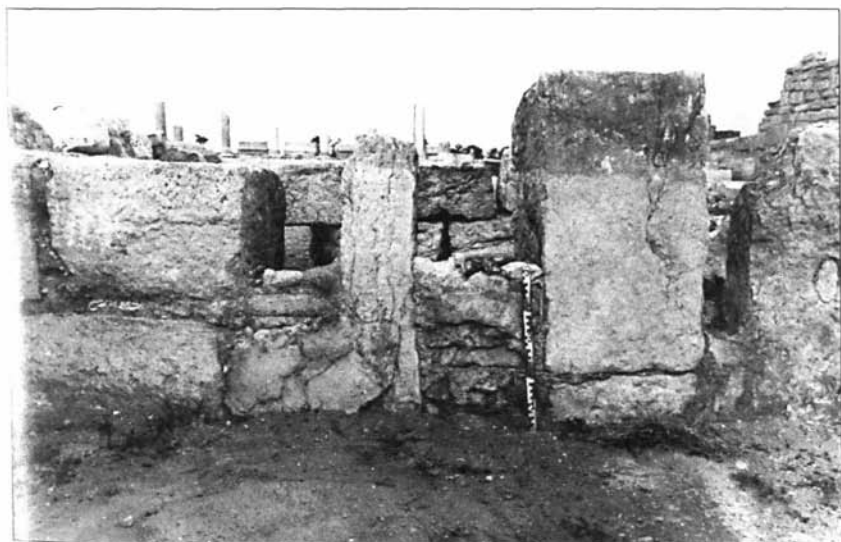
a - Le passage bouché entre les annexes sud et le bas-côté.
