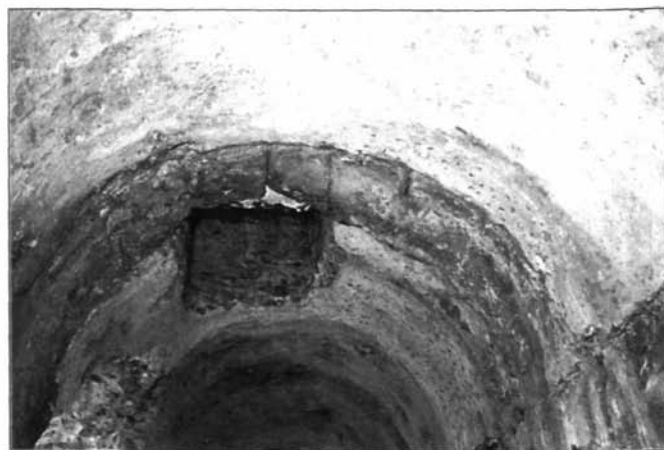
Forum Traiani : le Terme I da Ovest con spezzone di volta del porticato, in giacitura di crollo (1). Dettaglio di lucernario quadrangolare nella volta del porticato. In evidenza una nervatura trasversa a conci cuneati (2).
