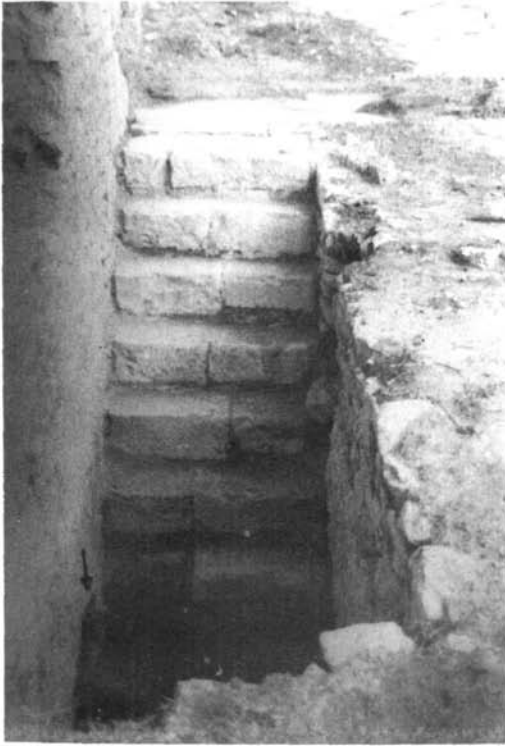
Escalier de la citerne n° 11 (vu de l'ouest).
