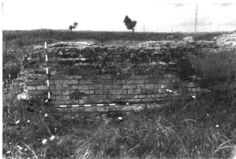
Italice. Thermes de la Nova Urbs. Zone centrale, détail de la construction d'un mur.
