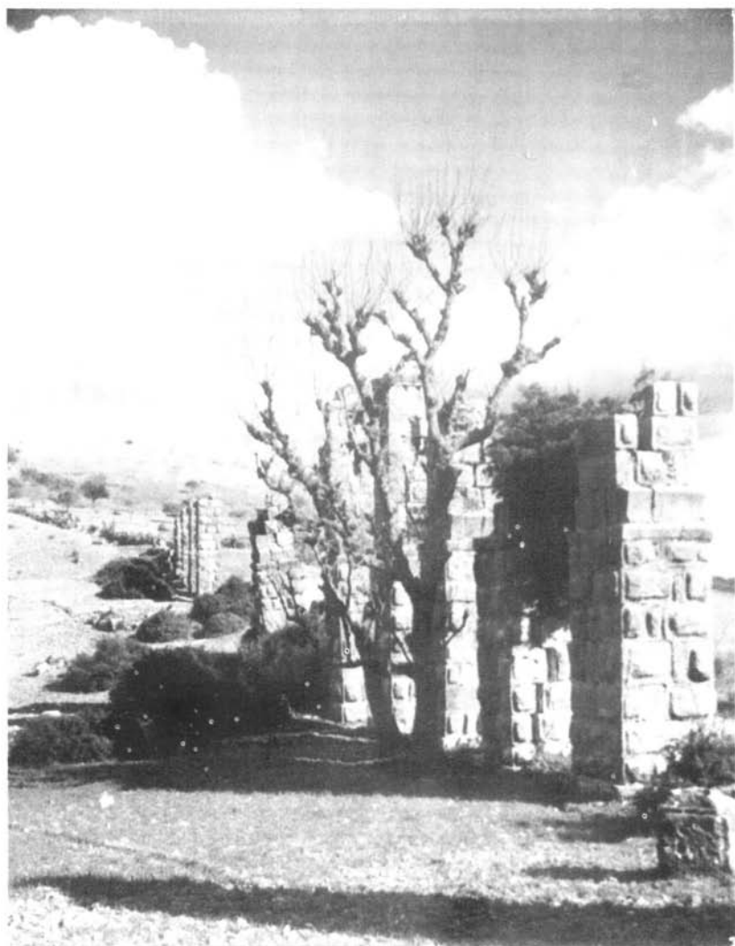
Le pont-aqueduc de Tiahmaïne. Photographie Jean Birebent, vers 1950.
