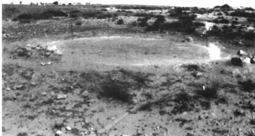
1 - Installation n° 3. Réservoir.
