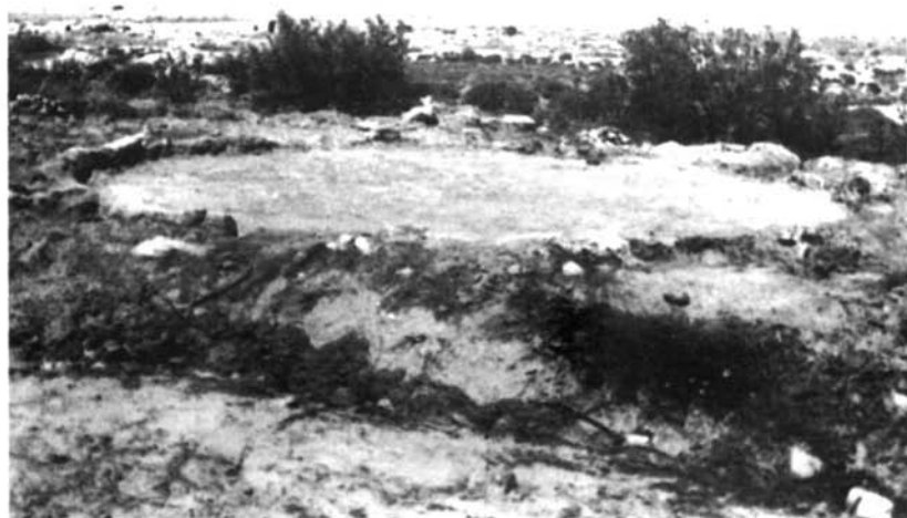
2 - Installation n° 2. Réservoir.
