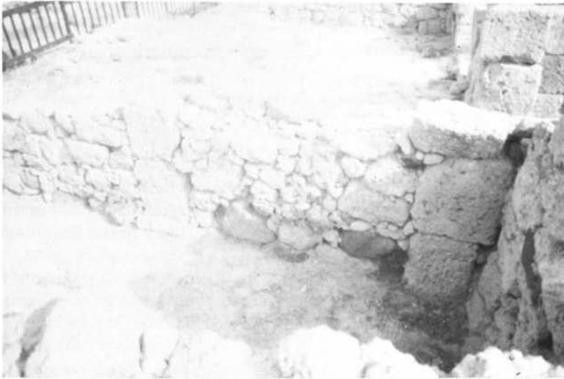
1. Muro a telaio di una abitazione del quartiere alle pendici della collina di San Giovanni a Tharros.
