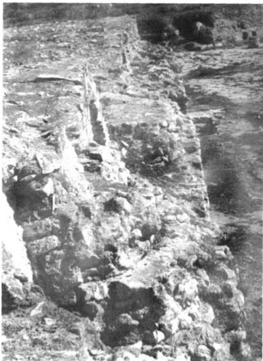
Mur laissé en saillie pour servir de piedroit nord à la voûte de la citerne n° 11 (vu de l'ouest).
