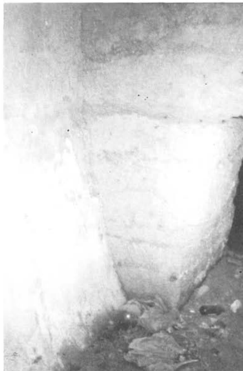
2 - Piscina Cardito, struttura Est: ambiente D (particolare dell'angolo Sud-Ovest).
