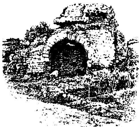
Fig. 3: Tipasa. Interno di una torre con arco di sostegno della scala per il camminamento di ronda (da GSELL, Monuments antiques de l'Algérie , Alger 1901, p. 97, fig. 32).
