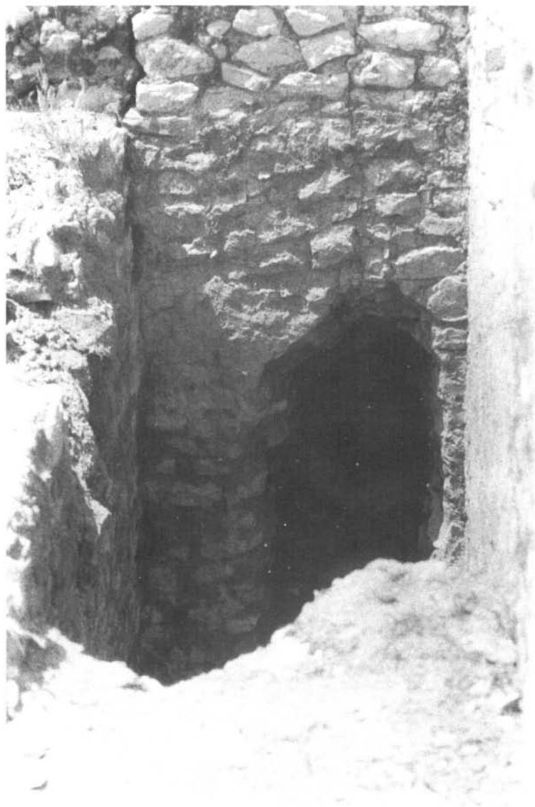
Trou de communication entre la citerne n° 3 et la citerne n° 11 (photo prise à partir de la citerne n° 3, vers l'ouest).
