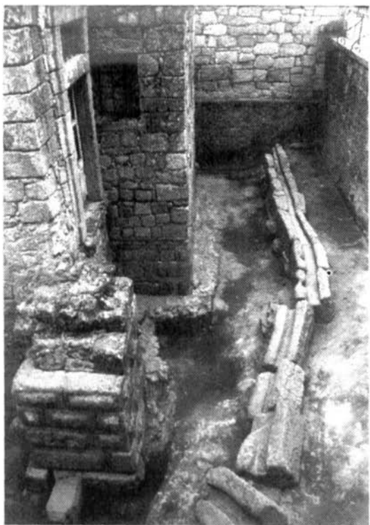
a - São Pedro do Sul: un contrefort extérieur, en grand appareil, avec des assises de pierres à bossage.
