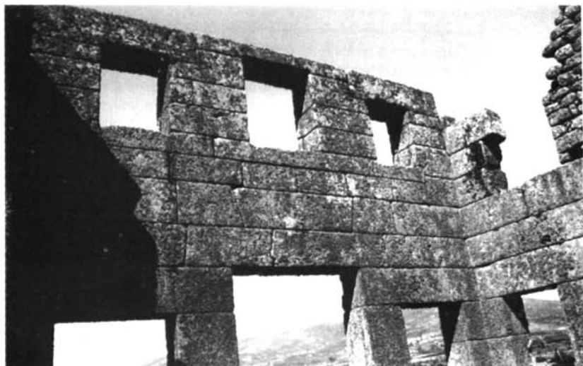
a - Torre de Centum Cellas: les assises de granit en parpaings et les pierres d'angles en crossette.
