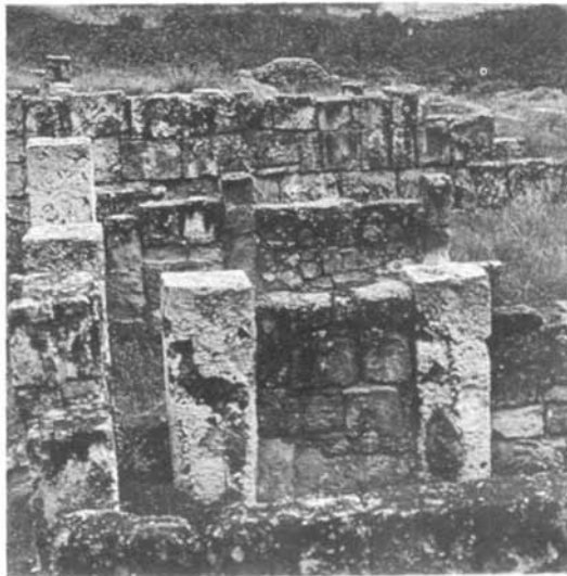
2. Esempio di muro a telaio dalla Casa degli Stucchi a Cagliari (da S. ANGIOLILLO, L'arte della Sardegna romana , Milano 1987).
