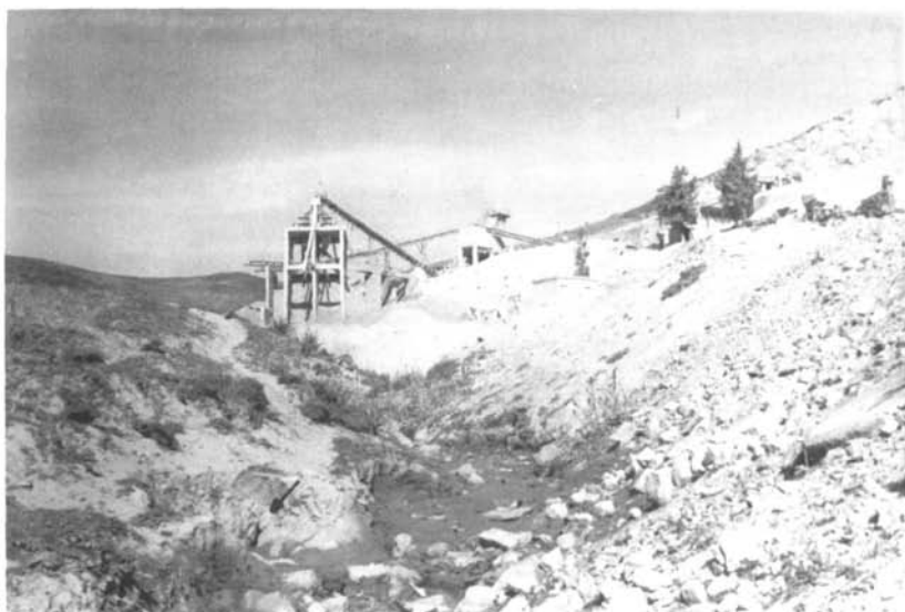
Aïn Ettolba - vue générale de la carrière et emplacement de la source (indiquée par la flèche).
