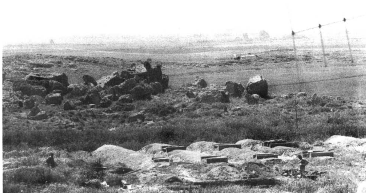
Les décombres des grands thermes sud vus à partir des citernes (vers le sud).
