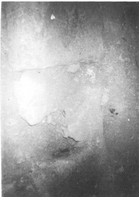
1 - Piscina Cardito, struttura Est: muro Sud del vascone I (particolare con la risarcitura).
