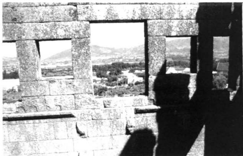
b - Torre de Centum Cellas: les ouvertures du premier étage et les trous des solives.
