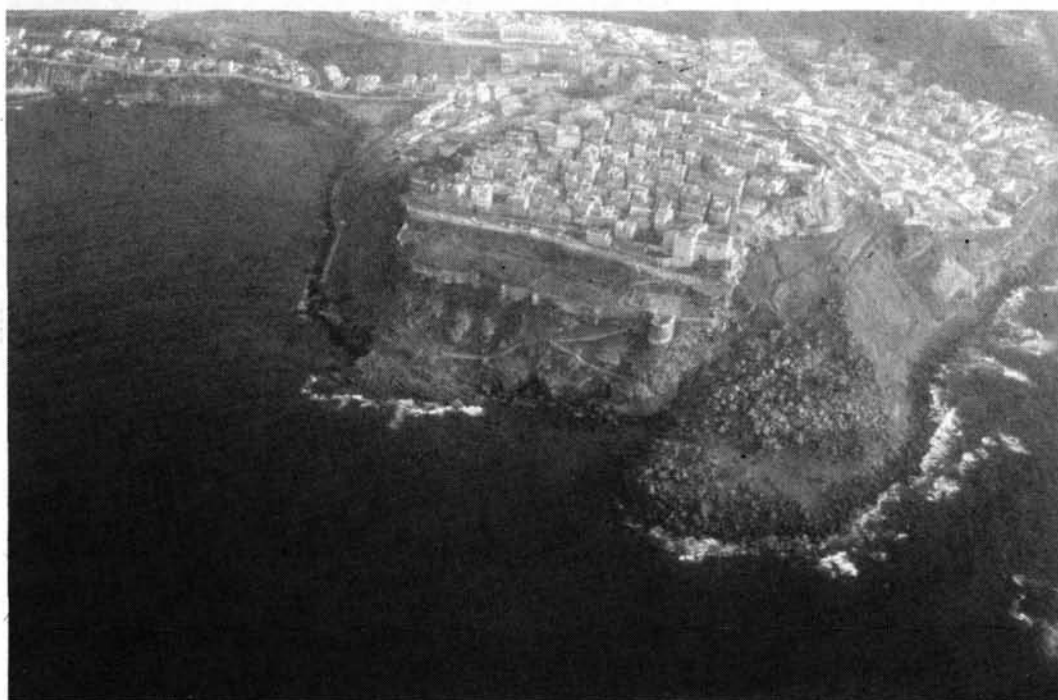
Foto 1 - Veduta aerea del promontorio di Castelsardo da cui appaiono evidenti i movimenti di frana che hanno interessato l'abitato.
