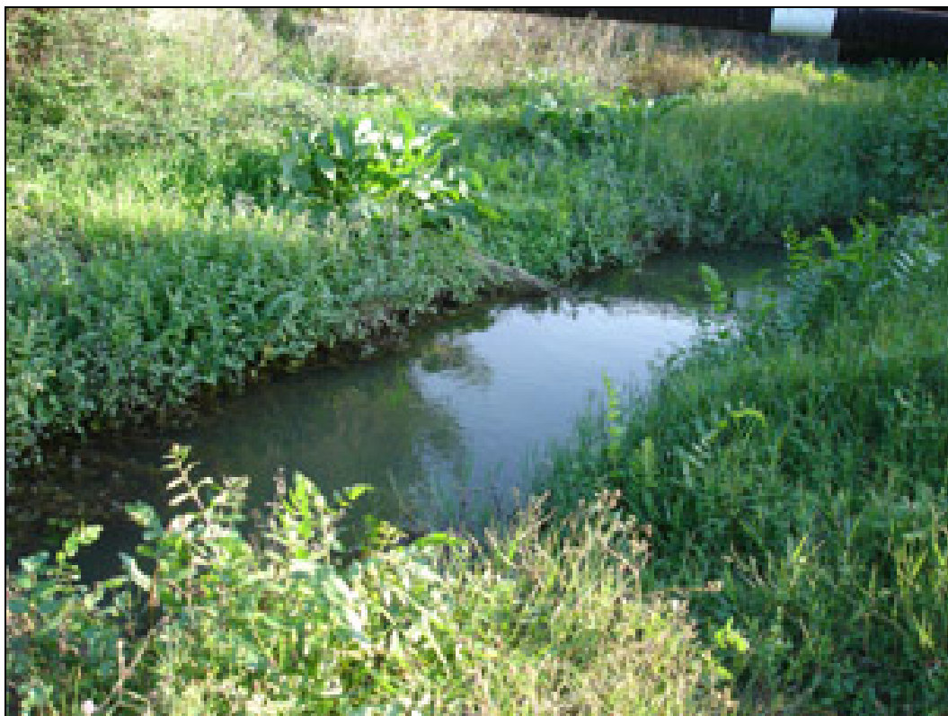
Figura 8.9 - Dimensioni (in metri) della sezione Aeroporto e immagine dell'alveo con le golene ricoperte da vegetazione
