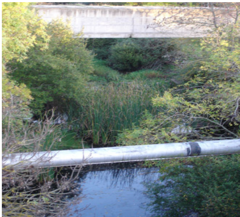
Figura 8.11 - Dimensioni (in metri) della sezione Cuga e immagine dell'alveo sotto il ponte-tubo
