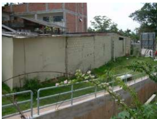
Erfolgte zur Kanalisation unter Schaffung neuer Freizeitflächen (Quelle: SeHab São Paulo)
