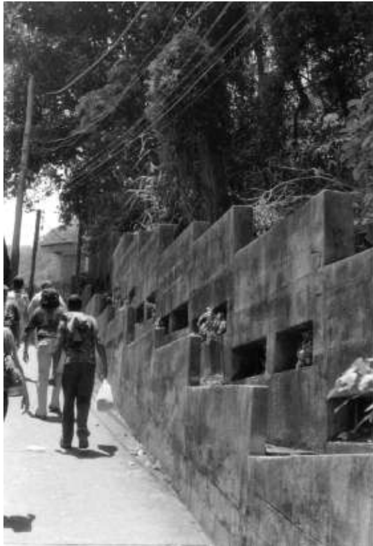
Nach Abriss einiger Häuser und Wiederaufforstung erfolgte Einfriedung des bebaubaren Gebiets zum Wald hin (Foto der Verfasserin)
