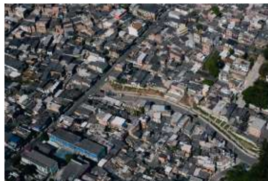
Erfolgte Kanalisation (Quelle: SeHab São Paulo)
