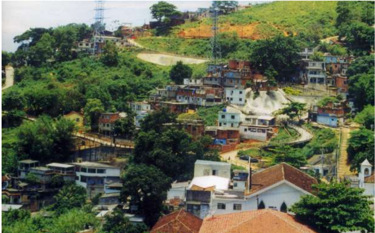
Blick auf den oberen Teil der Siedlung. Zu erkennen: neue Straßen für die motorisierte Erschließung, Befestigung Erdrutsch gefährdeter Hänge (Quelle: CONDE / MAGALHÃES, 2004 : 131)
