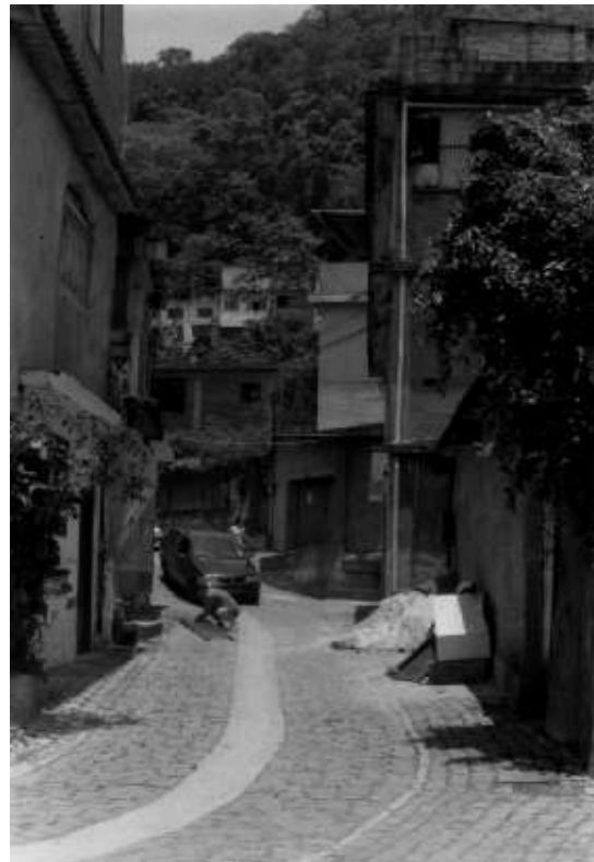
Nach Durchführung der Favela Bairro Sanierungsmaßnahmen von den Bewohnerverbänden initiiertes Projekt der Straßenpflasterung. Man beachte die Abwesenheit von Häusern im Rohbau oder mit unverputzten Fassaden. (Foto der Verfasserin)
