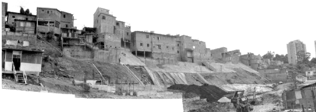
Grotinho Risikogebiet während der Bauarbeiten nach Abriss der gefährdeten Häuser (Foto der Verfasserin)
