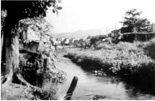
Unbefestigter Kanal vor den Arbeiten (Quelle: Jorge Mário Jáuregui)
