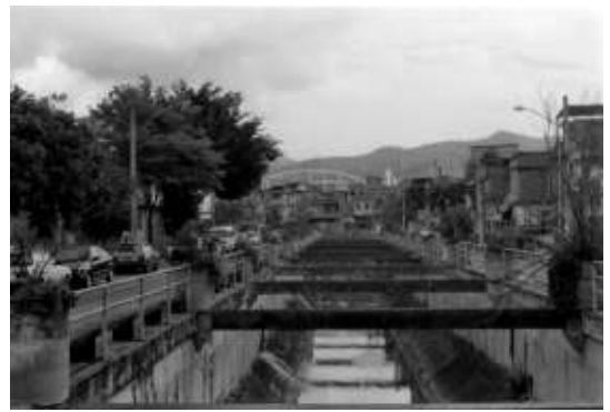
Zentrale Erschließungsachse mit befestigtem Kanal, heutiger Zustand, Begrünung und Außenanlagen leiden zum Teil an mangelnder Instandhaltung (Foto der Verfasserin, 2007)
