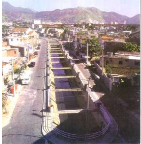
Zentrale Erschließungsachse mit befestigtem Kanal (Quelle: Jorge Mário Jáuregui)
