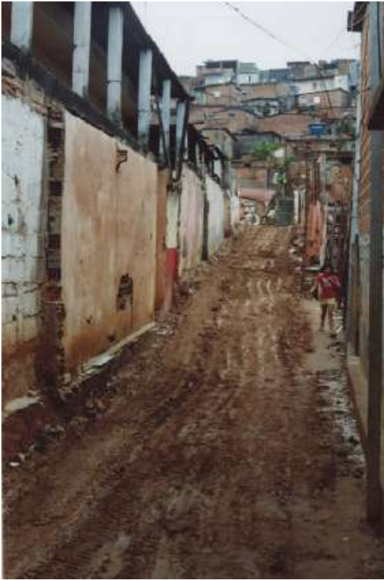
Schaffung eines befahrbaren Zugangs zum Risikogebiet Grotão durch Abriss von Häusern auf breite eines Baggers (Foto der Verfasserin)
