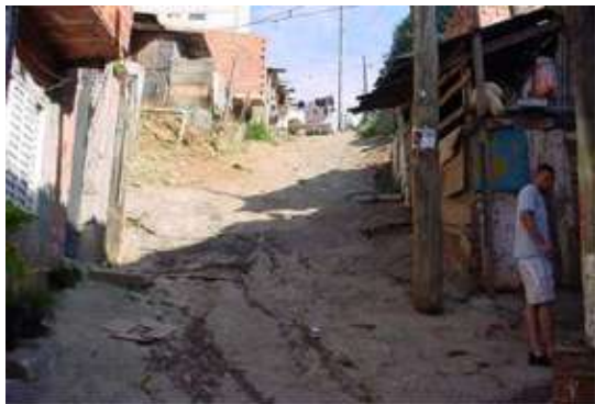
Zugangs zum Gebiet vor den Sanierungsmaßnahmen (Quelle: SeHab São Paulo)
