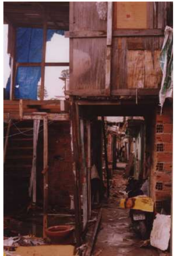
Abriss von Häusern in einem infolge vollkommenen Fehlens von Belichtung und Belüftung als stark inadäquat geltenden Gebiets der Favela. Die Erschließungsgasse war komplett mit Häusern überbaut und diente u.a. den Drogenkartellen als Versteck. Zu den mit den vom Abriss betroffenen Bewohner vereinbarten Terminen für den Umzug kommt sowohl eine Firma für den Transport als auch ein sofortiges Abrisskommando, um die Wohnung als Domizil unbrauchbar zu machen und so Neubesetzungen zu vermeiden. Auf dem Foto sind bereits sehr viele Häuser des ehemaligen Tunnels abgerissen wurden. (Foto der Verfasserin)
