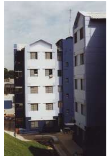
Sanierung der Sozialwohnungen früherer Generation (Cingapura) (Foto der Verfasserin)
