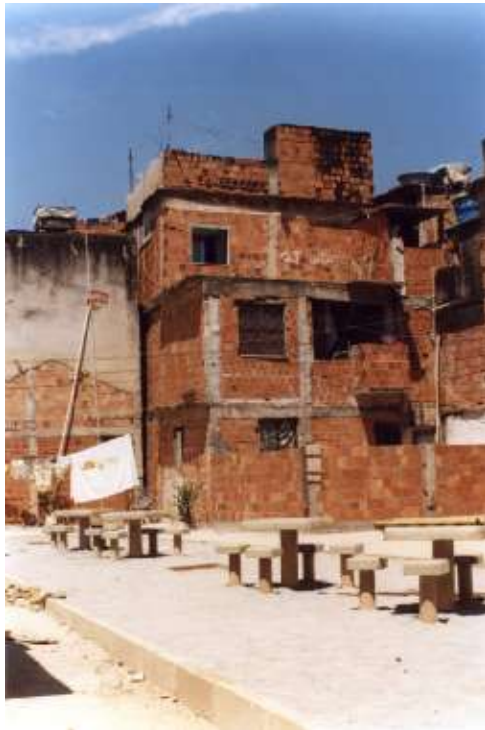
Nach erfolgtem Abriss Außenraumgestaltung im Siedlungsgebiet mit standardisierten Stadtmöbeln
