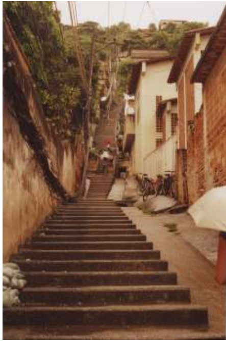
Befestigung der fußläufigen Erschließung des Gebiets (Foto der Verfasserin)
