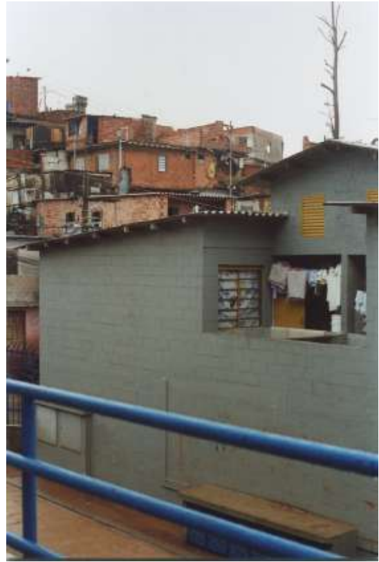
Übergangswohneinheiten für von Abriss Betroffenen (Foto der Verfasserin)
