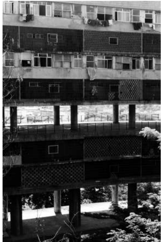
Das an den Ideen Le Corbusiers orientierte Pedregulho Gebäude des Architekten Afonso Reidy in Rio de Janeiro gilt heute als condominho favelado (Foto der Verfasserin)
