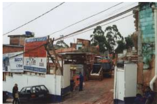
Baustelle für neuen Wohnungsbau, zu erkennen sind einige Hütten auf der Baustelle, deren Besitzer sich weigerten, ihre Häuser zu verlassen (Foto der Verfasserin)
