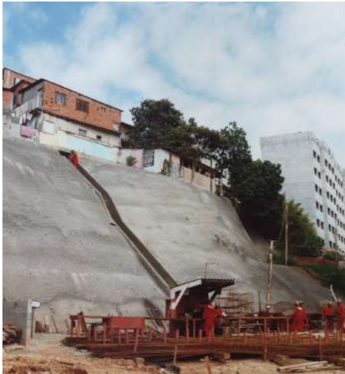
Sicherung von Steilhängen und Errichtung neuen Wohnungsbaus (Foto der Verfasserin)
