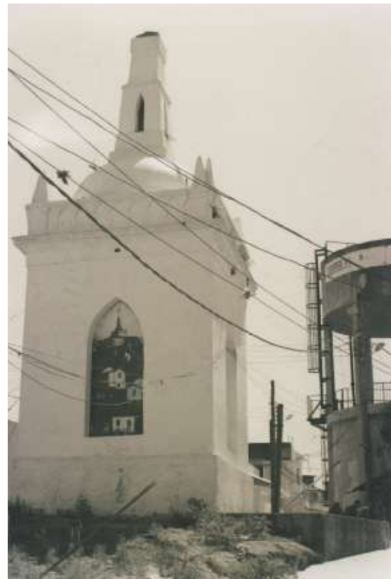
Die renovierte Cruzeiro Kapelle und der neue Wassertank, beides Teil des Freilichtmuseums
