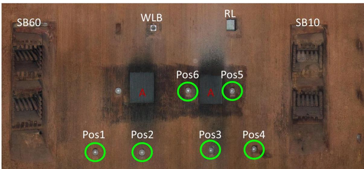
Abbildung 5-20: verwendete Einbaupositionen (Pos.1 bis Pos.6) für die LPR-Korrosionssonden im Dampferzeuger D1, Jänschwalde. Erläuterungen: SB10 und SB60 Vorderwandstaubbrenner; WLB: Wasserlanzenbläser; RL: Revisionsluke; (A) abgestrahlte Testfelder mit Schutz-Cladding; Die gegenüberliegende Rückwand ist gleichartig aufgebaut.
