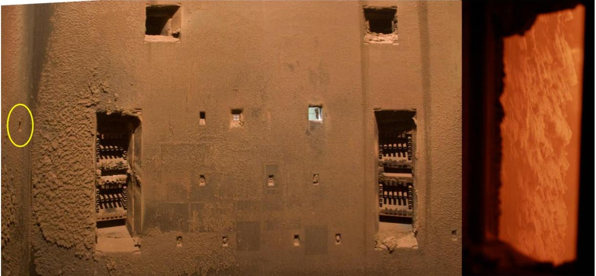
Abbildung 5-27: Verteilung von Asche auf der Rückwand des Dampferzeugers D1 nach dem Abschalten für die Revision im Sommer 2011. Rechts: Ascheanlagerungen der Rückwand in Höhe der Staub-brenneroberkante durch eine Luke (gelber Kreis, links) der linken Seitenwand fotografiert.
