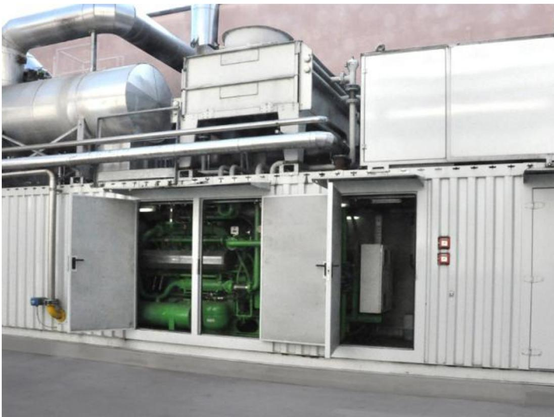
Figura 17 - Gruppo di cogenerazione a biogas.
