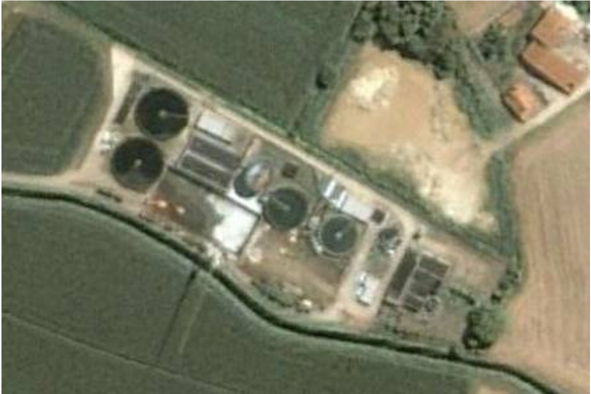
Figura 4-2: Foto satellitare dell'impianto
