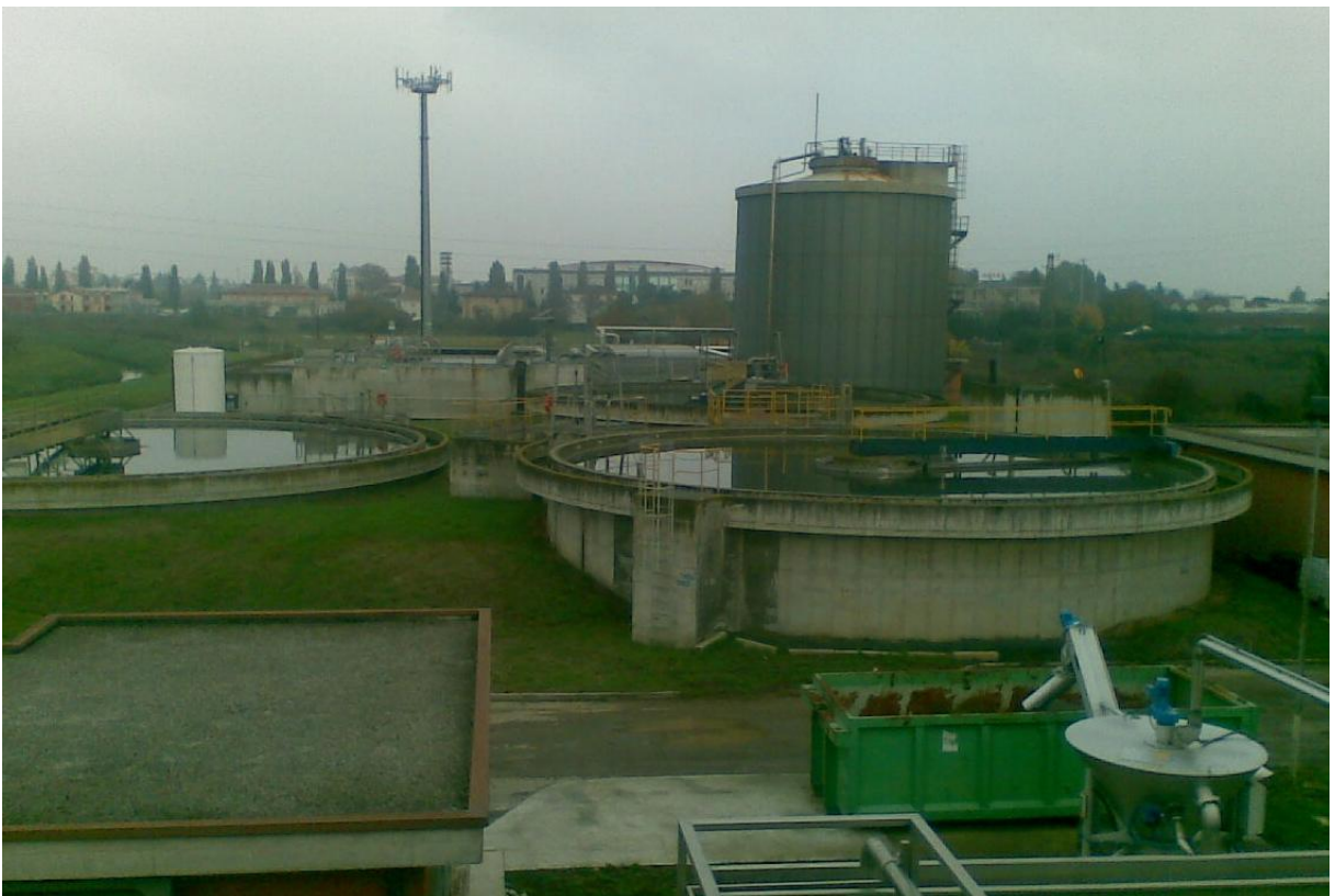
Figura 4-6: Vista del sistema di sedimentazione
