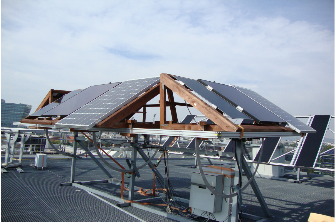
Abbildung 2.1: Der Messaufbau: Der Modulständer am Dach des Gebäudes “Techbase Vienna”. [a]
