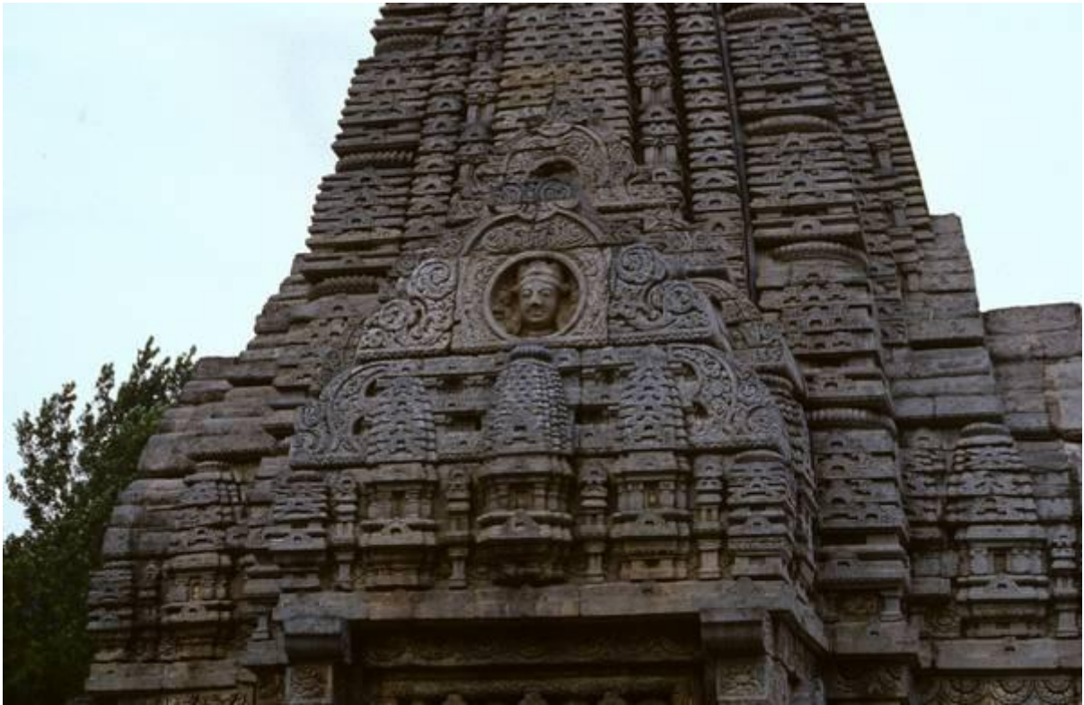
Abb. 12: Bajaura, Gesims über der östlichen Nische, mit Mahādeva im Medaillon.
