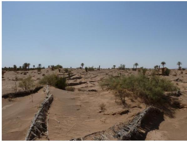
Abbildung 12: Mit Barrieren wird das Fortschreiten des Sandes verlangsamt (Foto: Martin Dvoran)
