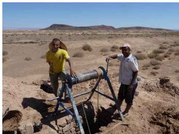
Abbildung 14: Instandhaltungsarbeiten eines Schachtes (Foto: Martin Dvoran)
