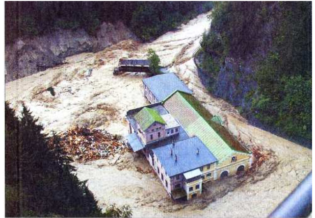
Das Kraftwerk der Donau-Chemie wurde meterhoch überschwemmt.
