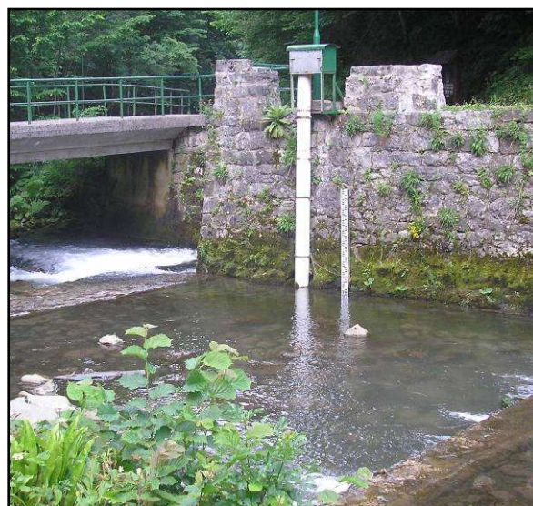
Foto 17: Pegelstation am Zusammenfluss von Klammbach und Zeleni Vir Bach
