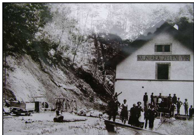
Foto 3: Bauarbeiten am Kraftwerk „Zeleni Vir“, 1919
