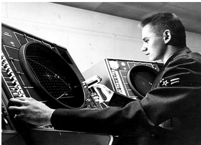
Abb.2: SAGE - interaktive Bildschirmeingabe mit der Lightgun
