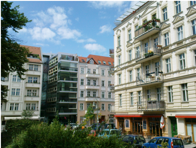
Abbildung 8–5: Neubau und sanierte Häuser
