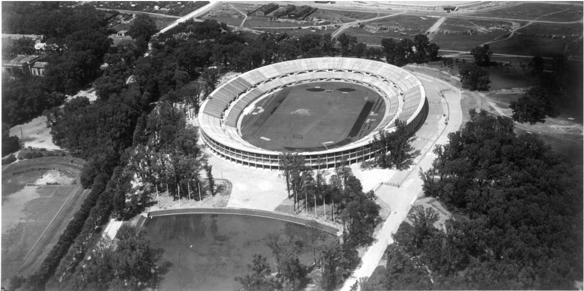
Abbildung 12: Wien 2, Praterstadion: Flugbild von SSW. Ohne Zuschauer im Oval. Im Vordergrund ist der Spiegelteich zu sehen, der im Zuge des Ausbaus einem Parkplatz weichen musste. Links daneben befindet sich der Cricketer-Platz. (Bild: Österreichische Nationalbibliothek, Bildarchiv, AF 3691 C)
