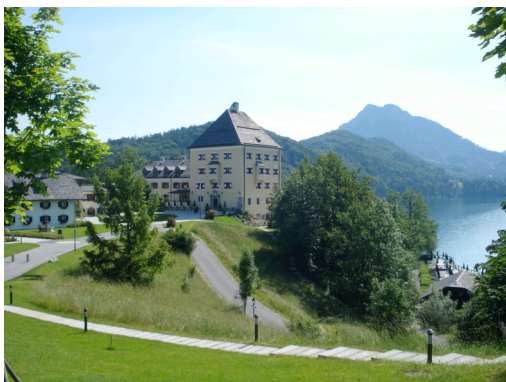
Abb. 51: Schloss Fuschl am Fuschlsee, Schloss Straße 19, Hof bei Salzburg, Zustand im Juni 2010, Ansicht aus südwestlicher Richtung gen Nordost.
