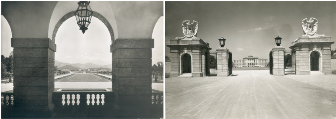
Abb. 43: Schloss Kleßheim, Kleßheimer Straße, Wals-Siezenheim, Salzburg, um 1942, Ansicht Gartenanlage gen Südosten.
