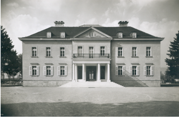
Abb. 39: Kavaliershaus, Kleßheimer Straße, Wals-Siezenheim, Salzburg, um 1942, Ansicht der Fassade im Nordosten.
