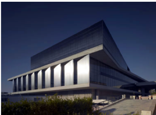
Abbildung 10: Ostansicht des Neuen Akropolis Museums 66
