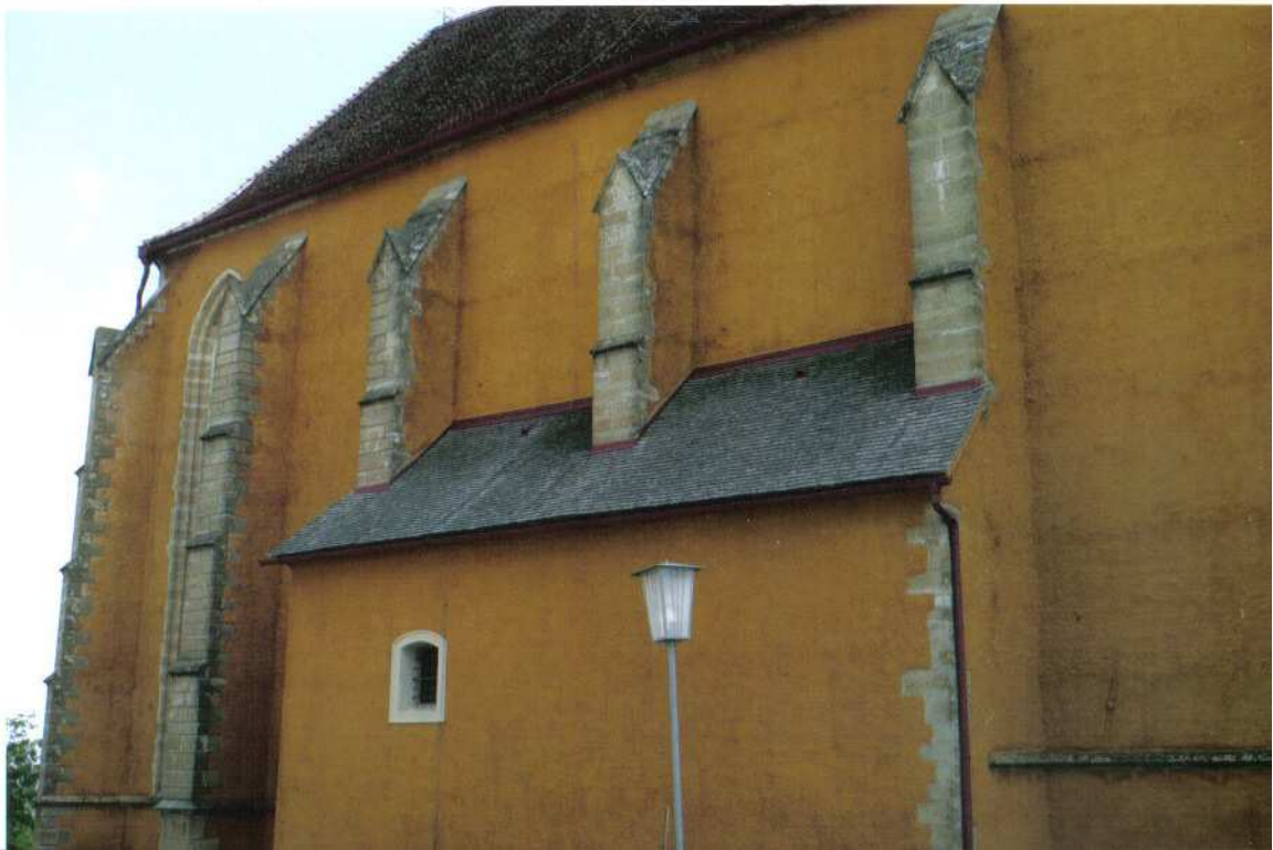
Bild 12: Nordfassade mit angebauten Altarnischen
