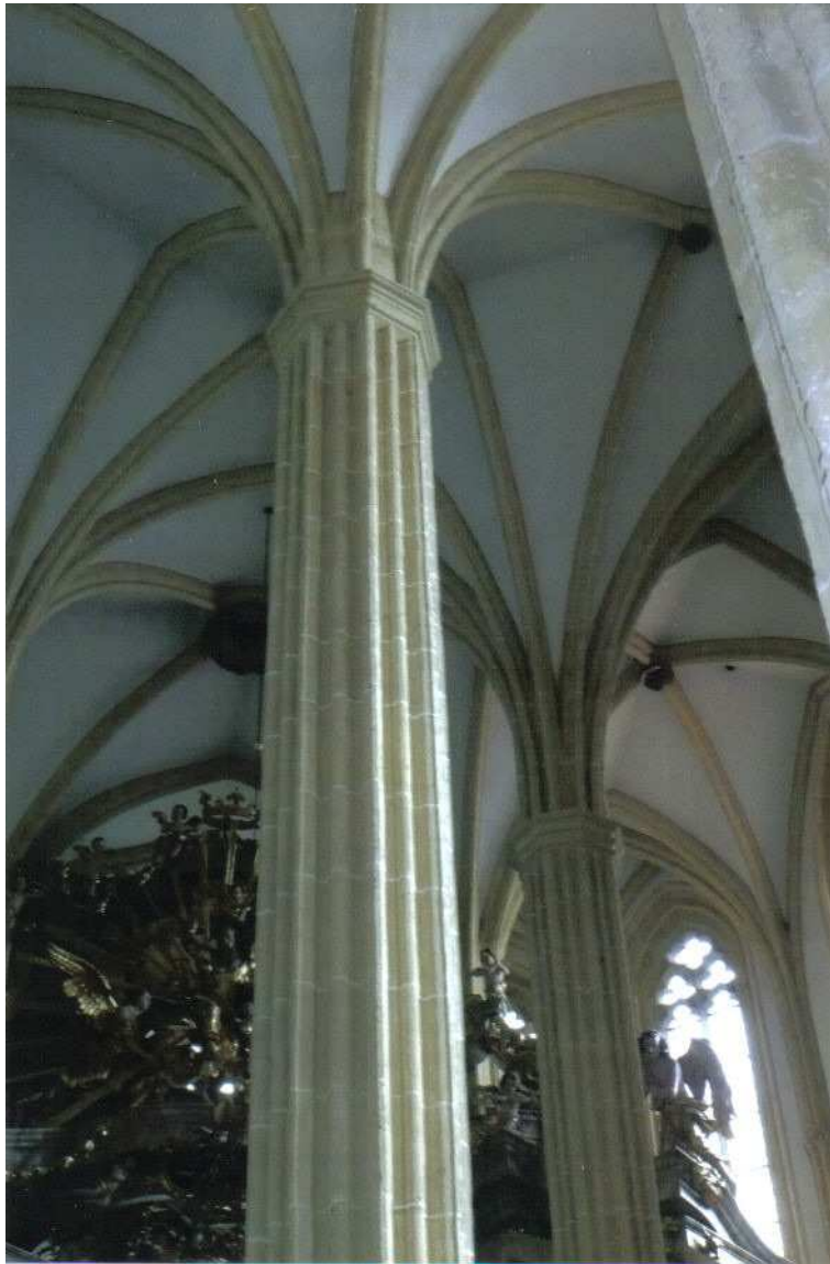
Bild 27: Kircheninneres – Blick in das Gewölbe
