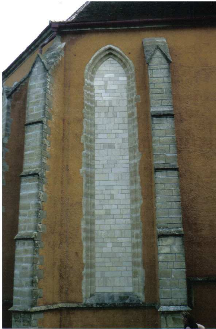
Bild 13: vermauertes Fenster im nördlichen Chorpolygon
