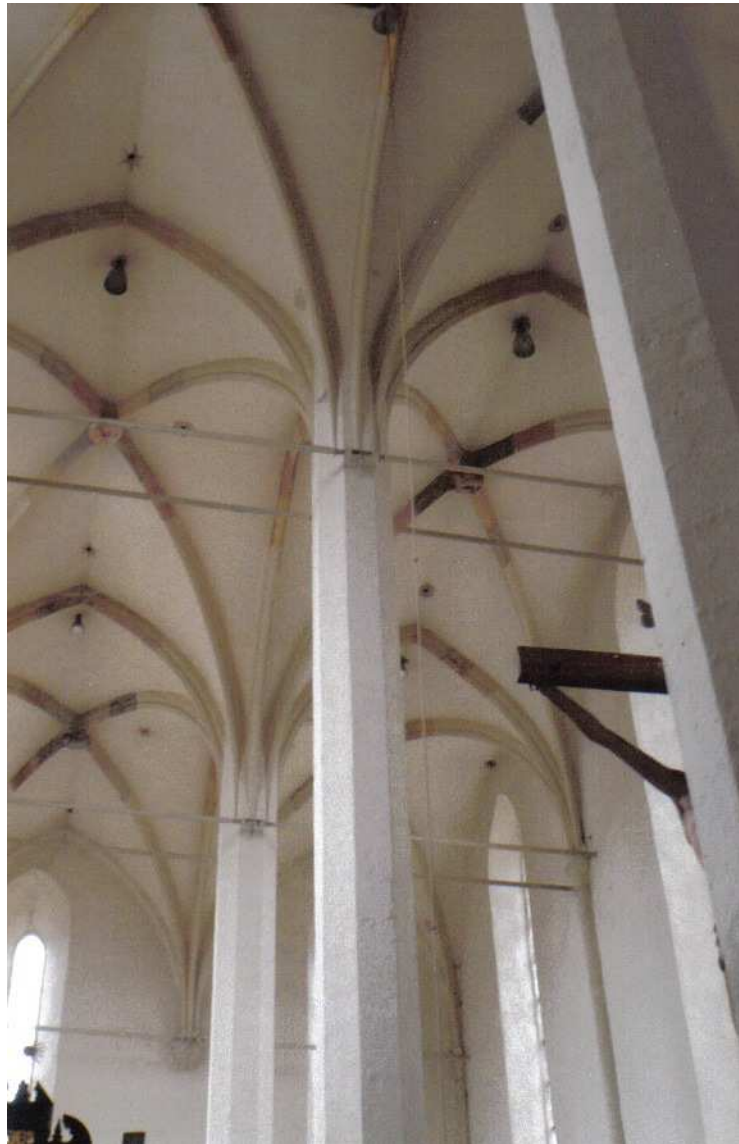
Bild 48: Kircheninneres – Blick in das Gewölbe des Langhauses
