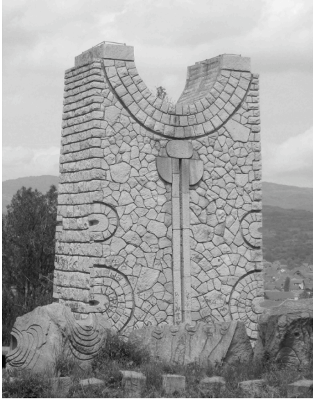
Abb. 69 Pylon in Vlasotince, aktueller Zustand
