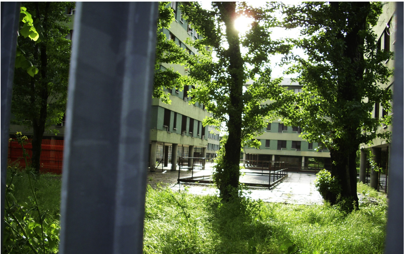
Derselbe Innenhof zwei Jahre nach der Schließung des letzten Wohnblockes Mai 2009
