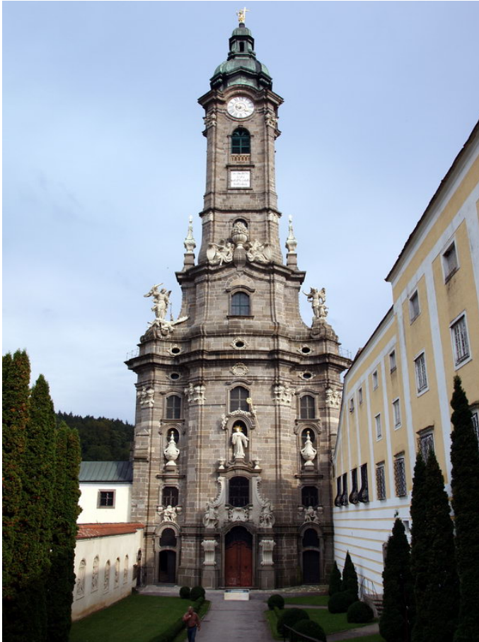
Abb. 111: Zwettl, Stiftskirche: Turmfassade.
