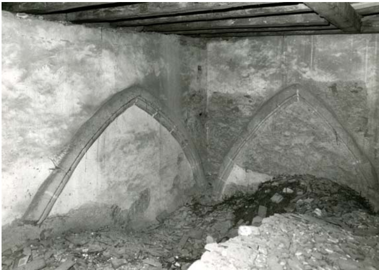
Abb. 33: Altenburg, Klosterkirche: Langhaus, Schildbögen der Wölbung im ersten Joch des ehemaligen südlichen Seitenschiffs (Langhaus, SW-Ecke).
