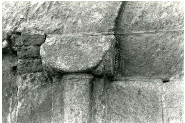
Abb. 28: Burgschleinitz, Pfarrkirche: Langhaus, Südportal mit lisenenhinterlegten Halbsäulen als Portalrahmung.
