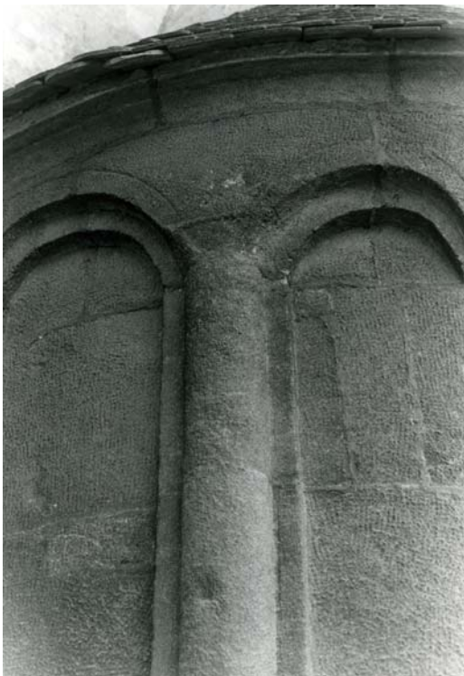
Abb. 27: Kühnring, Pfarrkirche: Gliederung der Apsis mit lisenenhinterlegten Halbsäulen und getrepptem Rundbogenfries.
