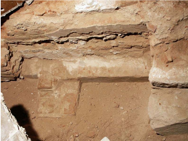
Abb. 73a: Altenburg, Stiftskirche: Barocke Fundamente.
