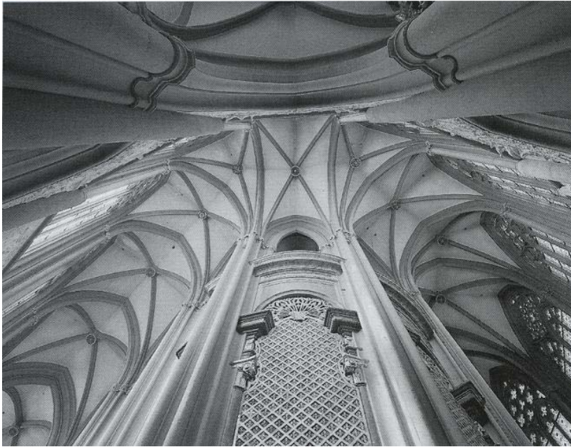
Abb. 106: Zwettl, Stiftskirche: Blick in die Gewölbe des Chorumgangs.
