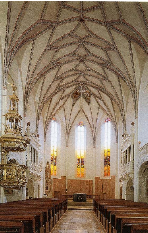
Abb. 100: Pernegg, ehemalige Stiftskirche: Innenraum mit Netzrippengewölbe.
