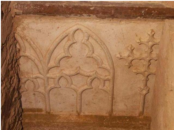
c: Detail, Maßwerk
