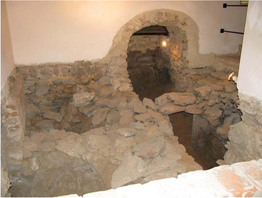
Abb. 86: Altenburg, Drei-Stützen-Raum: Heizanlage, Zustand 2009.
