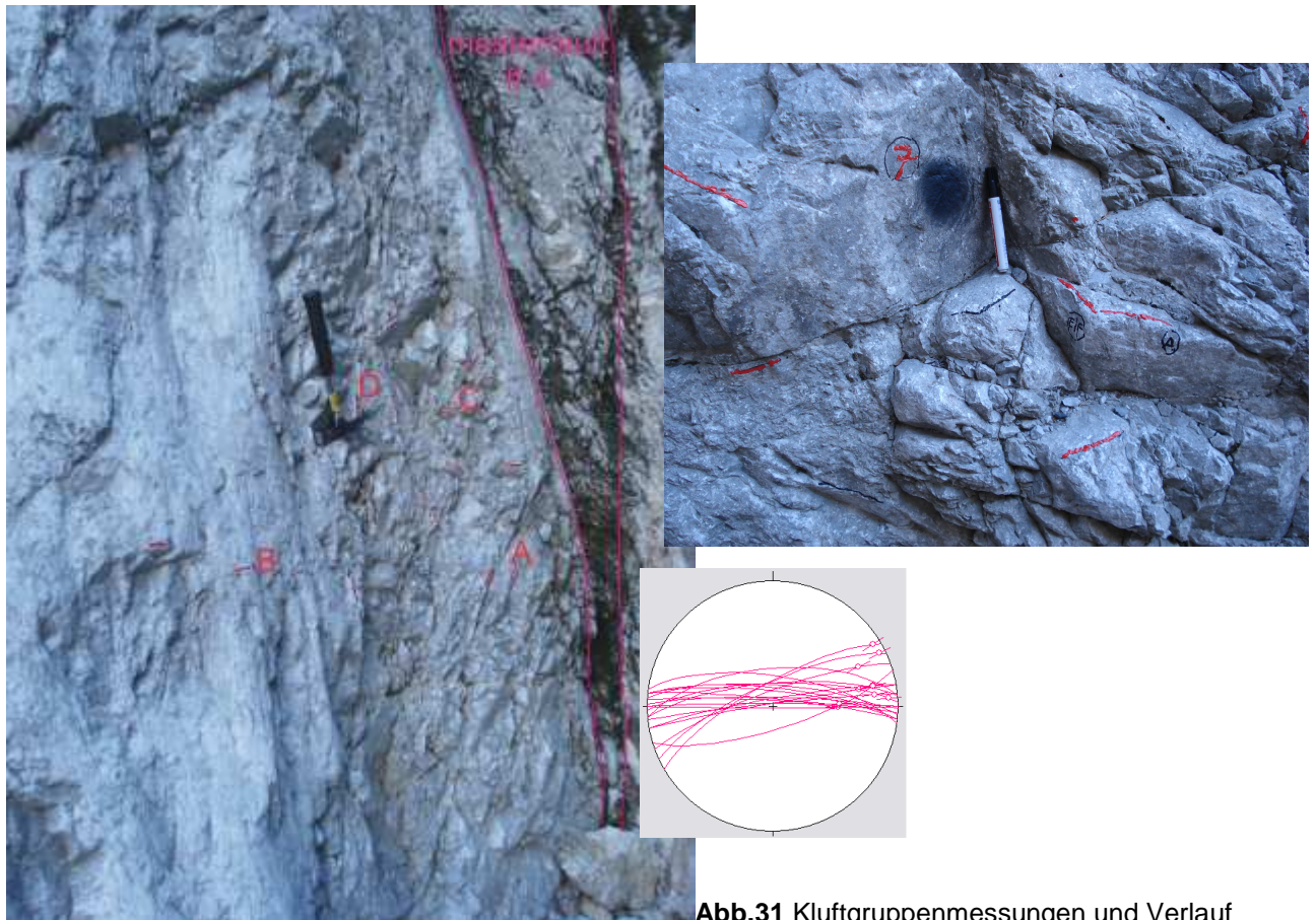
Abb.31 Kluffgruppenmessungen und Verlauf der Hauptstörung (Harnischflächen in Angelierplot ), (Blickrichtung W)
