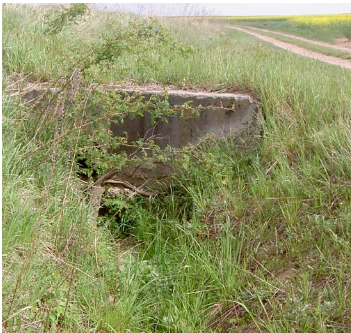
Abbildung 9: Detailansicht des Durchlasses im Entwässerungsgraben
