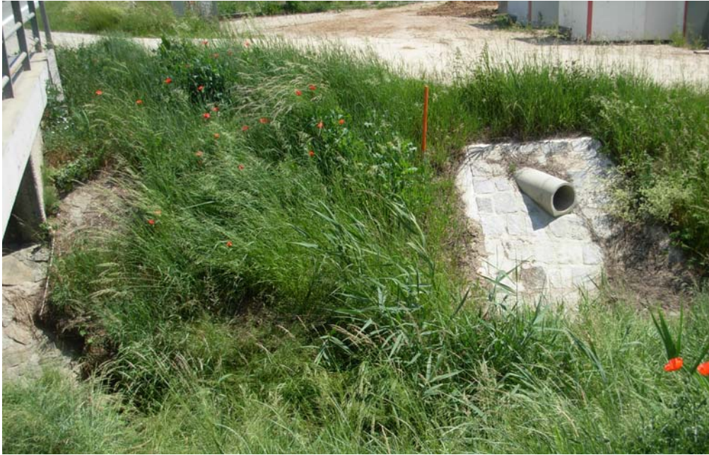
Abbildung 25: Testgebiet Weidenbach-Klein-Harras - Teileinzugsgebiet entwässert ungeschützt durch Kanal-Auslass in Vorfluter
