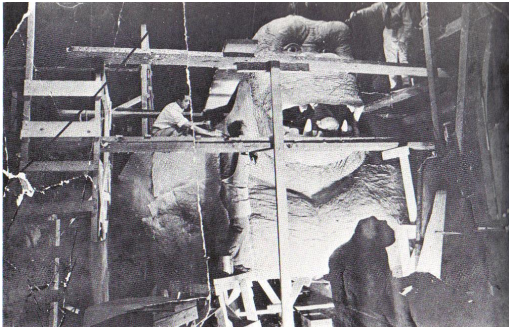
Abbildung 51: Riesenkong während den Bauarbeiten; Quelle: Morton 2005
