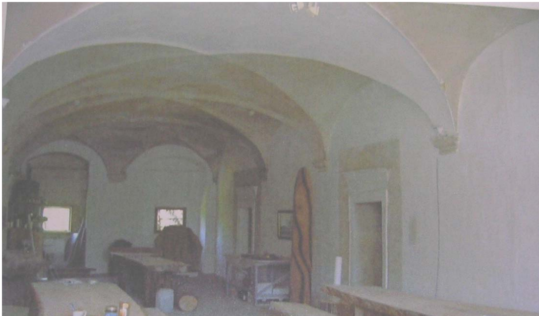
Abb. 82: Gewölbe im Obergeschoss des Schlosses Wolfpassing.
