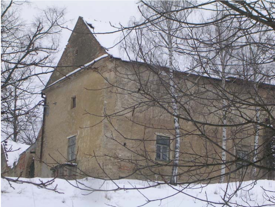
Abb. 105: Fenster an der Südseite des Schlosses Oberrußbach.
