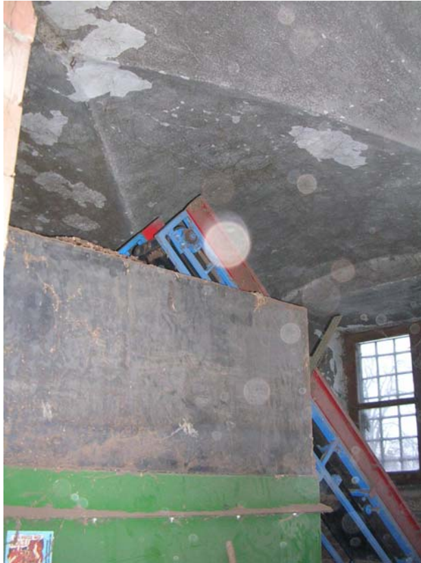
Abb. 33: Gewölbe des Schlosses Schmida.
