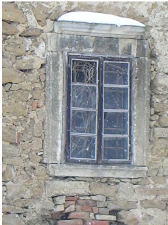
Abb. 106: Fenster an der Ostseite des Schlosses Oberrußbach.
