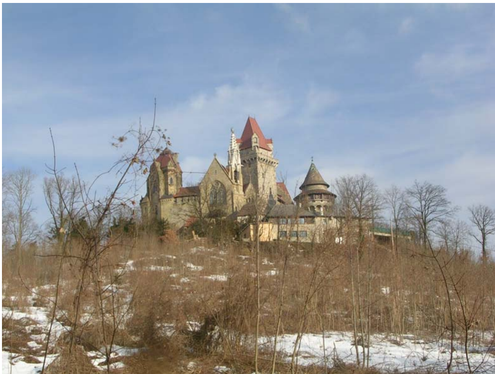
Abb. 139: Die Gesamtansicht der Burg Kreuzenstein.
