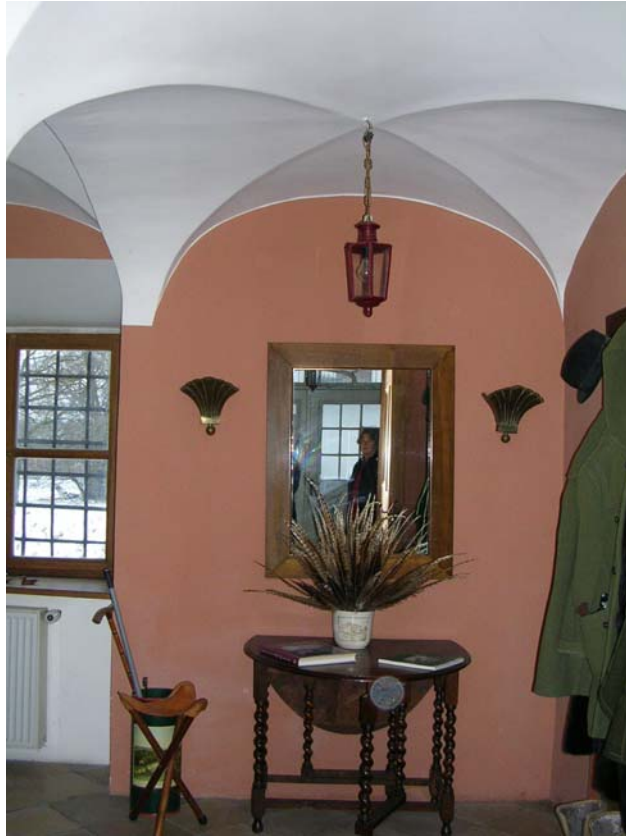
Abb. 31: Gewölbeformen des 16. Jahrhunderts im Schloss Schmida.
