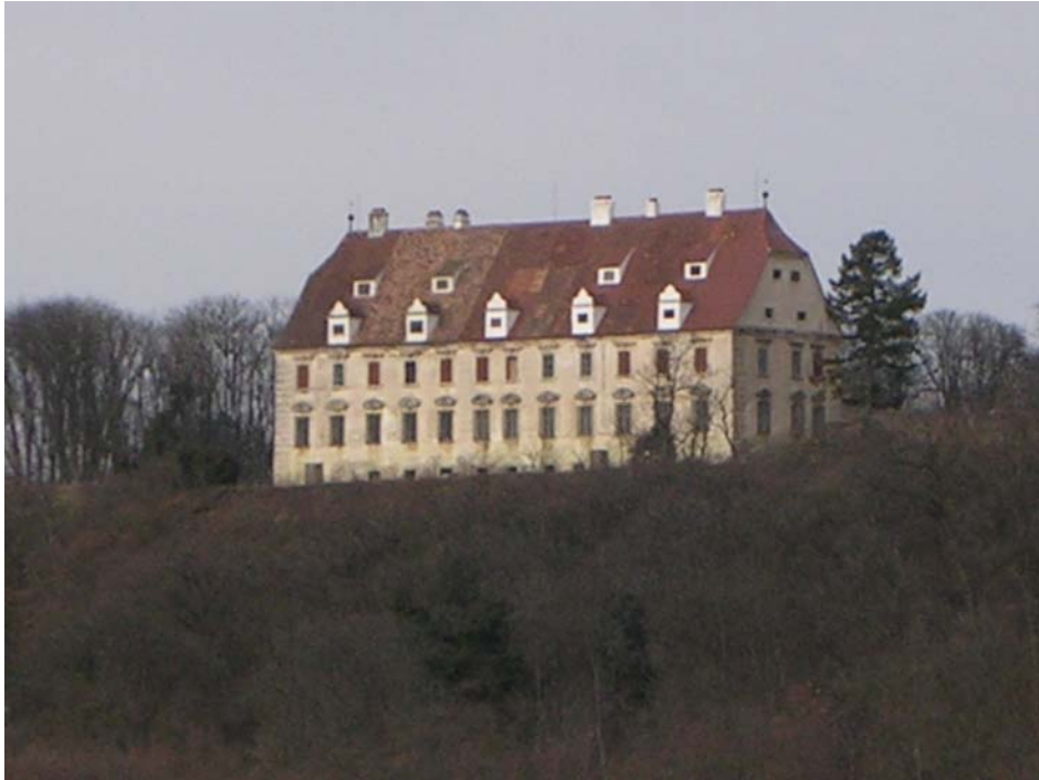
Abb. 113: Außenbau des Schlosses Stetteldorf.
