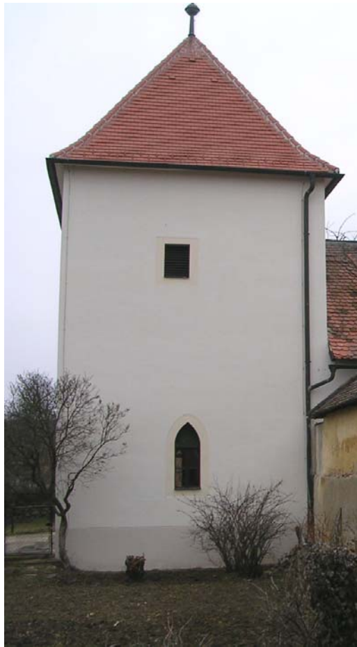
Abb. 49: Die Kapelle des Schlosses Missingdorf.
