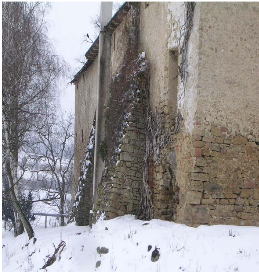
Abb. 100: Mittelalterliches Mauerwerk des Schlosses Oberrußbach.
