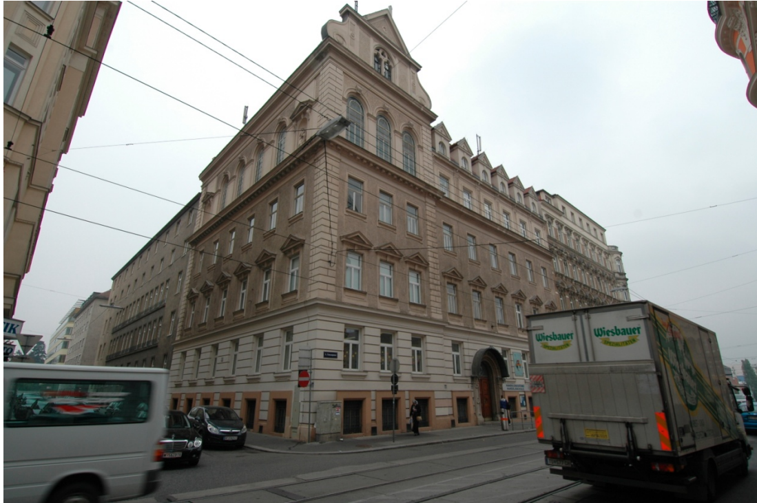
Abbildung 5: Gebäudequartier, nicht baufällig. Weder die Fassade, noch der Innenhof dieses Gebäudes wiesen größere Schäden auf. Fasangasse 4, 1030 Wien. Foto: Prof. Alexander Bruckner
