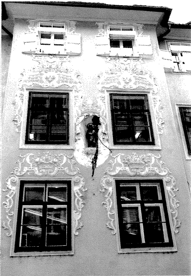
Abb. 198: Graz, Haus Kapaunplatz 2, Fassade, um 1740.
