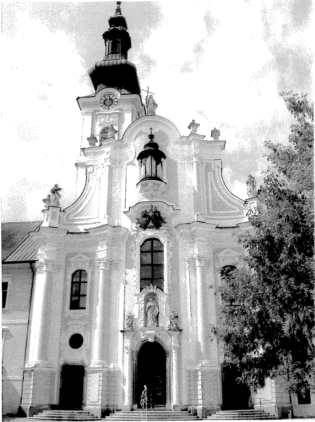
Abb. 54: Rein, Zisterzienser-Stiftskirche Mariae Himmelfahrt, 1738 – 1747, Fassade.
