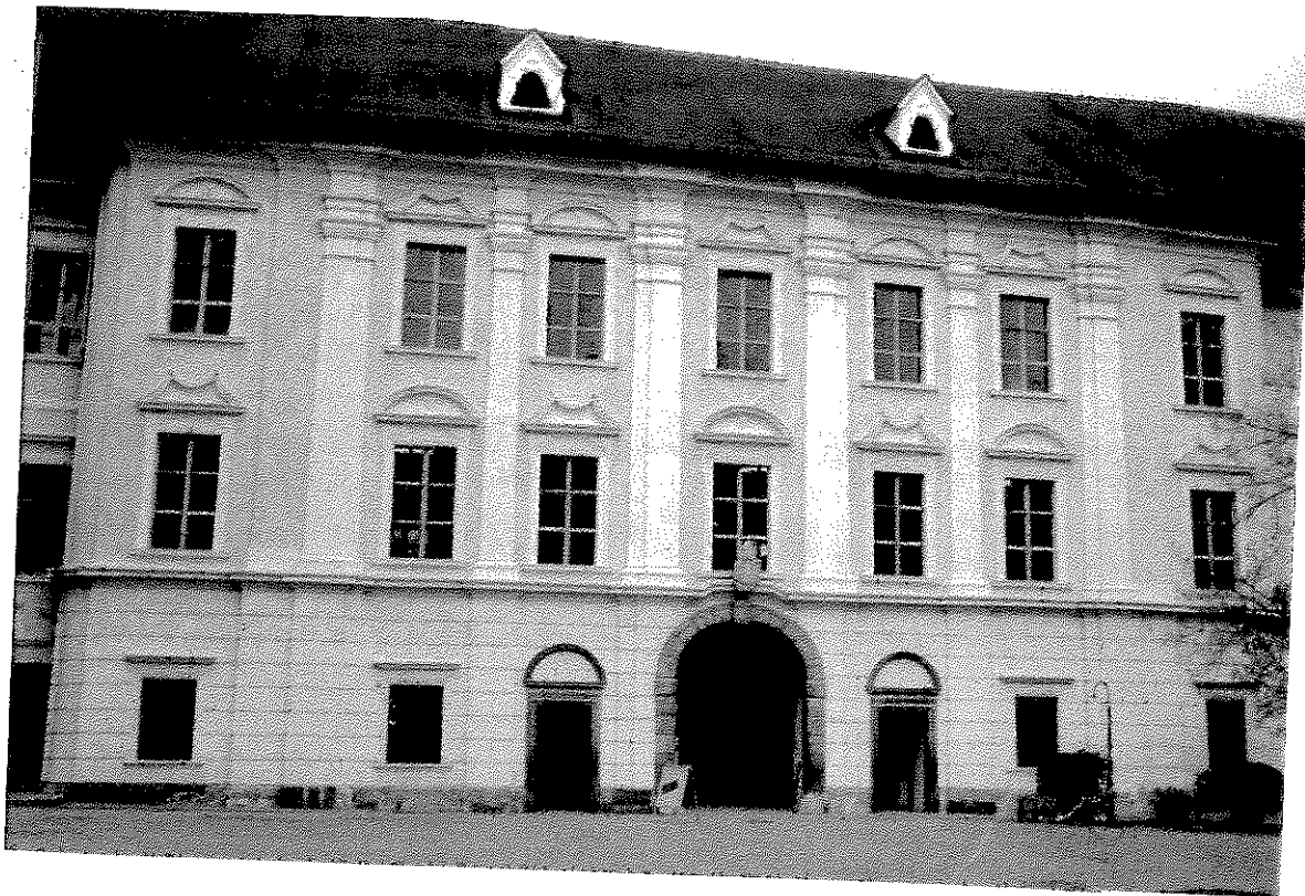
Abb. 114: Rein, Zisterzienserstift, Prälatenhof, Nördlicher Trakt, Risalit, ab 1720.
