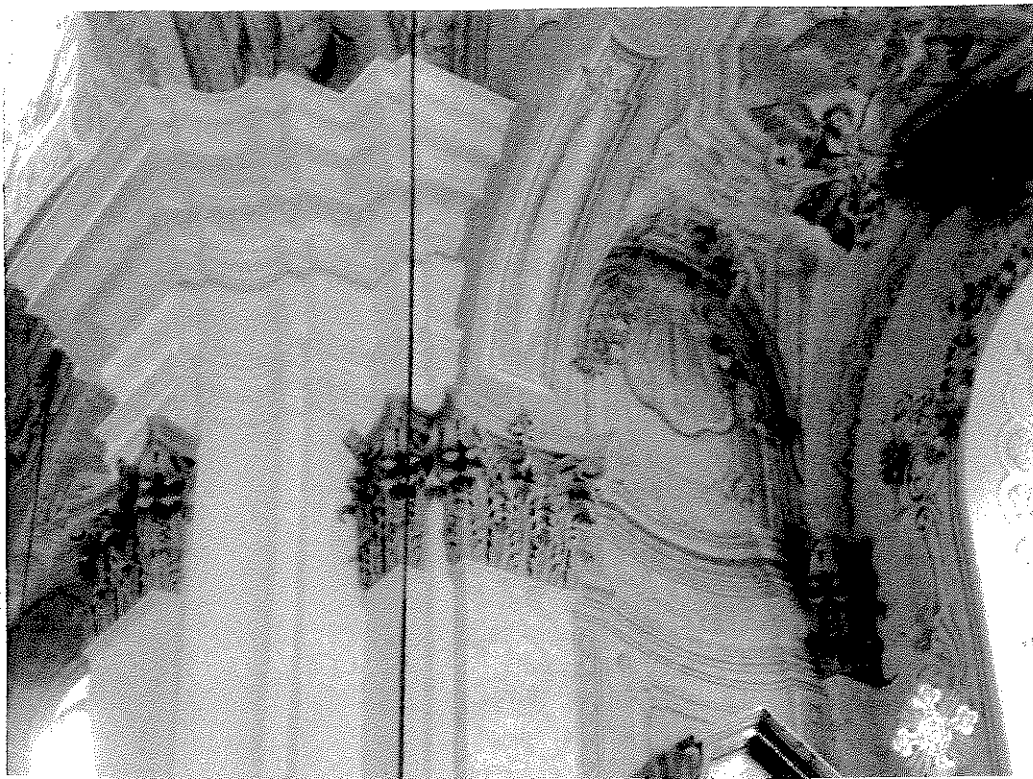
Abb. 106: Graz, Pfarr- und Wallfahrtskirche Mariatrost, 1714 – 1746?, Innenansicht, Gebälkverkröpfung am Übergang von Vierung zu Langhaus.
