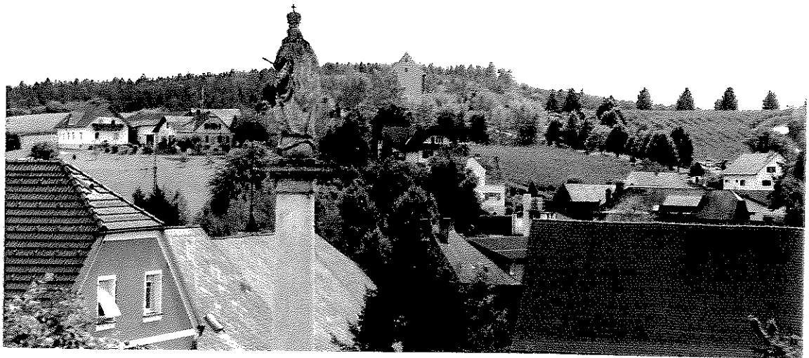
Abb. 80: Pischelsdorf, Filialkirche hl. Johannes Nepomuk, 1741 beg., Ansicht der Filialkirche vom Vorplatz der gegenüberliegenden Pfarrkirche hl. Peter und Paul, im Vordergrund die barocke Mariensäule (1664).
