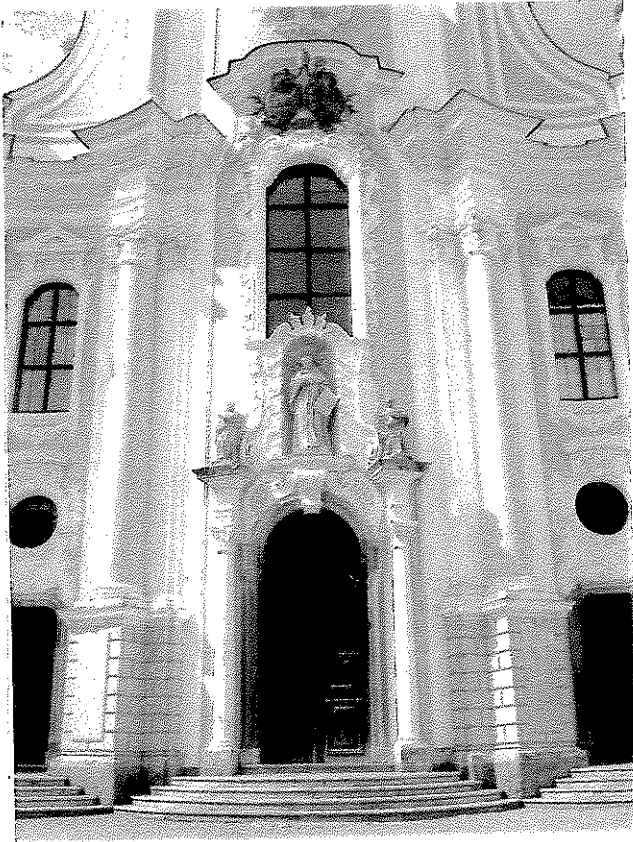
Abb. 59: Rein, Zisterzienser-Stiftskirche Mariae Himmelfahrt, 1738 – 1747, Fassade, Mittelachse.
