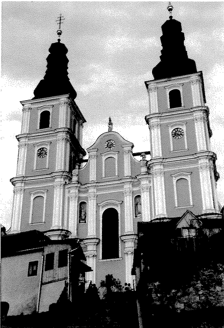
Abb. 85: Graz, Pfarr- und Wallfahrtskirche Mariatrost, 1714 – 1746?, Doppelturmfassade.
