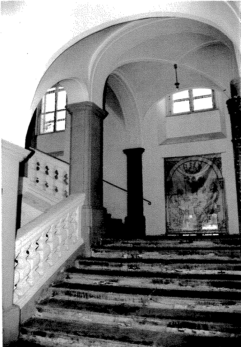
Abb. 124: Rein, Zisterzienserstift, Nördlicher Trakt, Treppenhaus, Innenansicht.
