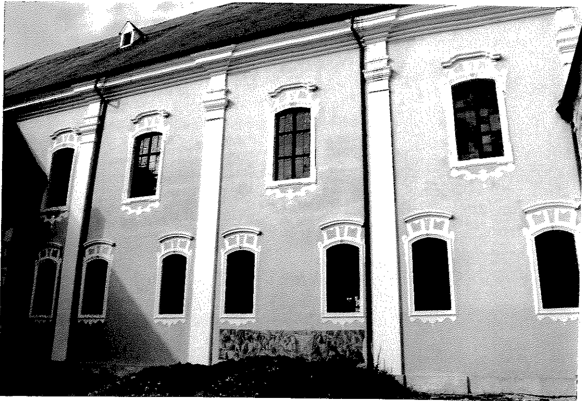
Abb. 69: Rein, Zisterzienser-Stiftskirche Mariae Himmelfahrt, nördliche Seitenfassade.
