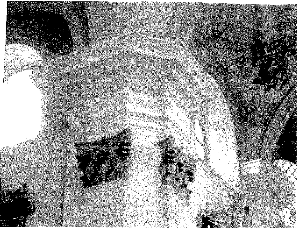
Abb. 105: Graz, Pfarr- und Wallfahrtskirche Mariatrost, 1714 – 1746?, Innenansicht, Gebälkverkröpfung im Bereich der Vierung.
