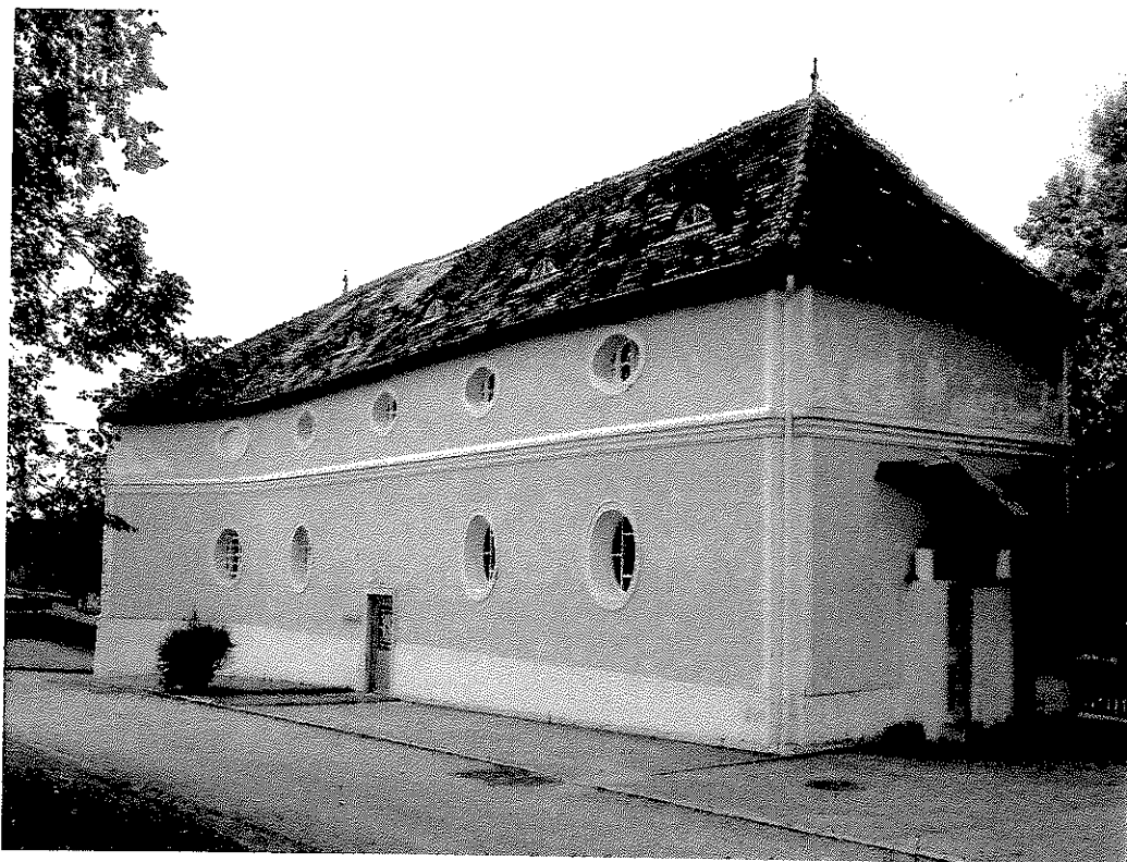
Abb. 144: Schielleiten, Schloss (Neu-)Schielleiten, nach 1717 – 1731?, Nebengebäude.
