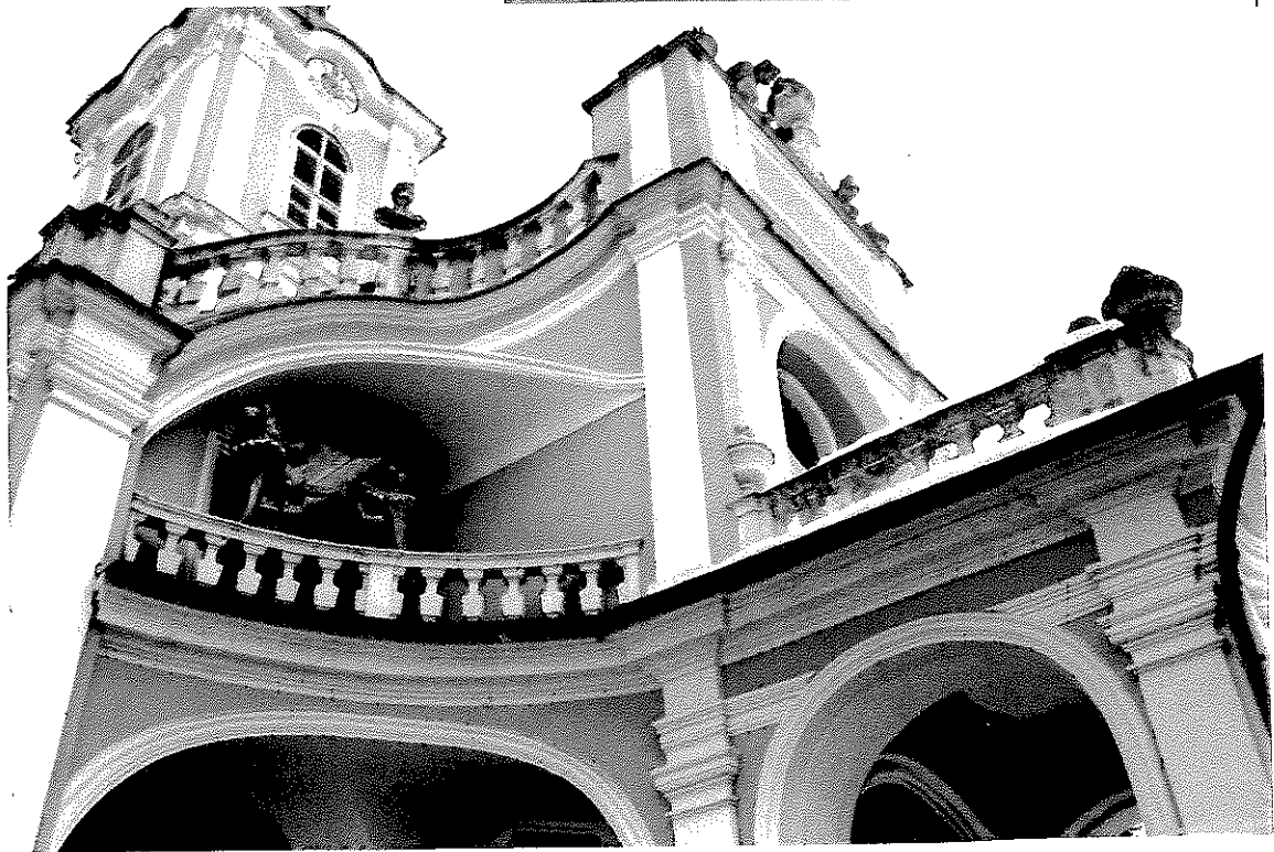
Abb. 16: Graz, Heilige Stiege, Fassade, Seitenansicht des Obergeschosses.
