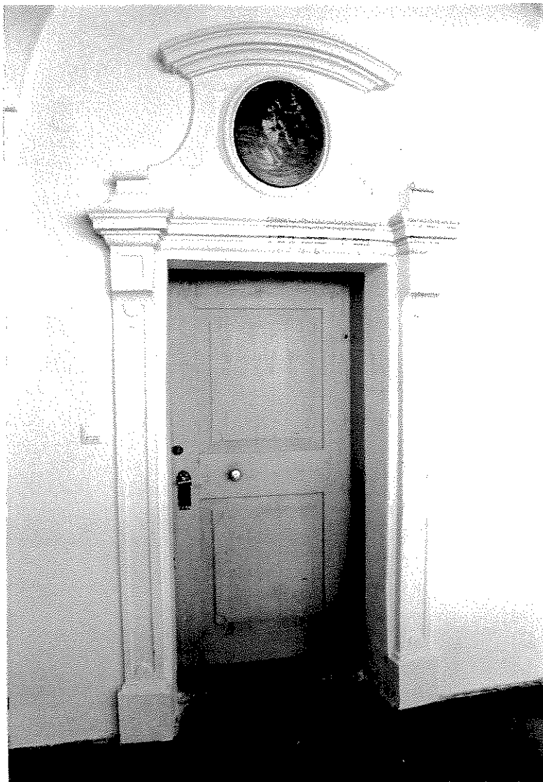
Abb. 130: Rein, Zisterzienserstift, Neuer Konvent, Eingangstüre zu einer Mönchszelle.
