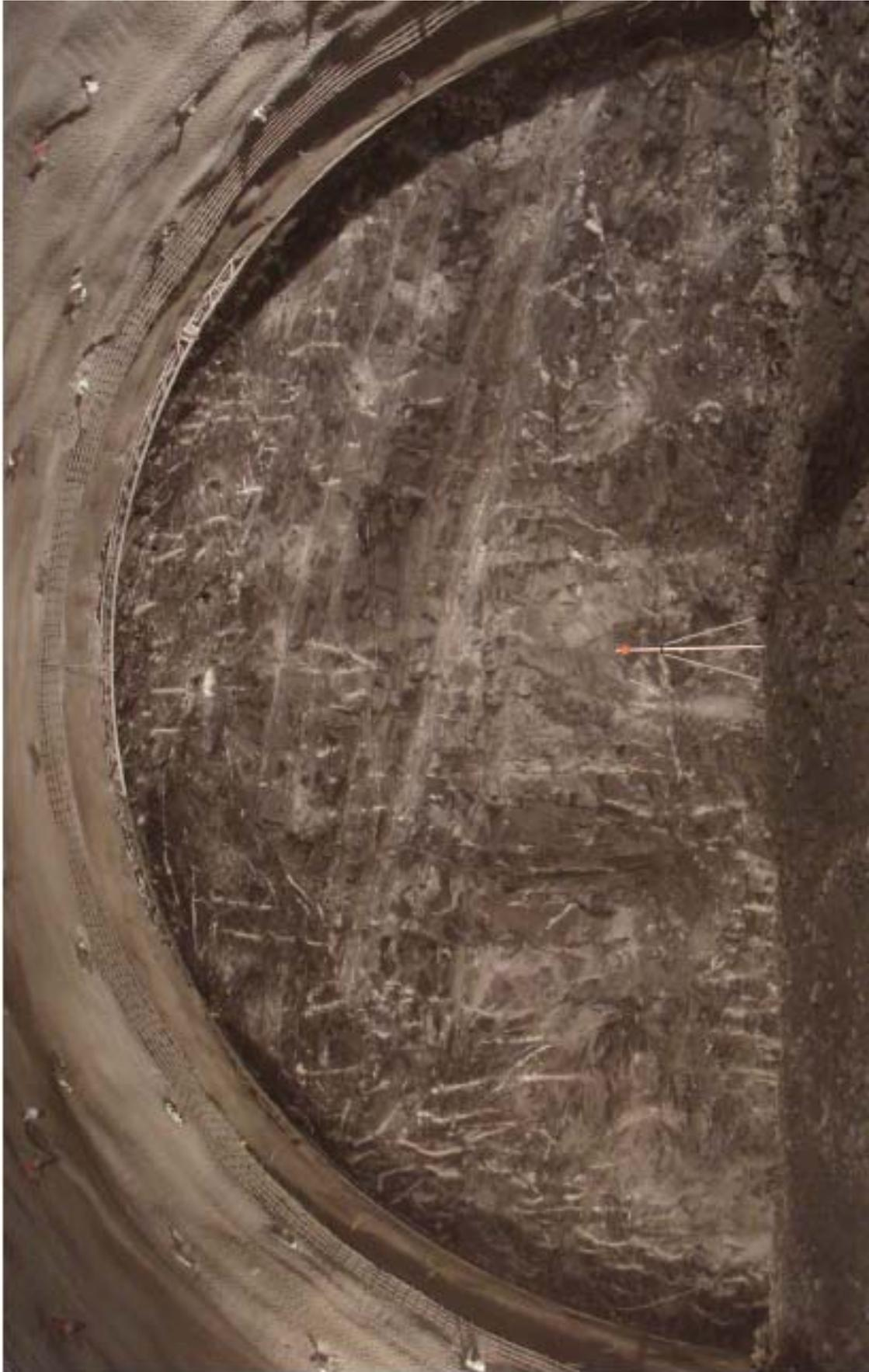
**Abb.34** Station [m]: 780,30 tiefere Kahlenberg-Formation: kompetenterer Gesteinskörper umgeben von stärker zerlegtem Material (Blickrichtung: Südost)
