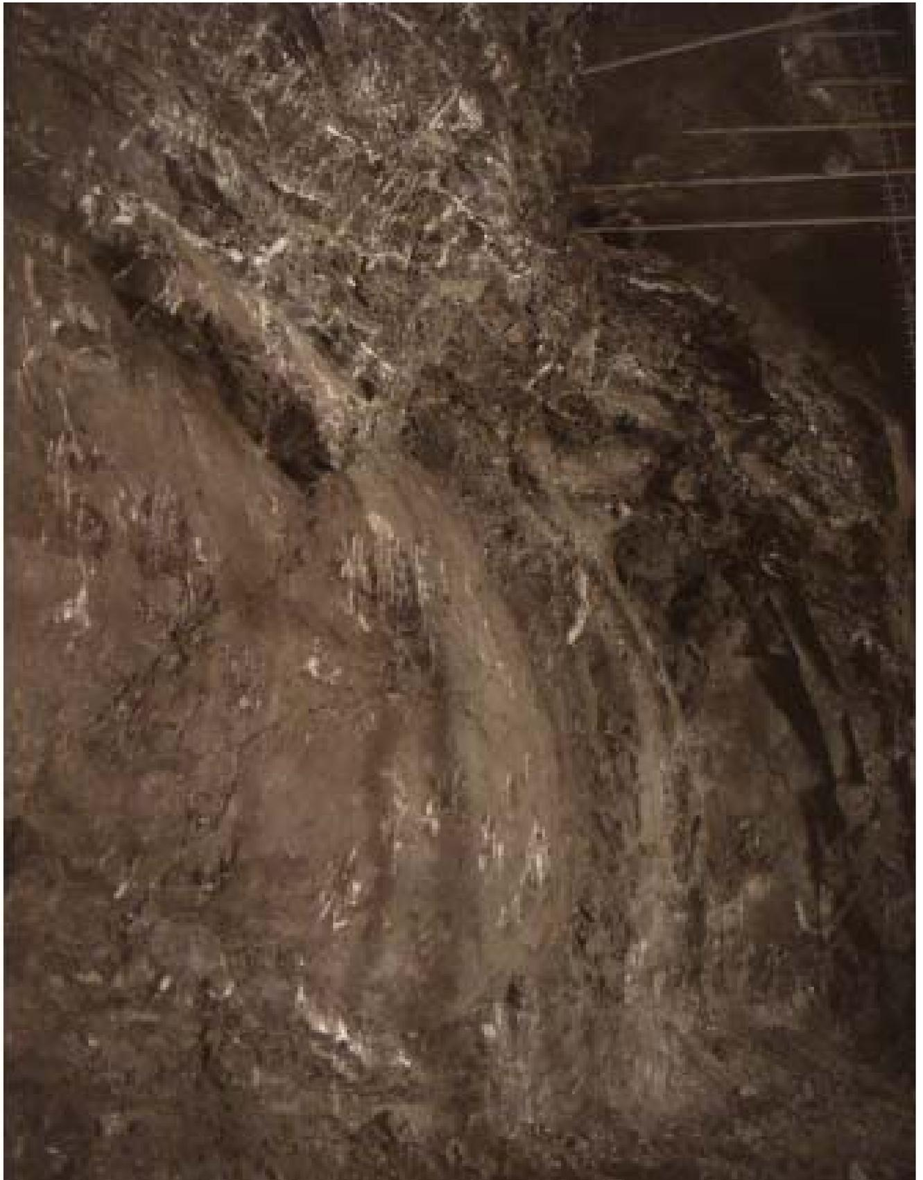
**Abb.36** Station [m]: 878,70 tiefere Kahlenberg-Formation: Scharnierbereich einer großen Falte (Blickrichtung entlang der Ortsbrust -> Südsüdwest )
