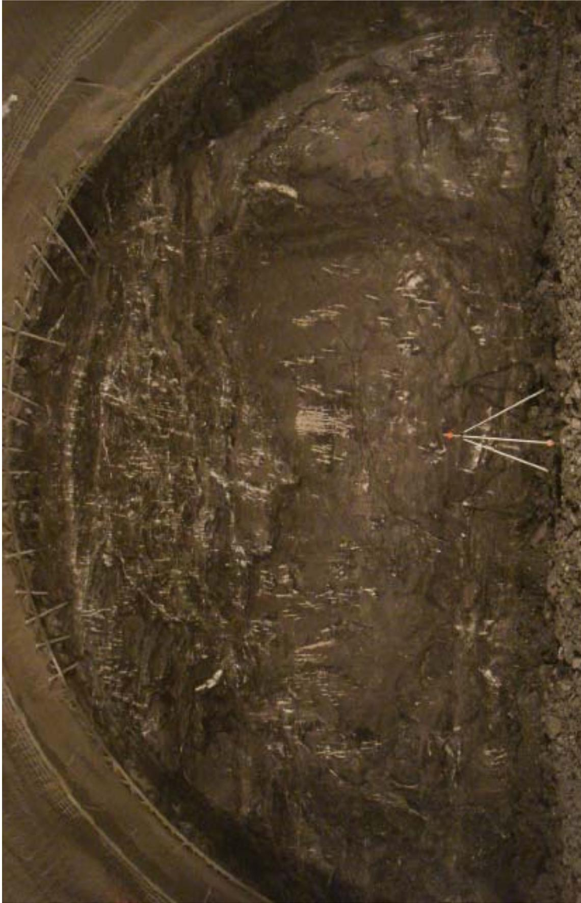
**Abb.35** Station [m]: 878,70 tiefere Kahlenberg-Formation: Scharnierbereich einer großen Falte (Blickrichtung: Südost)
