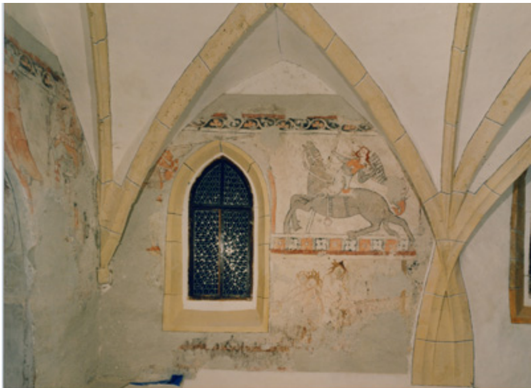
Abbildung 8: Filialkirche, Langhaus, Südwand (Gerald Duschek)
