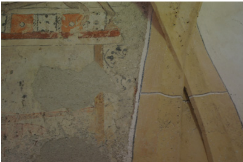
Abbildung 32: Filialkirche, Südwand, Detail Rahmenband (Florian Leitner)
