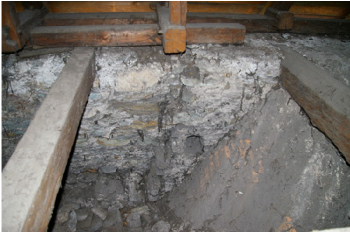
Abbildung 13: Filialkirche, Dachboden, Baufuge (Florian Leitner)
