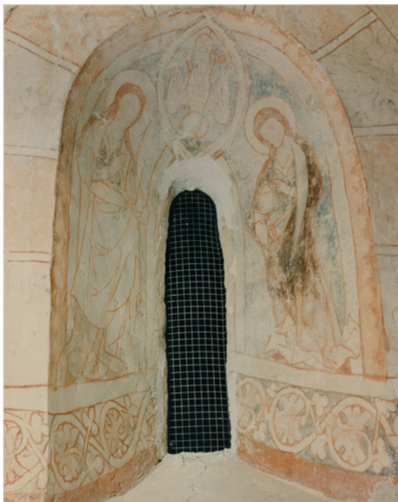
Abbildung 20: Filialkirche, Nordwand, Fensterleibung (Gerald Duschek)
