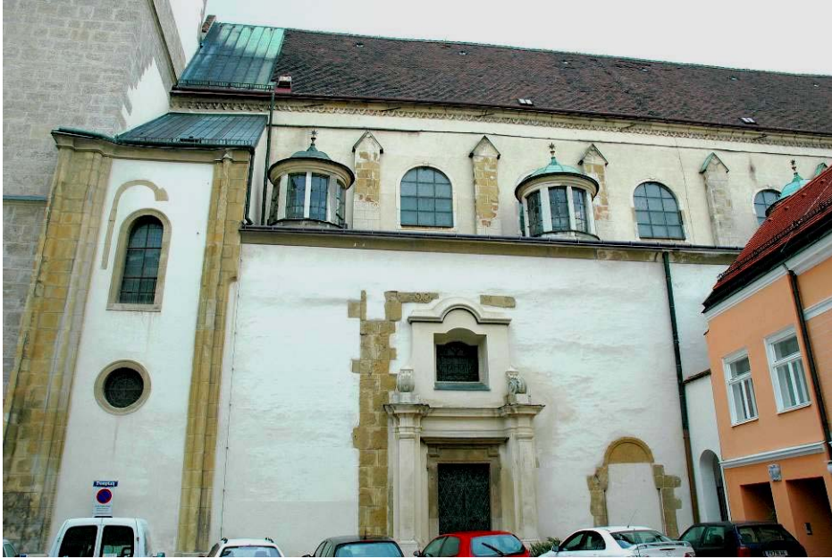
Abb. 5: St. Pöltner Dom, Südfassade Langhaus
