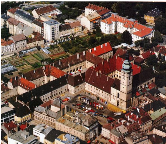
Abb. 3: Ehemaliges Augustiner-Chorherrenstift in St. Pöln, Luftbildaufnahme
