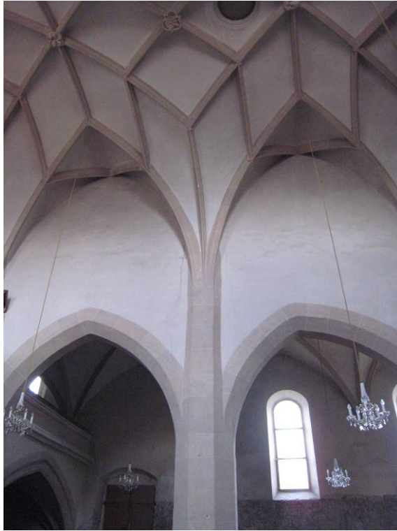
Abb. 197: Nußdorf - Mittelschiff, Rippenansatz
