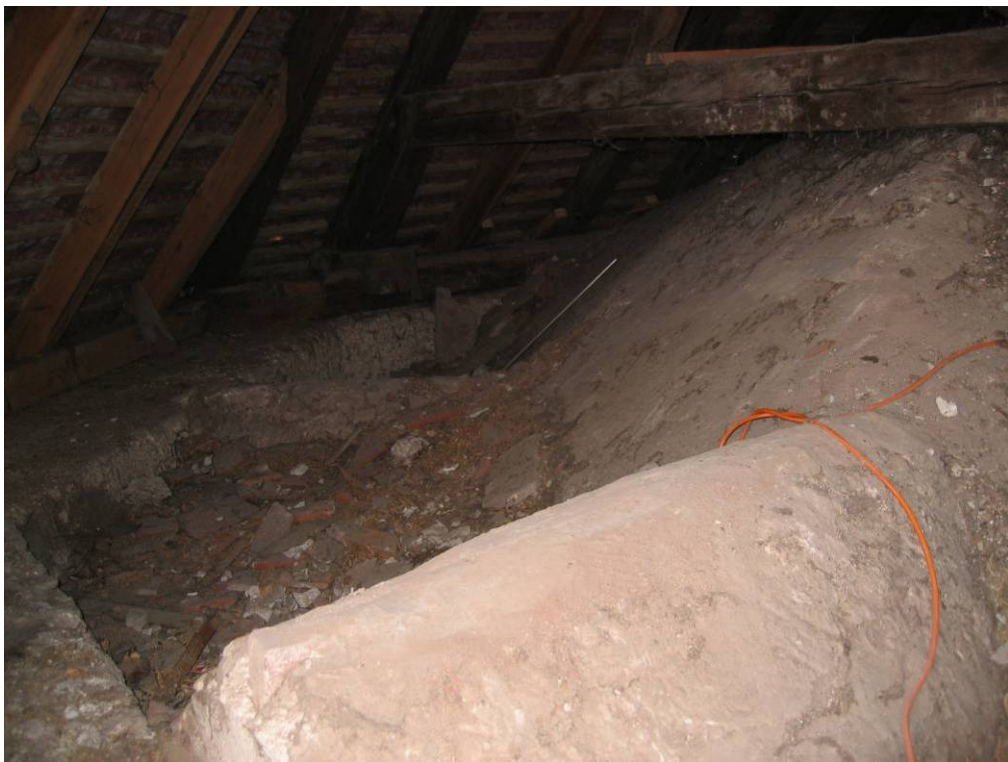
Abb. 174: Hollenburg - Sakristeidachraum, Gewölbe, Blick nach Süden
