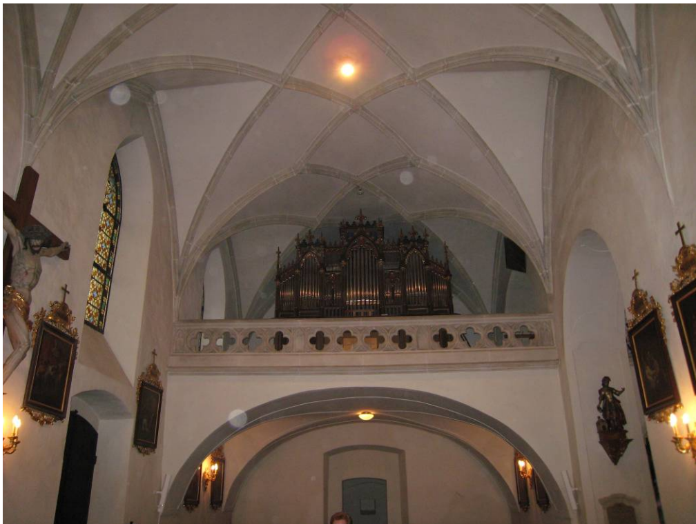
Abb. 224: Unterloiben - Hauptschiff, Netzrippengewölbe
