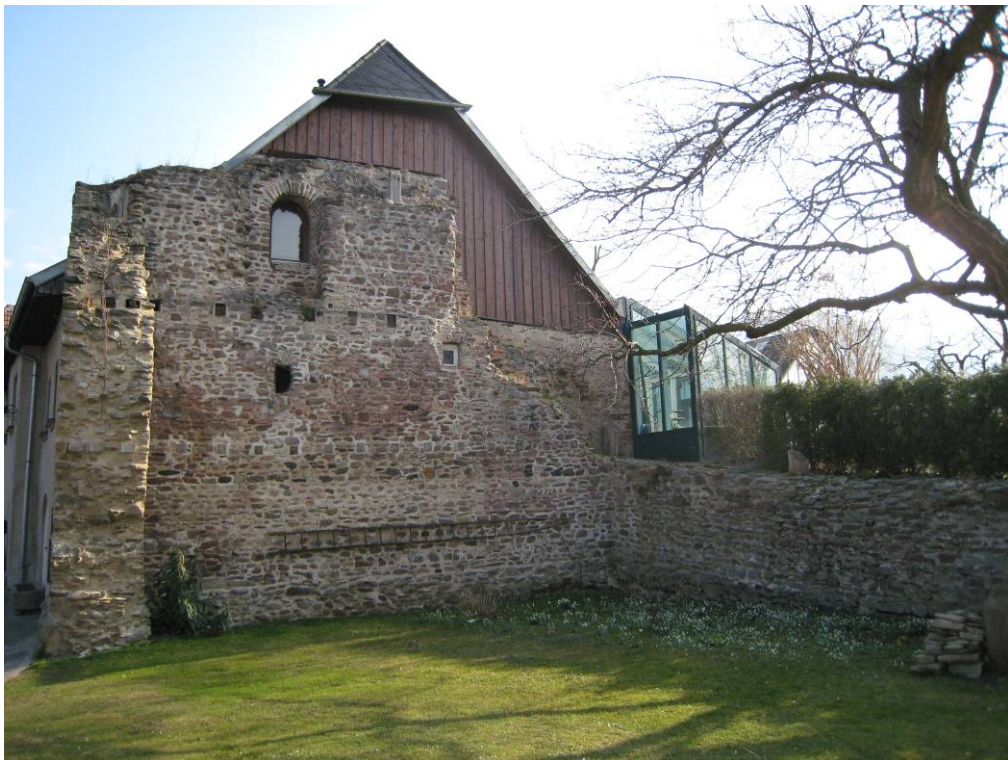
Abb. 240: Bacharnsdorf - Reste eines römischen Wehrturmes
