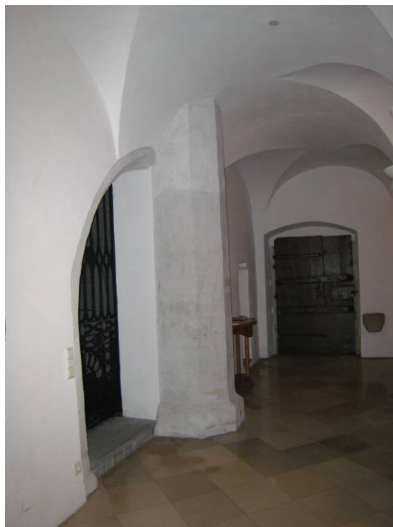
Abb. 72: Hollenburg - Langhaus, Nordwestpfeiler
