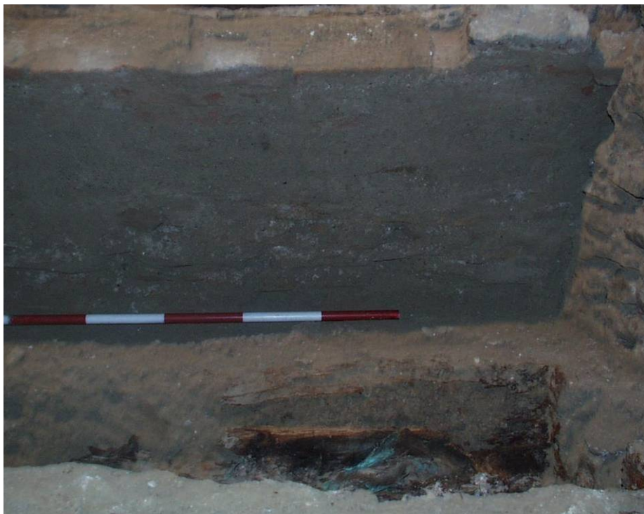
Abb. 260: Hollenburg - Beinhaus, Mauer M4, Südansicht 2
