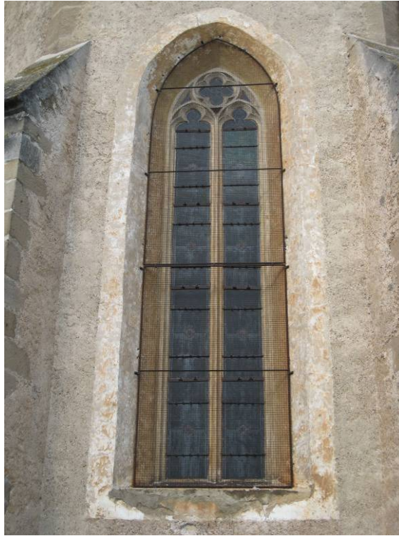
Abb. 35: Hollenburg - Chor, östliches Maßwerkfenster
