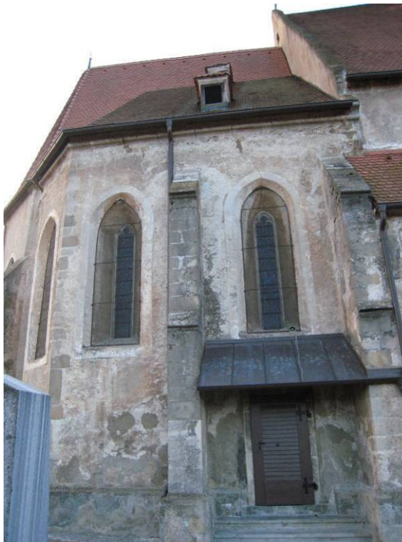
Abb. 42: Hollenburg - nördlicher Seitenchor, Nordansicht
