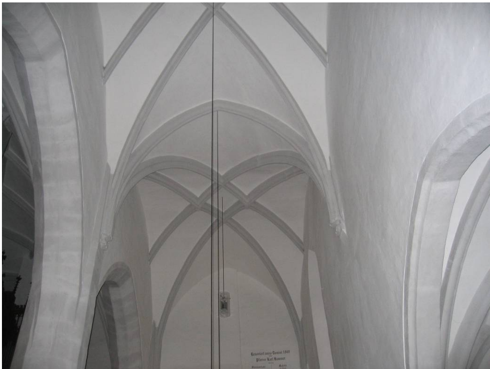
Abb. 82: Hollenburg - nördliches Seitenschiff, Parallelrippengewölbe
