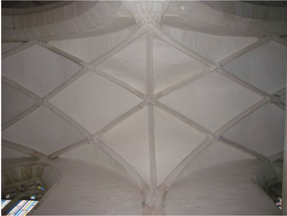
Abb. 219: Unterwölbling - Seitenschiff, Netzrippengewölbe
