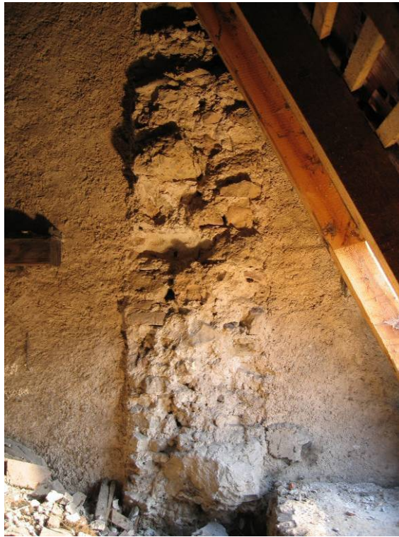
Abb. 165: Hollenburg - Sakristeidachraum, Chorwand, Strebepfeiler
