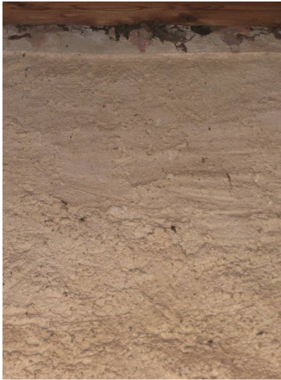
Abb. 167: Hollenburg - Sakristeidachraum, Chorwand, Putz im Dachraum
