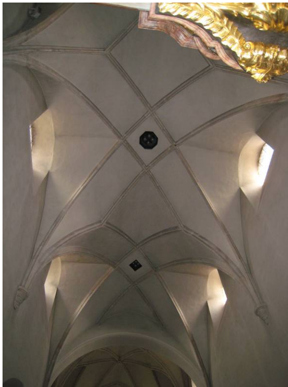
Abb. 226: Emmersdorf - Netzrippengewölbe
