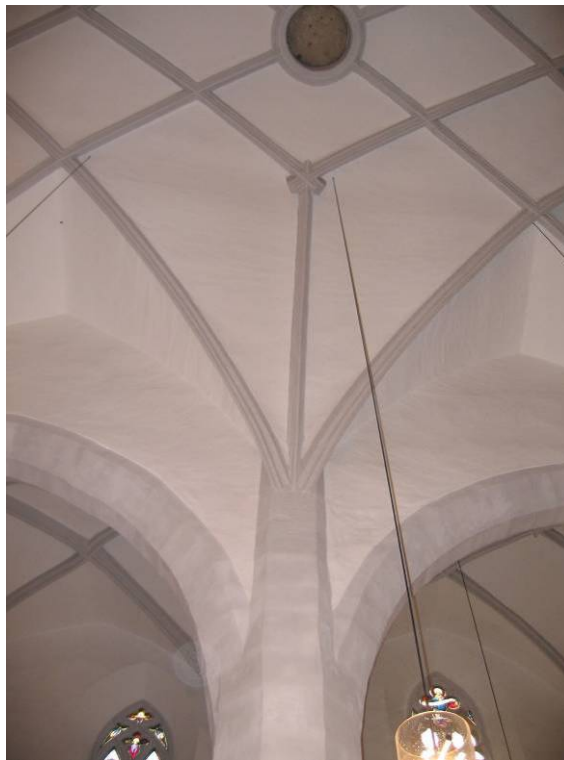
Abb. 80: Hollenburg - Mittelschiff, Rippenansatz auf hochgezogenen Oktogonflächen
