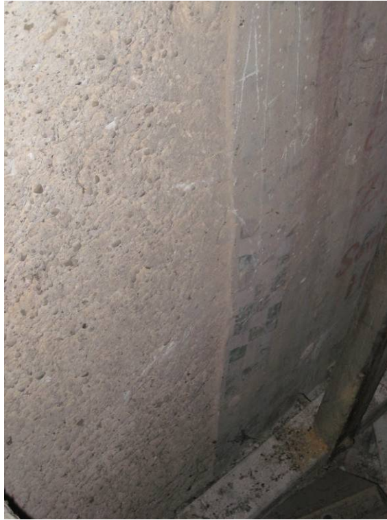
Abb. 69: Hollenburg - Turm, Nordwand Freskoreste, Blick von Langhausdachraum
