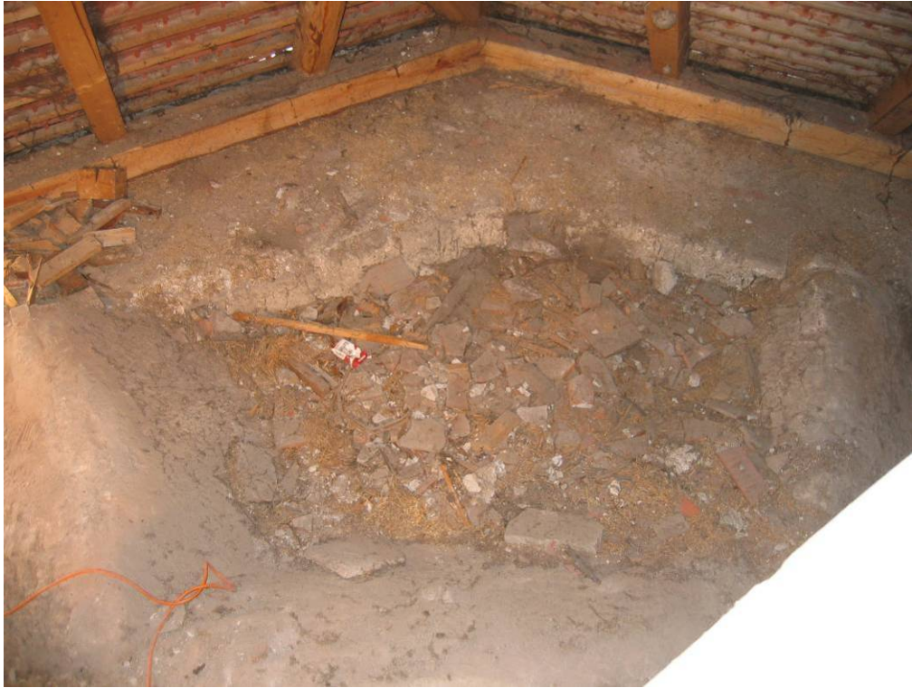
Abb. 175: Hollenburg - Sakristeidachraum, Gewölbe, Südostecke
