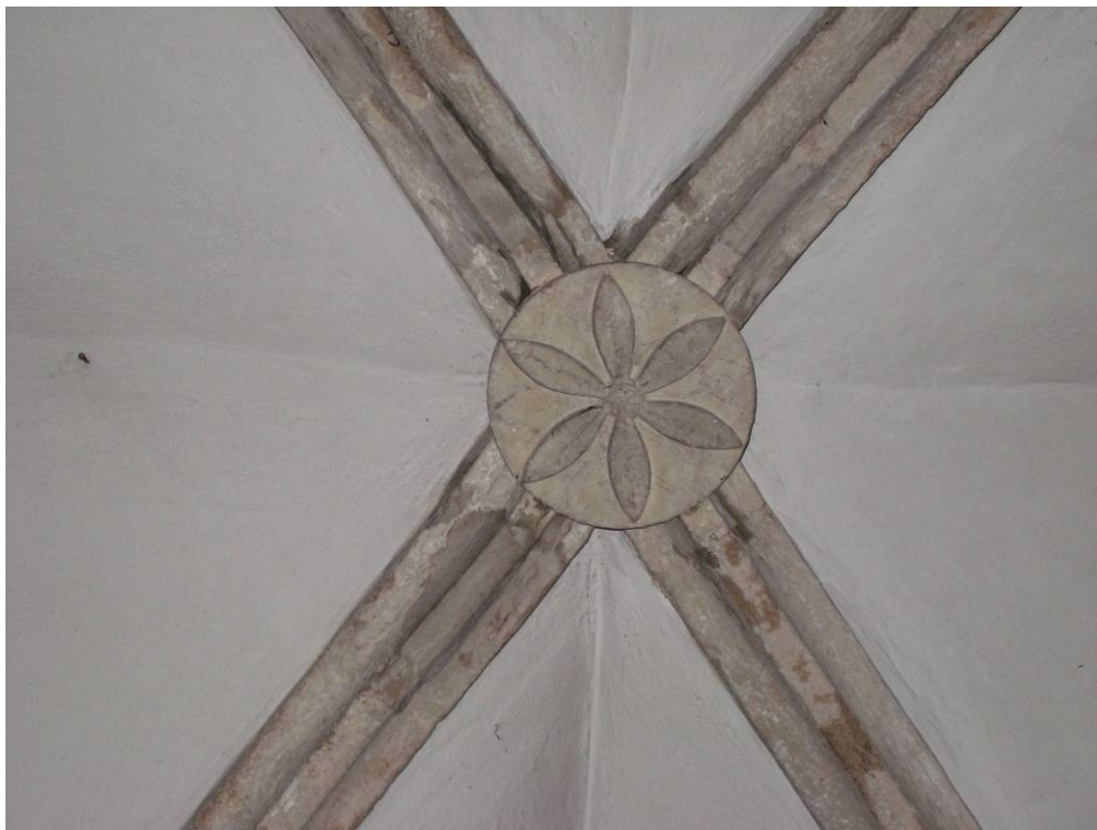
Abb. 131: Langenlois - nördliches Seitenschiff, Schlussstein um 1280
