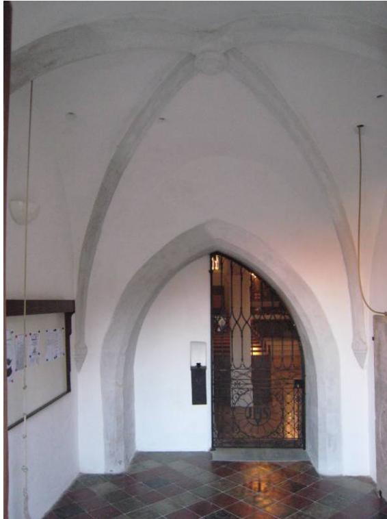
Abb. 61: Hollenburg - Turmerdgeschoß Gewölbe auf geflockten Konsolen
