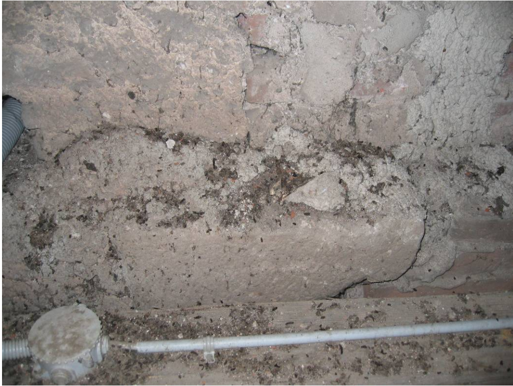
Abb. 139: Hollenburg - Traufengesimse, Blick vom Dachraum des Langhauses gegen Osten
