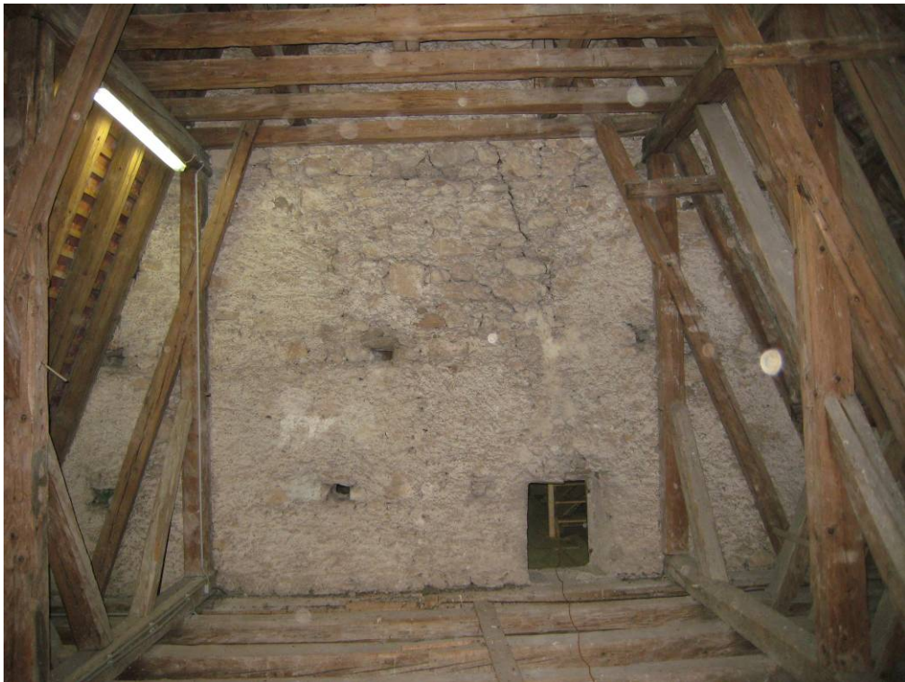
Abb. 138: Hollenburg - Giebelwand des Chordaches, Blick nach Westen
