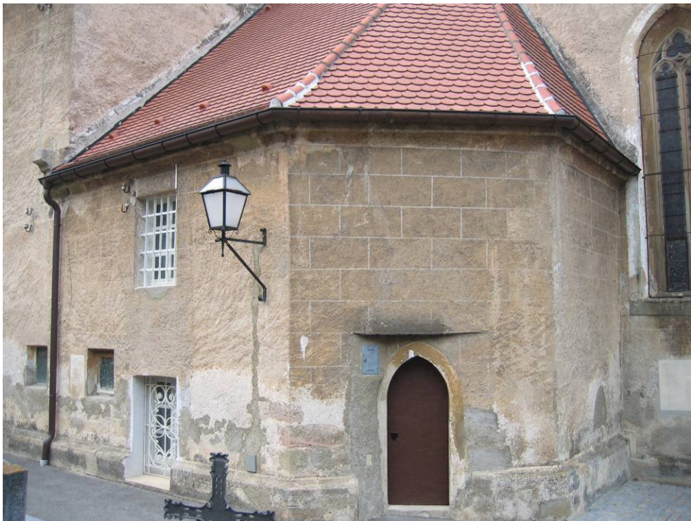
Abb. 30: Hollenburg - Sakristei, Türe
