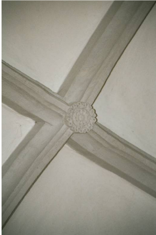
Abb. 83: Hollenburg - nördliches Seitenschiff, Parallelrippengewölbe; Rosette 1
