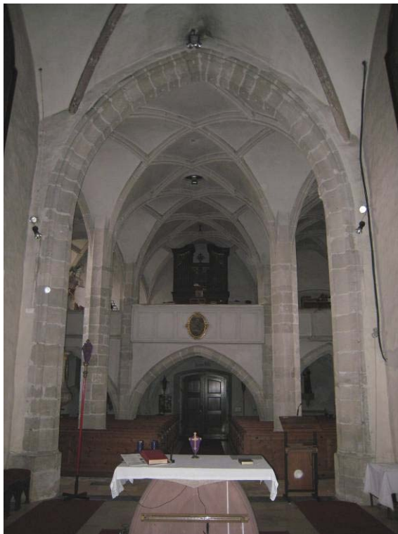
Abb. 222: Kleinpöchlarn - Mittelschiff, Netzrippengewölbe
