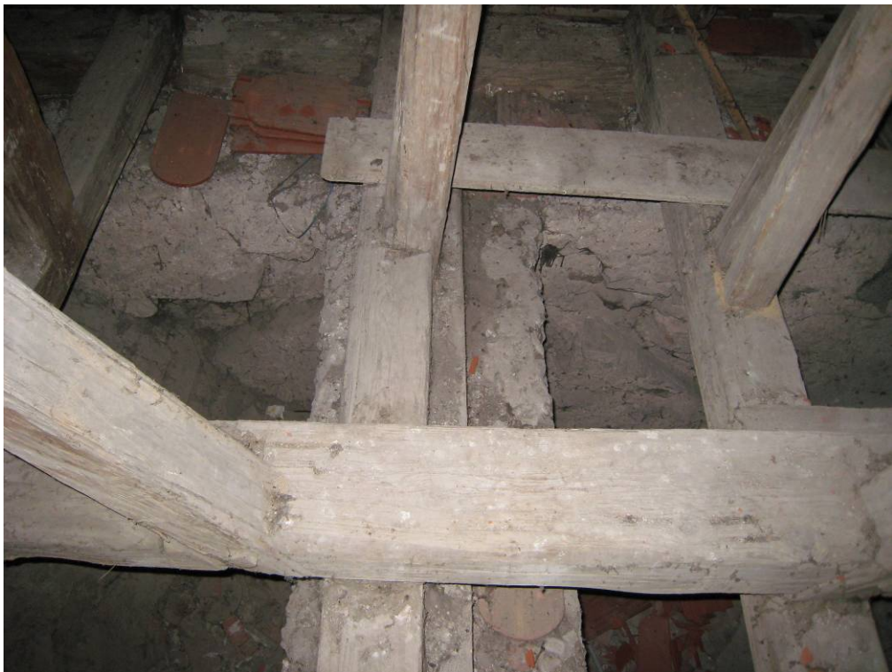
Abb. 230: Hollenburg - Dachgeschoß, südwestliches Seitenschiffjoch vorbereiteter Gewölbeansatz
