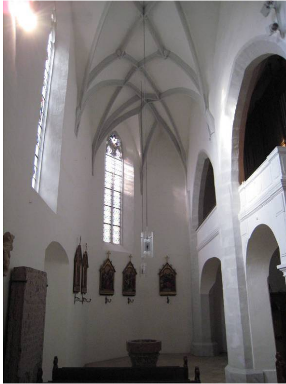
Abb. 73: Hollenburg - südliches Seitenschiff, Achteckpfeiler
