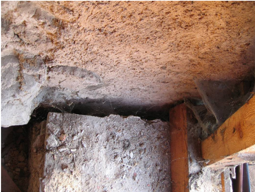
Abb. 163: Hollenburg - Sakristeidachraum, Ostwand, Baufuge
