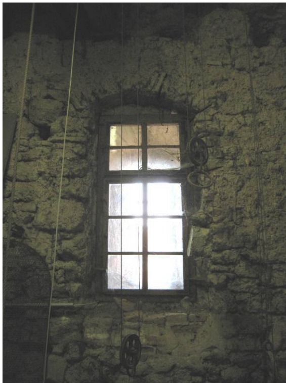
Abb. 64: Hollenburg - 1. Obergeschoß, Mauerwerk
