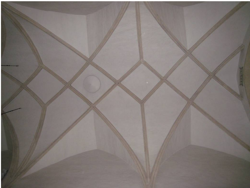
Abb. 220: Rabenstein - Mittelschiff, Netzrippengewölbe
