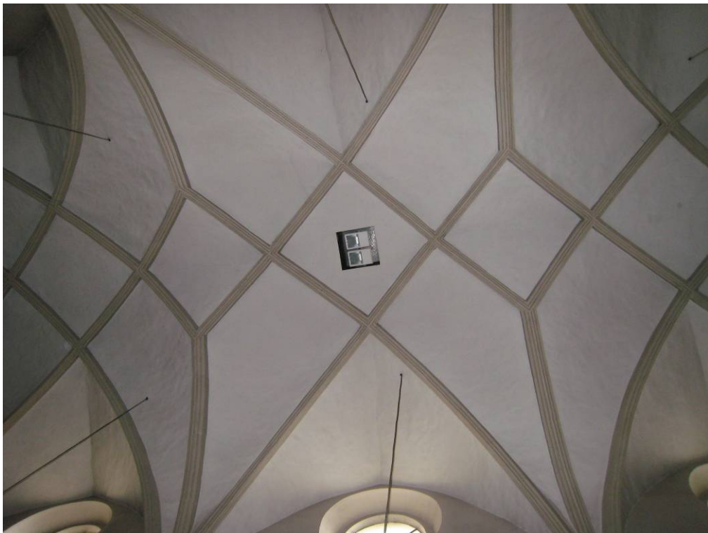
Abb. 218: Obergrafendorf - Mittelschiff, Netzrippengewölbe
