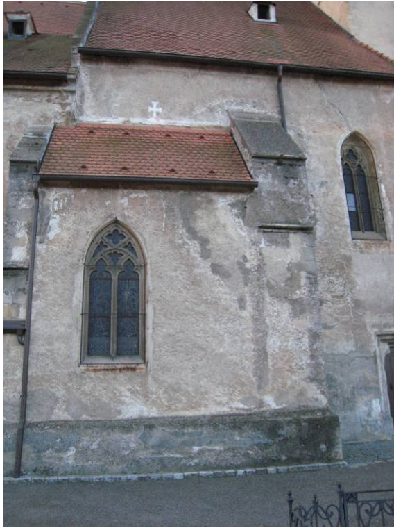
Abb. 45: Hollenburg - Langhaus, östliches Joch, Maßwerkfenster
