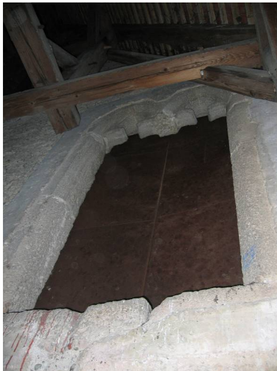
Abb. 158: Hollenburg - Turm, Ostwand, Blick vom Langhaus
