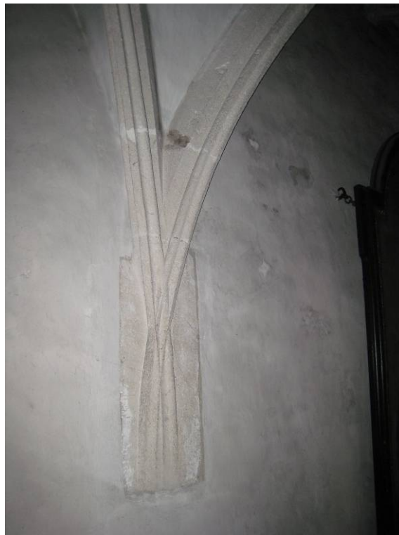
Abb. 210: Kleinpöchlarn - gekreuzter Rippenansatz
