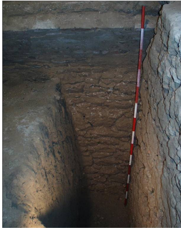
Abb. 263: Hollenburg - Beinhaus, Mauer M4, Südansicht, Probeschacht
