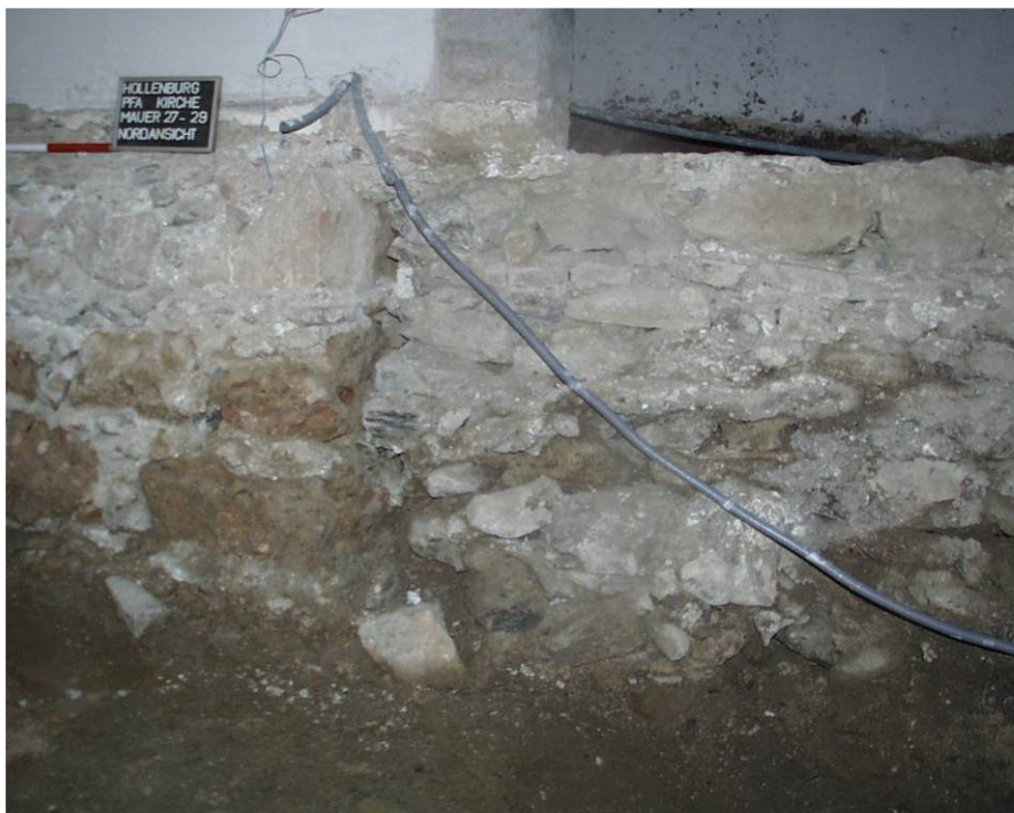
Abb. 246: Hollenburg - Langhaus, Mauer M27-29, Nordansicht 2
