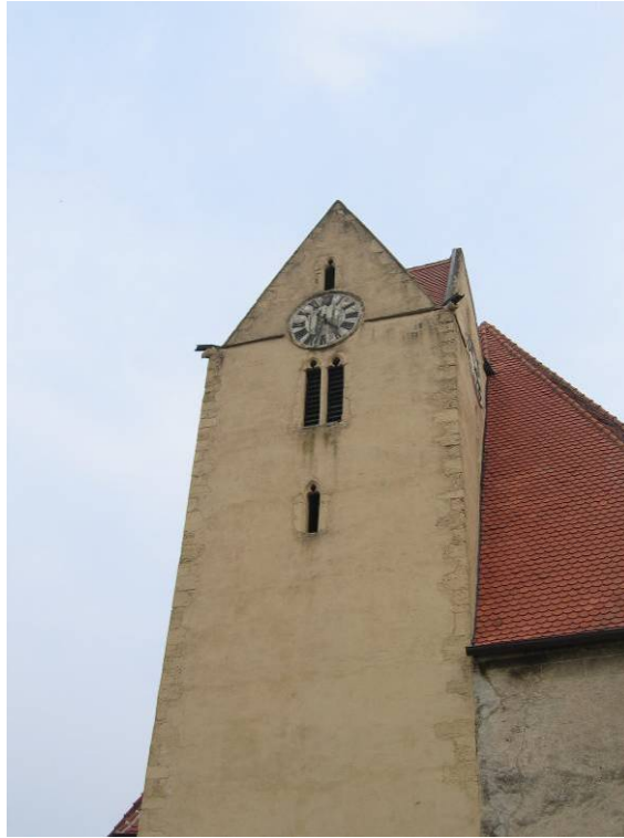
Abb. 19: Hollenburg - Westturm, Westseite, 2. und Schallschoß
