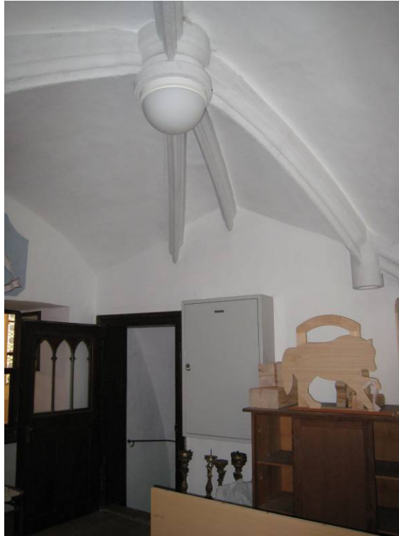
Abb. 177: Hollenburg - Sakristei, Oratorium, Gewölberippen
