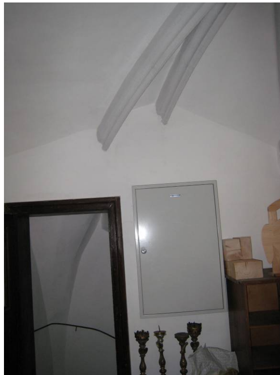
Abb. 176: Hollenburg - Sakristei, Ausgang ins Oratorium, Gewölberippen Nordost Ecke
