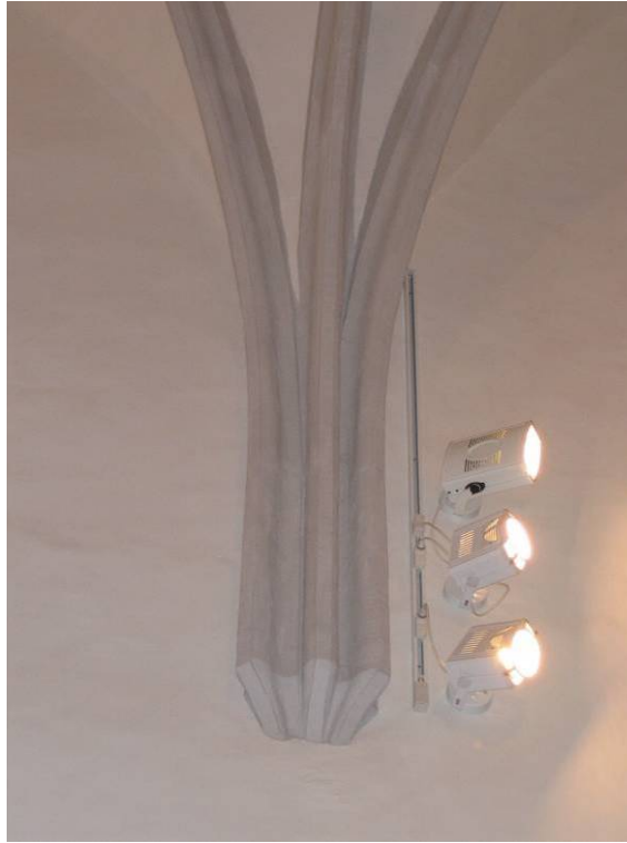
Abb. 95: Hollenburg - Chorgewölbe, Rippenstäbe
