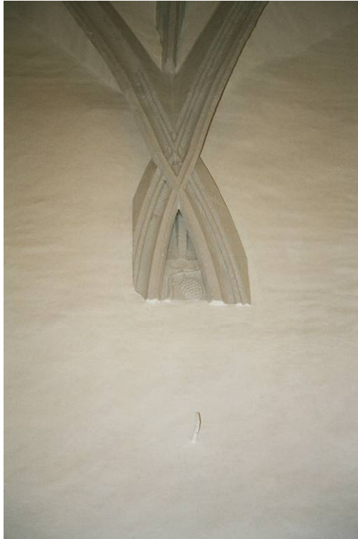
Abb. 77: Hollenburg - Südliches Seitenschiff, Gewölbe, westliches Joch
