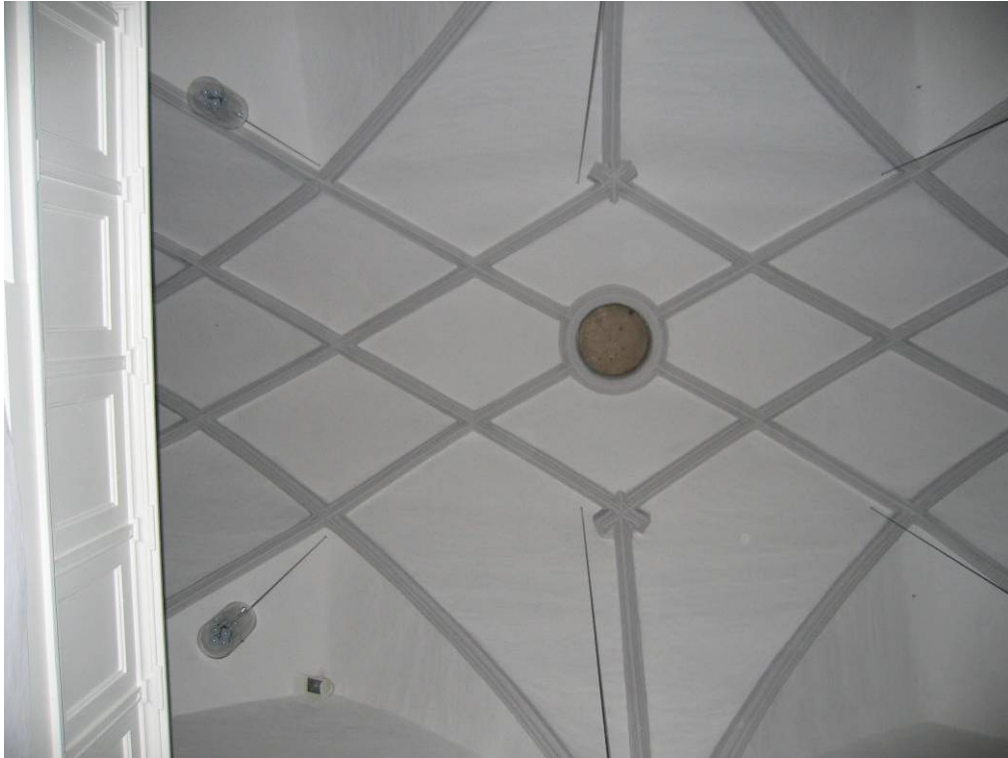
Abb. 81: Hollenburg - Mittelschiff, Parallelrippengewölbe
