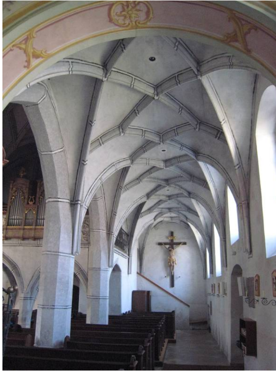
Abb. 225: Hofarnsdorf - nördliches Seitenschiff, Netzrippengewölbe
