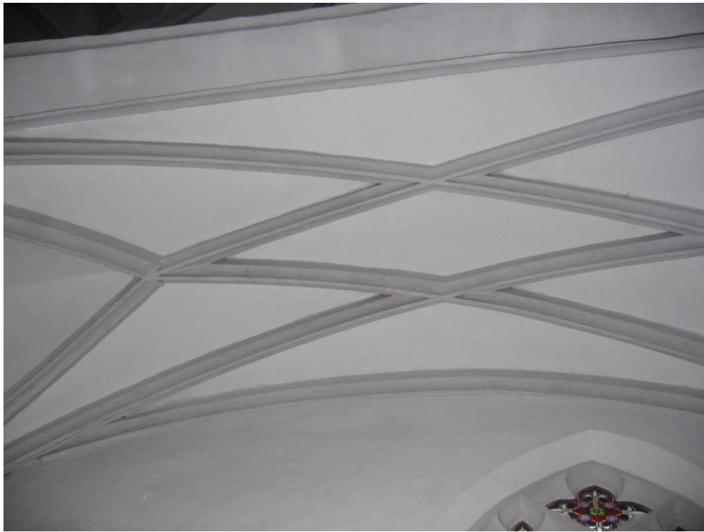
Abb. 87: Hollenburg - nördliche Kapellennische, Parallelrippengewölbe
