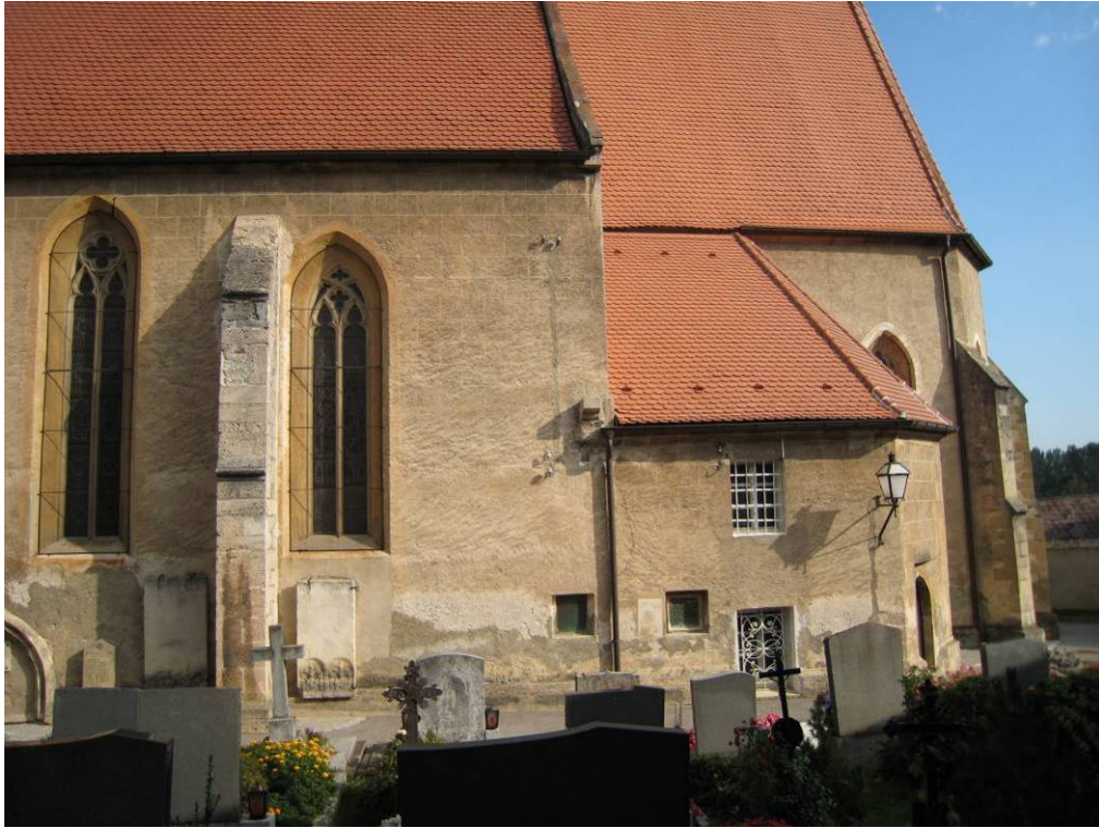
Abb. 29: Hollenburg - Sakristei, Südseite
