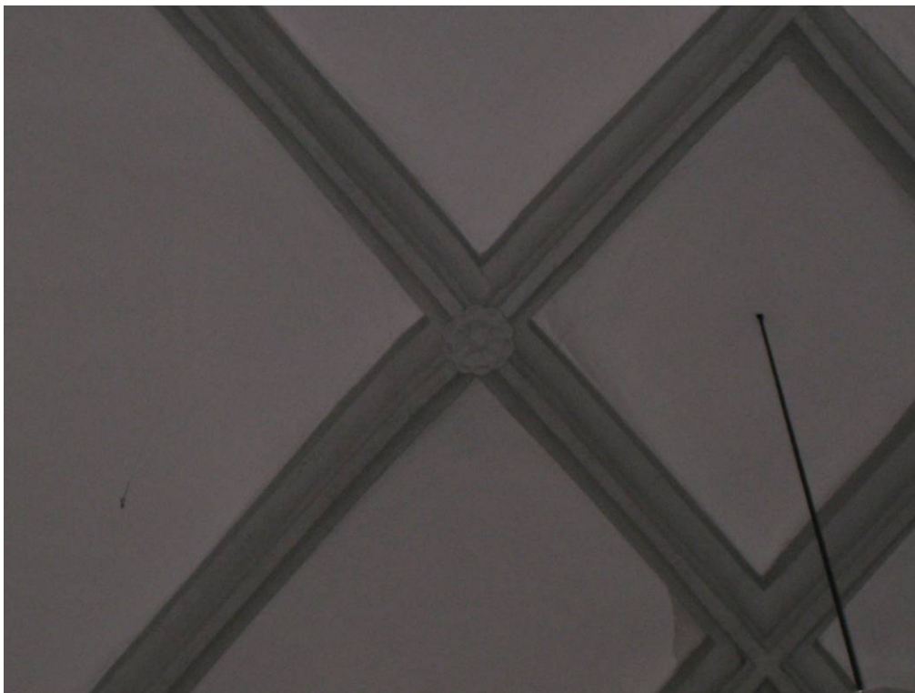
Abb. 84: Hollenburg - nördliches Seitenschiff, Parallelrippengewölbe; Rosette 2
