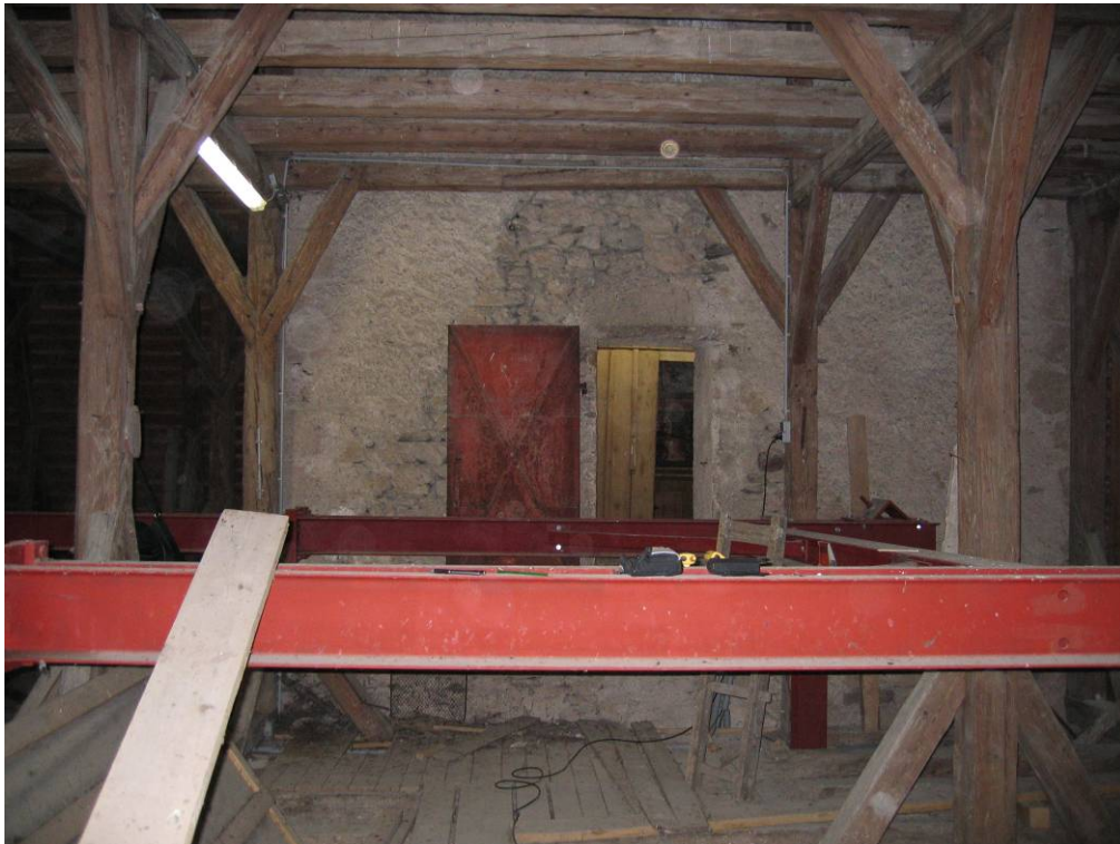
Abb. 126: Hollenburg - Turmostwand, Blick nach Westen, Dachabdruck
