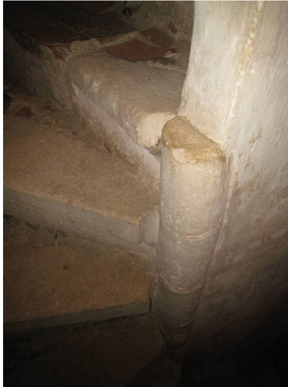
Abb. 231: Unterwöbling - Treppenturm, innen
