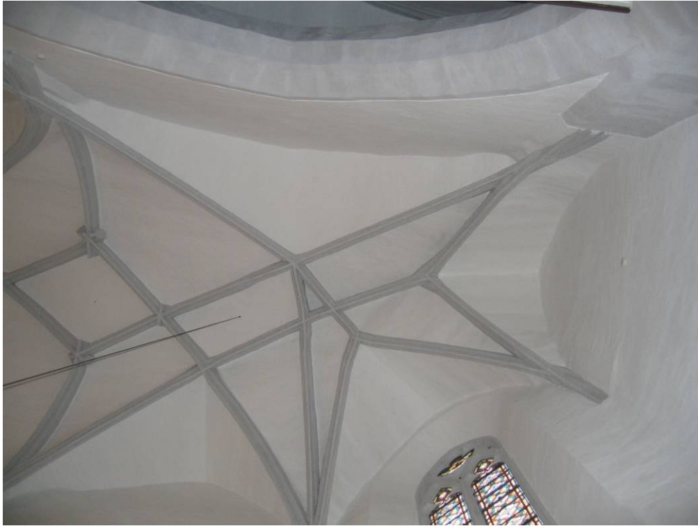
Abb. 79: Hollenburg - Südliches Seitenschiff, Gewölbe, westliches Joch
