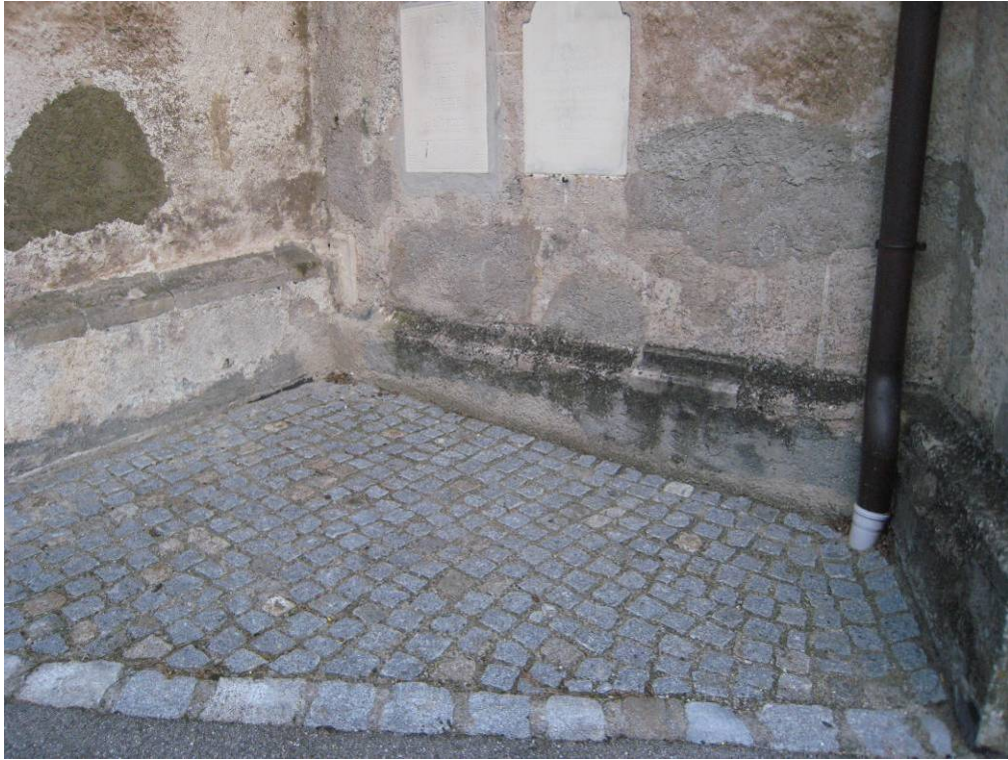
Abb. 39: Hollenburg - Chor, Südwand, Sockelgliederung
