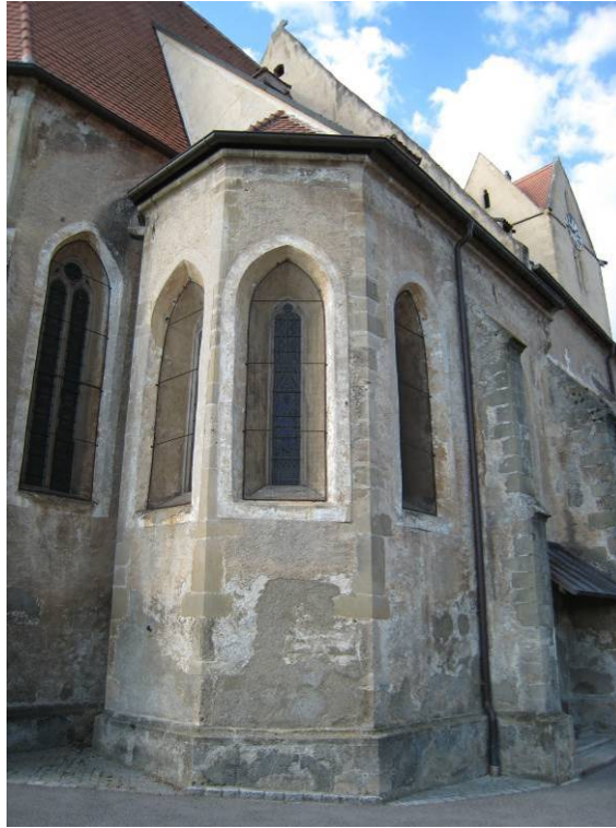
Abb. 41: Hollenburg - nördlicher Seitenchor, Nordostansicht
