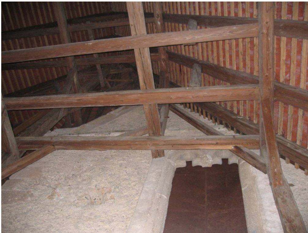
Abb. 232: Hollenburg - Turm, Ostwand, Schallgeschoß, Fenster
