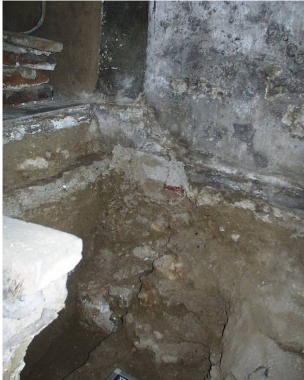
Abb. 265: Hollenburg - Presbyterium, Baufuge zwischen Mauer M5 und dem Chorabschluss
