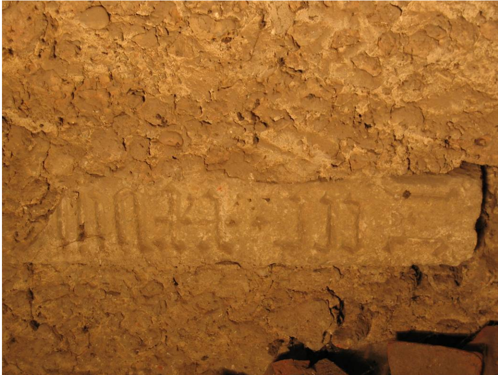
Abb. 229: Hollenburg - Dachgeschoß, vermauerte Grabplatte
