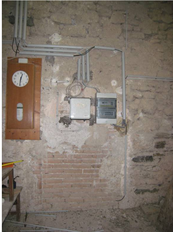
Abb. 151: Hollenburg - Turm, 1.OG, vermauerte Türöffnung, Farbreste
