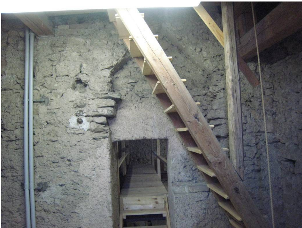
Abb. 66: Hollenburg - 2. Obergeschoß, Türöffnung in Dachraum des Langhauses
