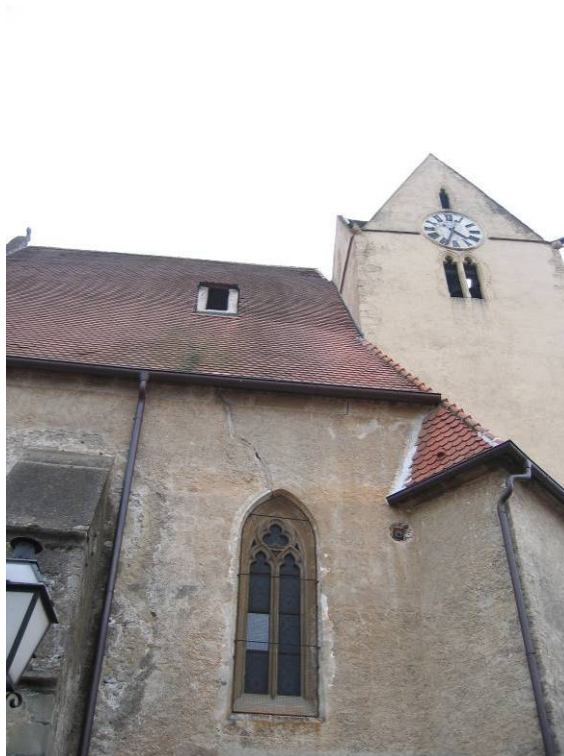
Abb. 22: Hollenburg - Westturm, Nordseite Giebelfenster
