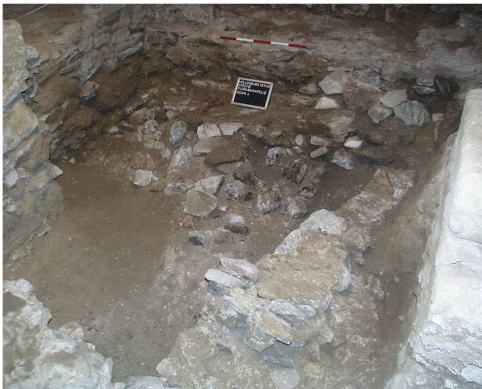
Abb. 238: Hollenburg - Florianikapelle, Mauer M13, Dokumentation
