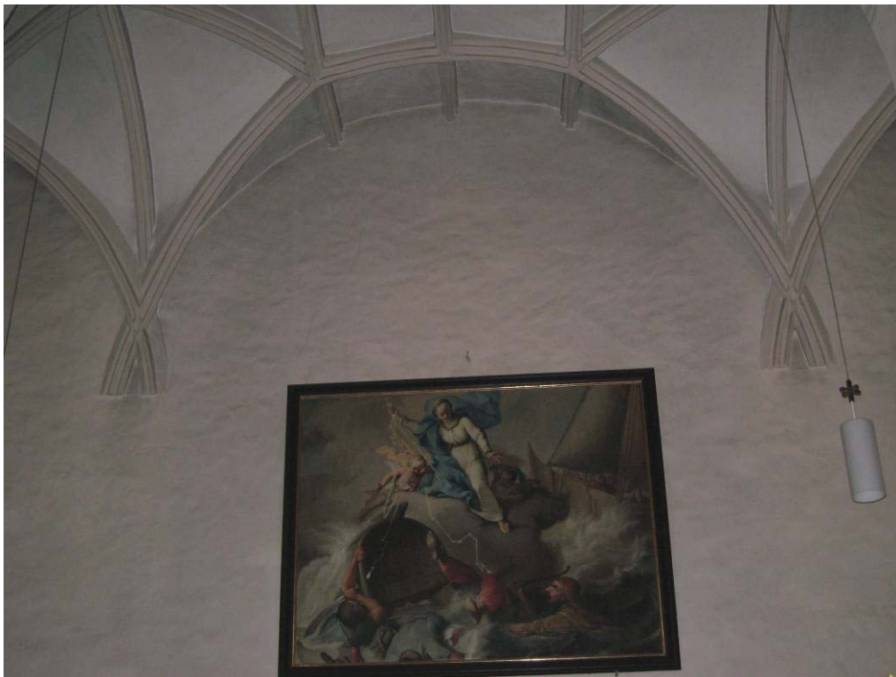
Abb. 212: Mank - gekreuzter Rippenansatz
