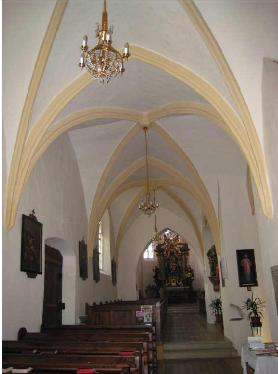
Abb. 143: St. Leonhard am Forst - Seitenschiff, Rippenstäbe
