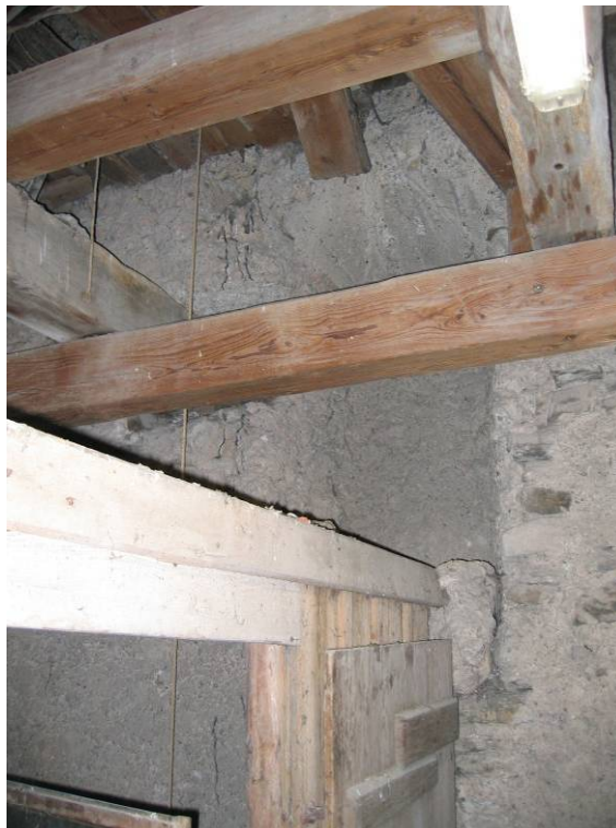
Abb. 156: Hollenburg - Turm, 2. OG, Nordwand, vermauertes Fenster
