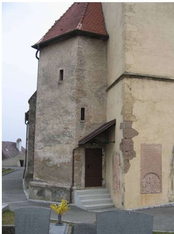
Abb. 48: Hollenburg - Treppenturm, Westansicht
