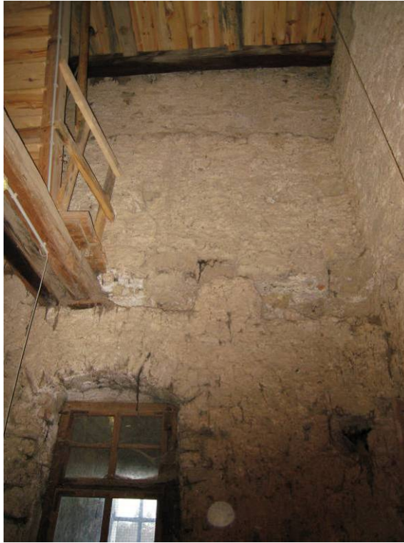
Abb. 65: Hollenburg - Turmmauerwerk, Verjüngung, Balkenlage ins 2. Obergeschoß
