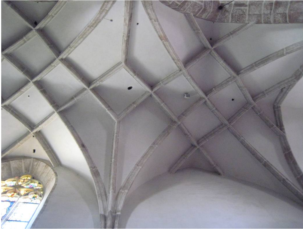
Abb. 223: Kilb - Mittelschiff, Netzrippengewölbe
