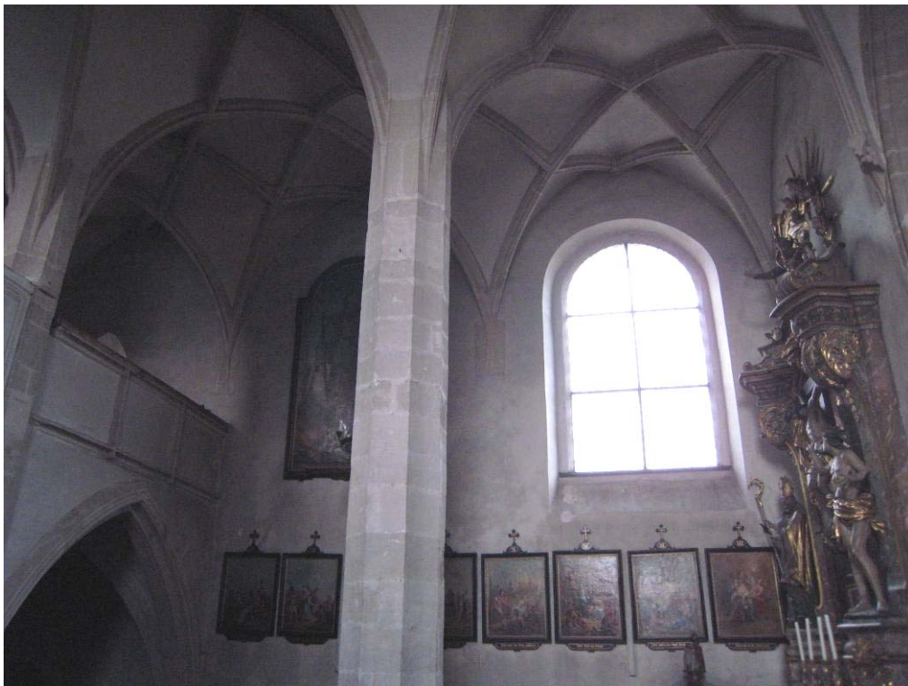
Abb. 200: Kleinpöchlarn - Rippenansatz
