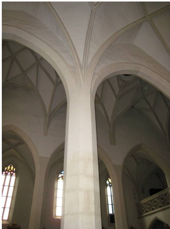
Abb. 196: Maria Laach - Mittelschiff, Rippenansatz
