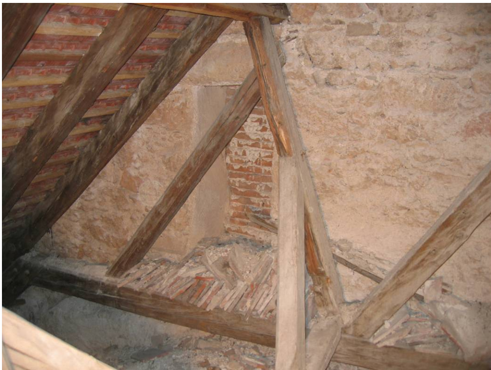
Abb. 164: Hollenburg - Sakristeidachraum, Westwand
