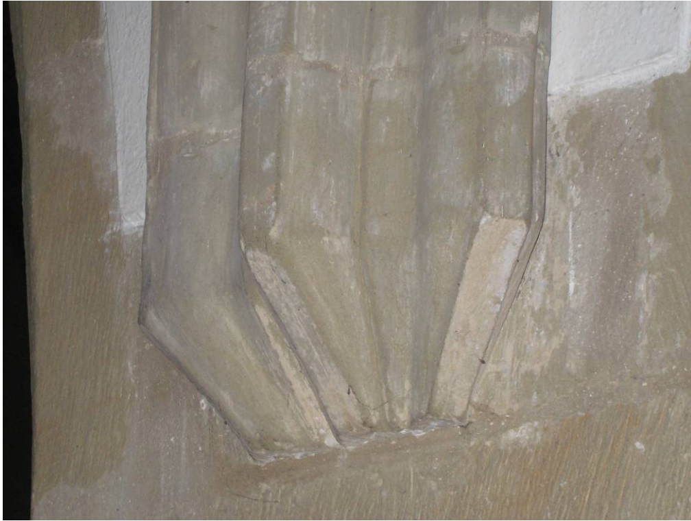
Abb. 145: Oberwölling - südliches Seitenschiff, Rippenstäbe
