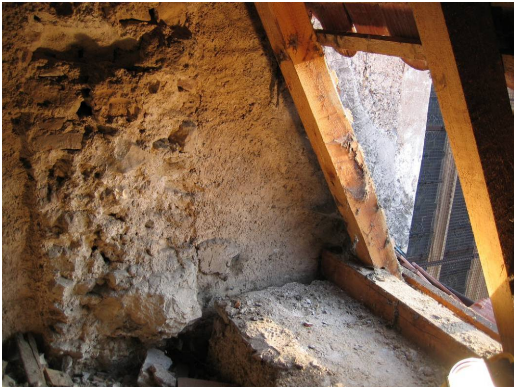
Abb. 166: Hollenburg - Sakristeidachraum, Chorwand, Strebepfeiler, Detail
