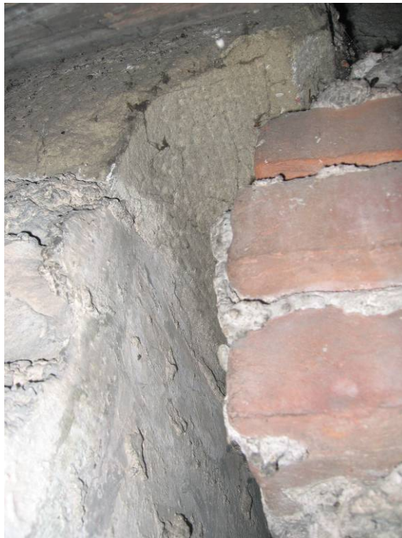
Abb. 140: Hollenburg - Setzungsfuge, Traufengesimse, Kehlung
