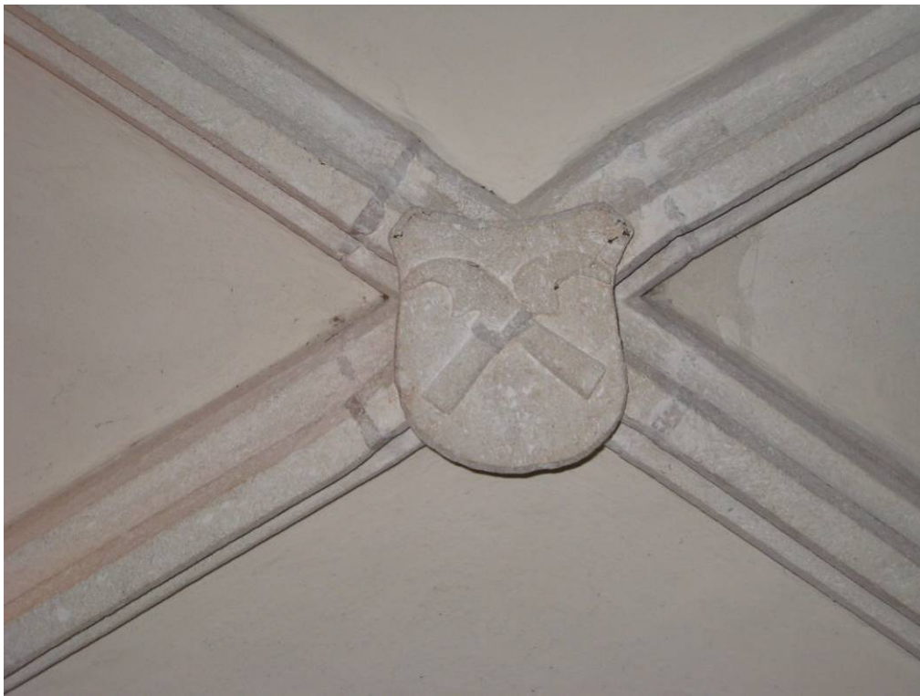
Abb. 204: Unterwöbling - Emporengewölbe, Schlussstein mit Hauerwerkzeug
