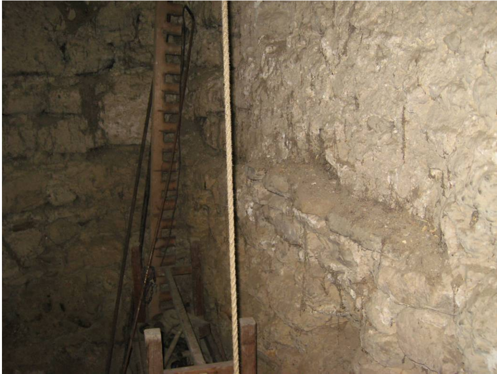
Abb. 153: Hollenburg - Turm, 1.OG, Nordwand, Baufuge
