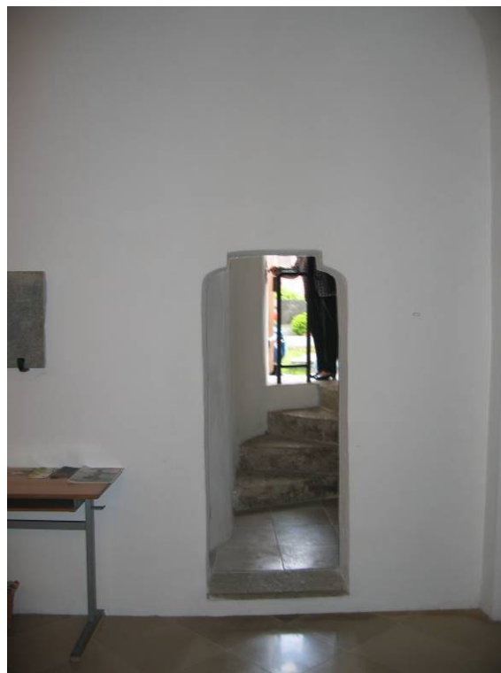
Abb. 88: Hollenburg - Treppenturm, Eingang
