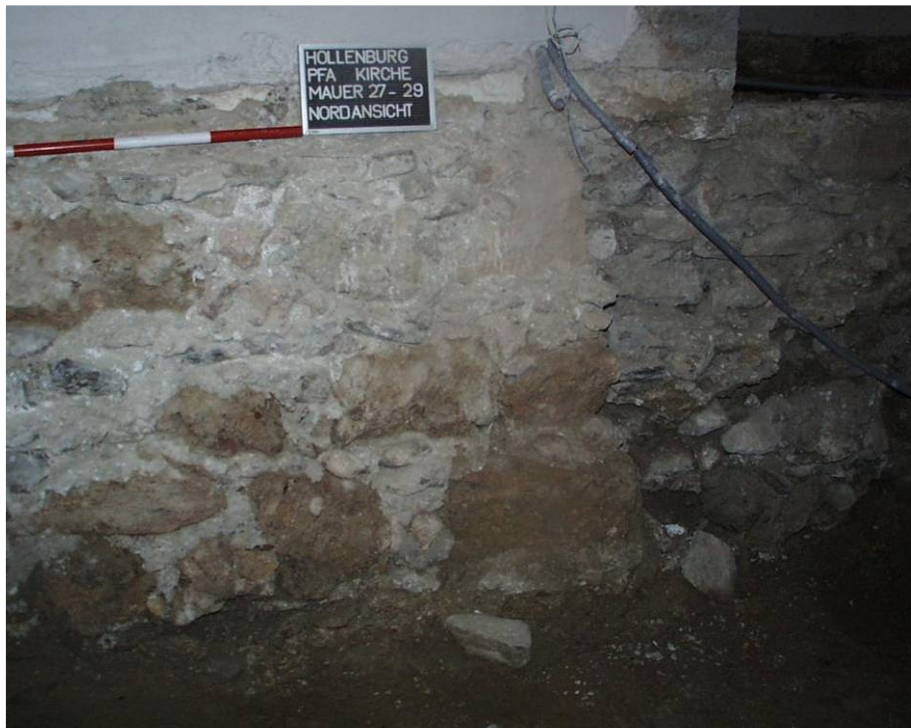
Abb. 245: Hollenburg - Langhaus, Mauer M27-29, Nordansicht 1
