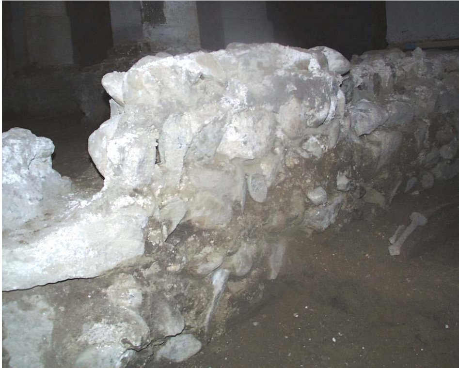
Abb. 247: Hollenburg - Langhaus, Mauer M21, Nordansicht 1
