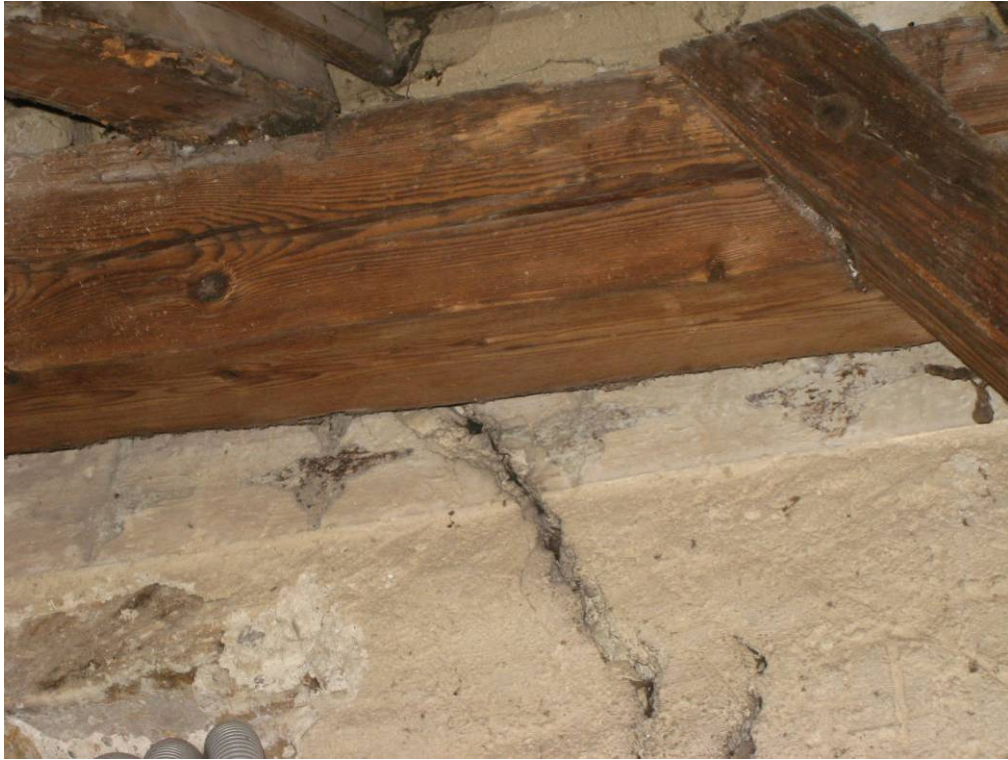
Abb. 173: Hollenburg - Sakristeidachraum, Chorwand, bemalte Putzfasche, schwarz Farbe
