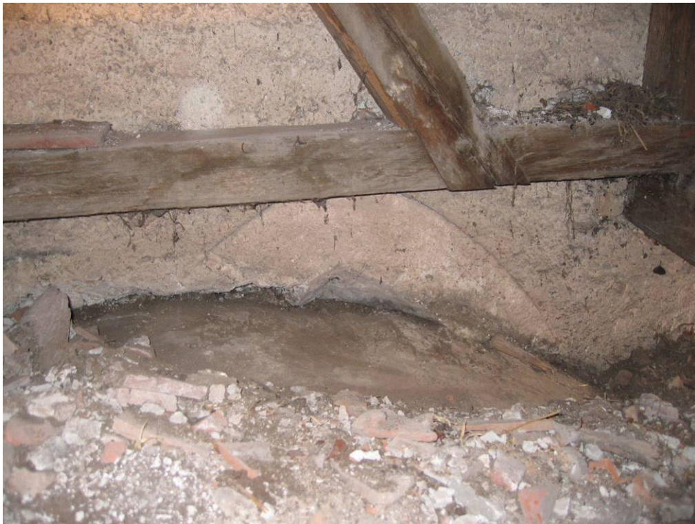
Abb. 170: Hollenburg - Sakristeidachraum, Chorwand, Spitzbogen, Detail
