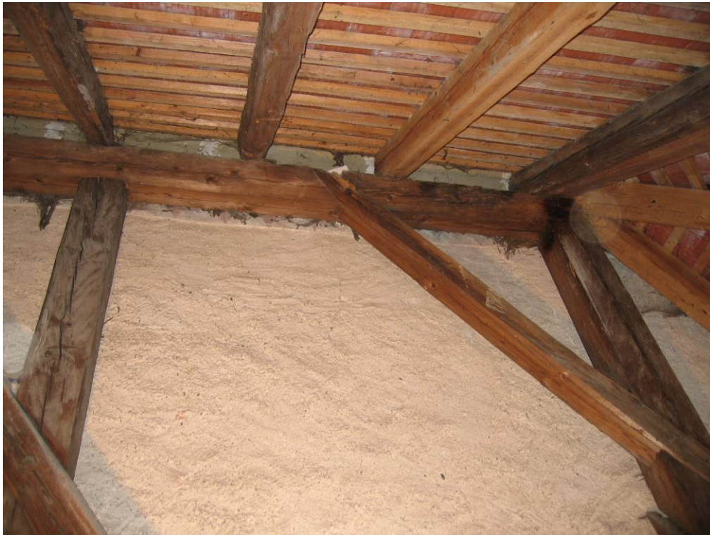
Abb. 171: Hollenburg - Sakristeidachraum, Chorwand, bemalte Putzfasche
