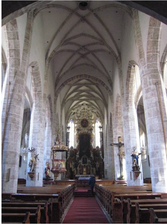
Abb. 227: Kilb - Netzrippengewölbe
