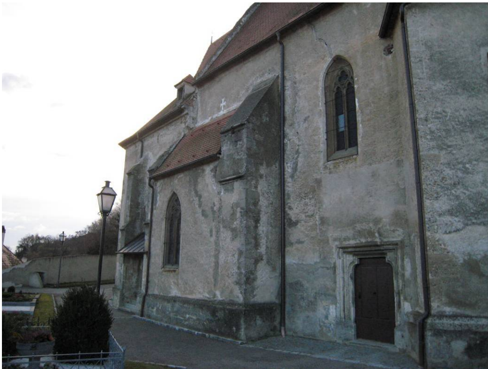
Abb. 44: Hollenburg - Langhaus, Nordansicht, Blick nach Osten
