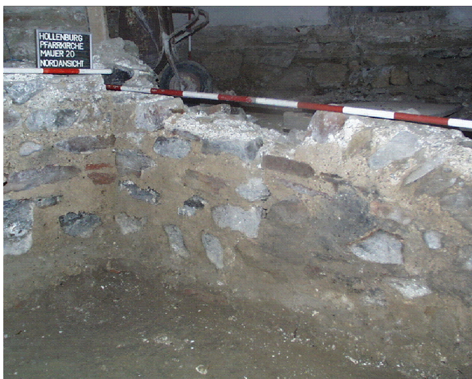
Abb. 236: Hollenburg - Langhaus Mauer M20, Nordansicht 1
