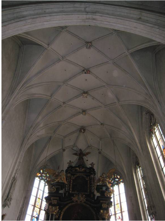
Abb. 217: Spitz - Chor, Netzrippengewölbe
