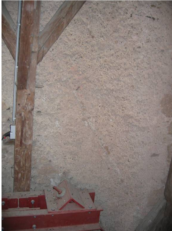
Abb. 127: Hollenburg - Turmostwand, Blick nach Westen, Dachabdruck, Ortganglinie
