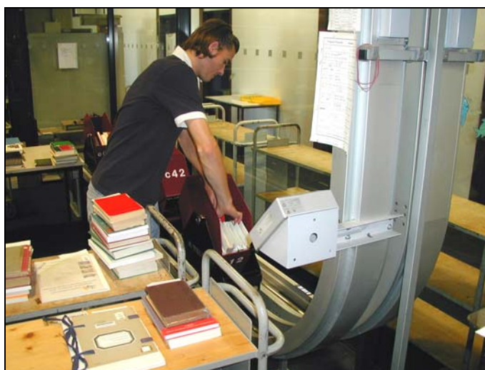
Zentrale Packstation an der Buchförderanlage
