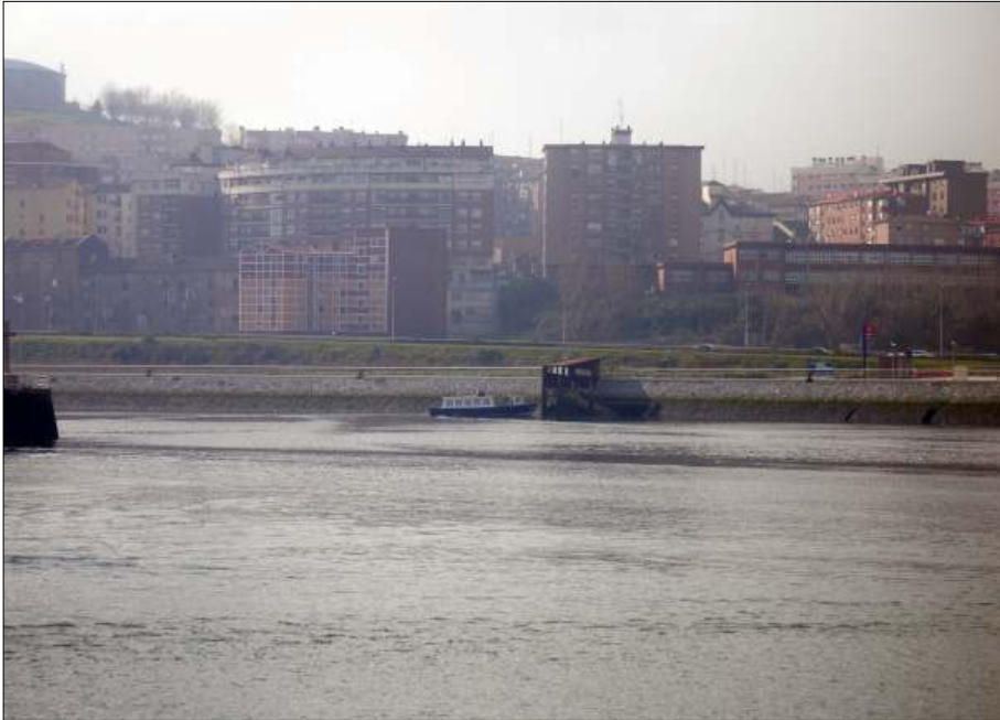
Vista de la línea de Erandio hacia el embarcadero de Barakaldo.
