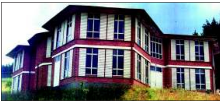
Antiguo Edificio del Centro Enseñanzas Artesanales. Polígono Agirretxe 1985. Archivo del Centro.
